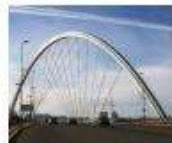
Puente Ramstore (KZ)
