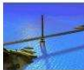
Puente Agin (TR)
