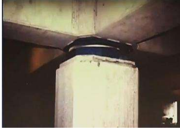
Figura 8. Ubicación de los Aisladores en la Interfaz de Aislación., en la parte superior de la columna.
