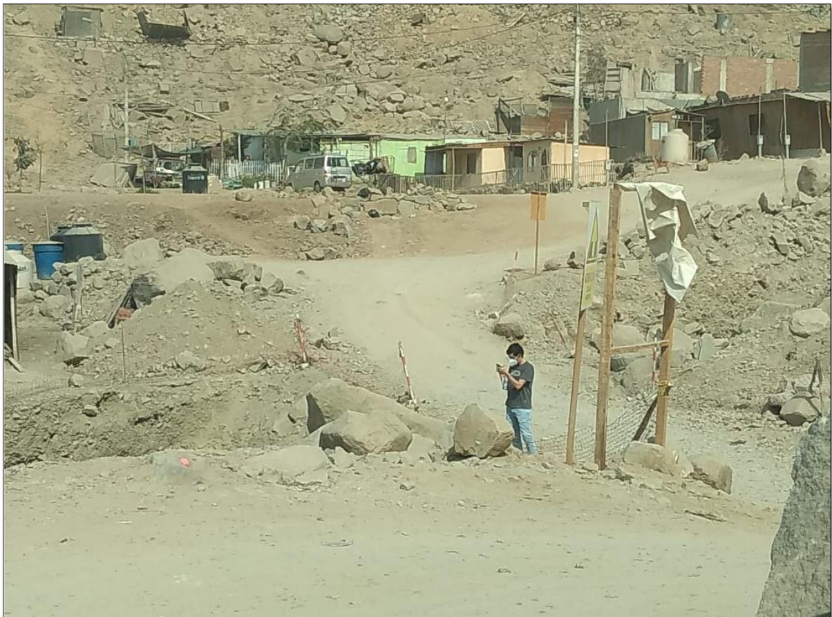
Foto 4 Viviendas en el cauce natural del Flujo de Detritos
