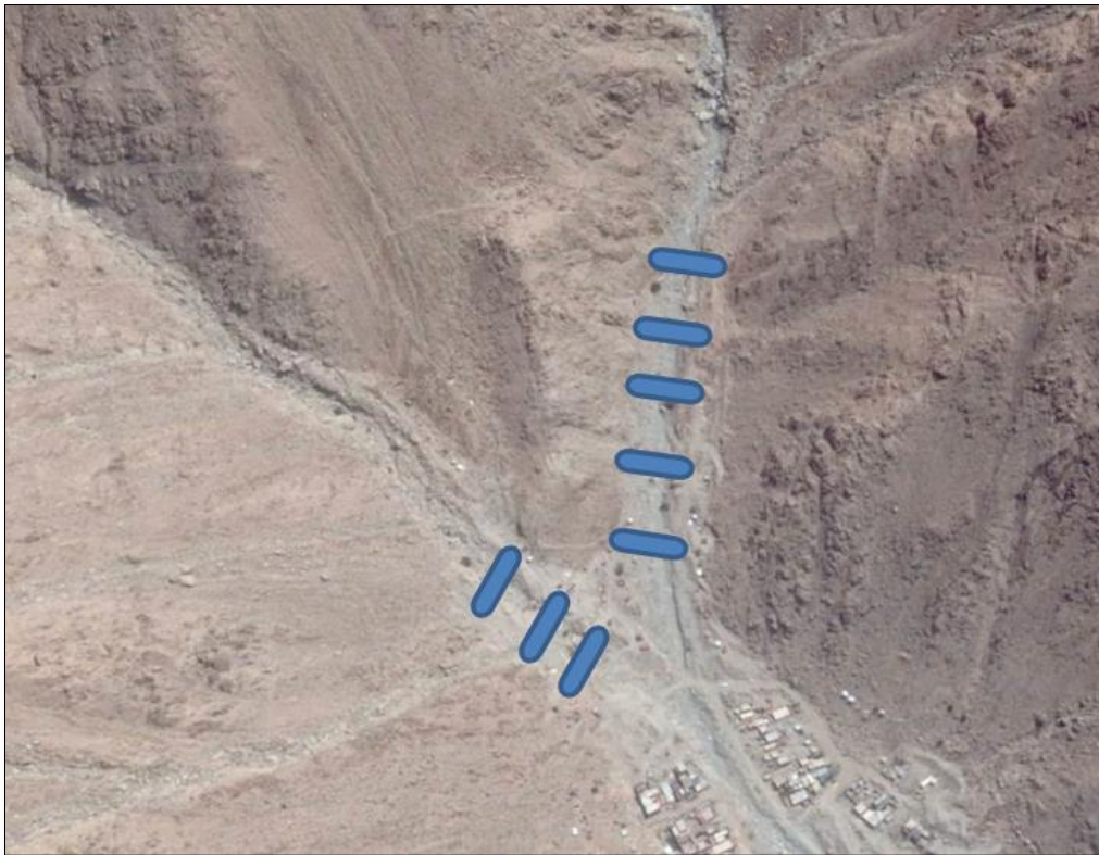
Foto 9 Ubicación en planta de los 8 diques Estos diques actualmente están colmatados y en mal estado de conservación.
