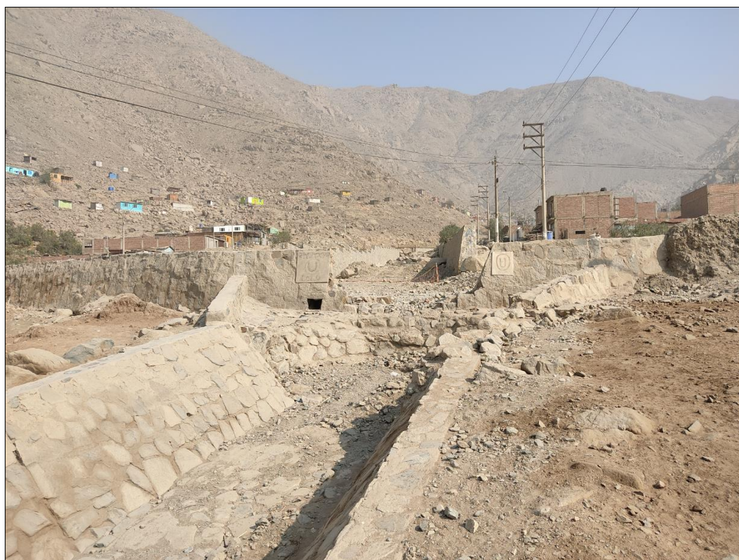
Foto 7 Canal Existente antes y después.
