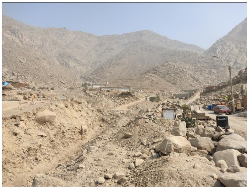
Foto 12 Laderas de las quebradas En la vista se observa la falta de la descolmatación y mantenimiento urgente de la quebrada, como las zonas de las laderas, este material es susceptible de arrastre y reactivación de la quebrada.
