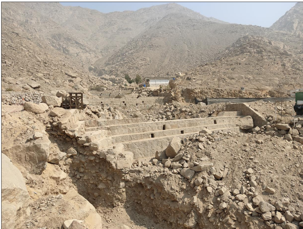
Foto 10 Zona alta de la Quebrada Se observa las laderas están constituidas por material residual coluvial rodados, material suelto tanto el fondo de la quebrada como en las laderas, este material es susceptible de arrastre al reactivarse la geodinámica externa en épocas de precipitación pluvial
