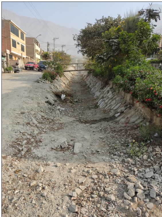
Foto 2: Canal Existente Av. Unión. Canal en pésimas condiciones, falta de una descolmatación.
