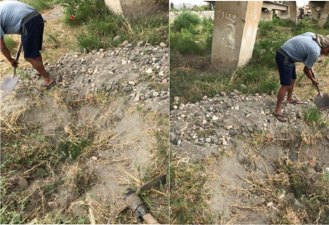
Figura III.35. Verificación de la no existencia de manto de escollera superficial.
