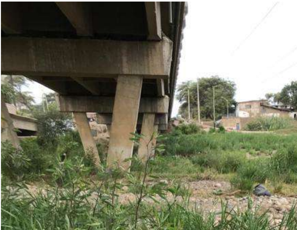
Figura IV.1. Vista de la altura de los pilares
