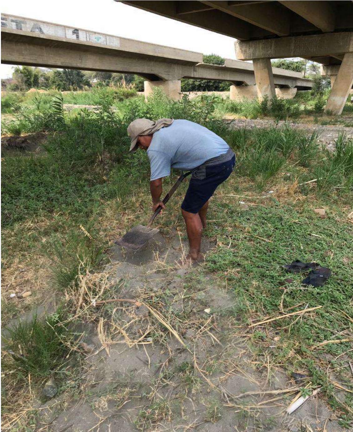
Figura 5. Excavación en el eje del puente
