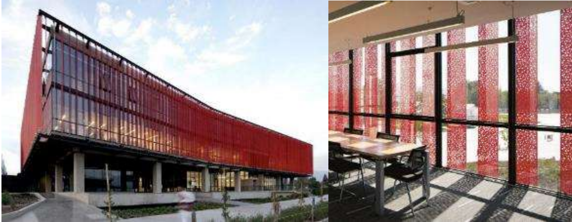
Figura 16: Vista exterior e interior de lamas – volumen administrativo
