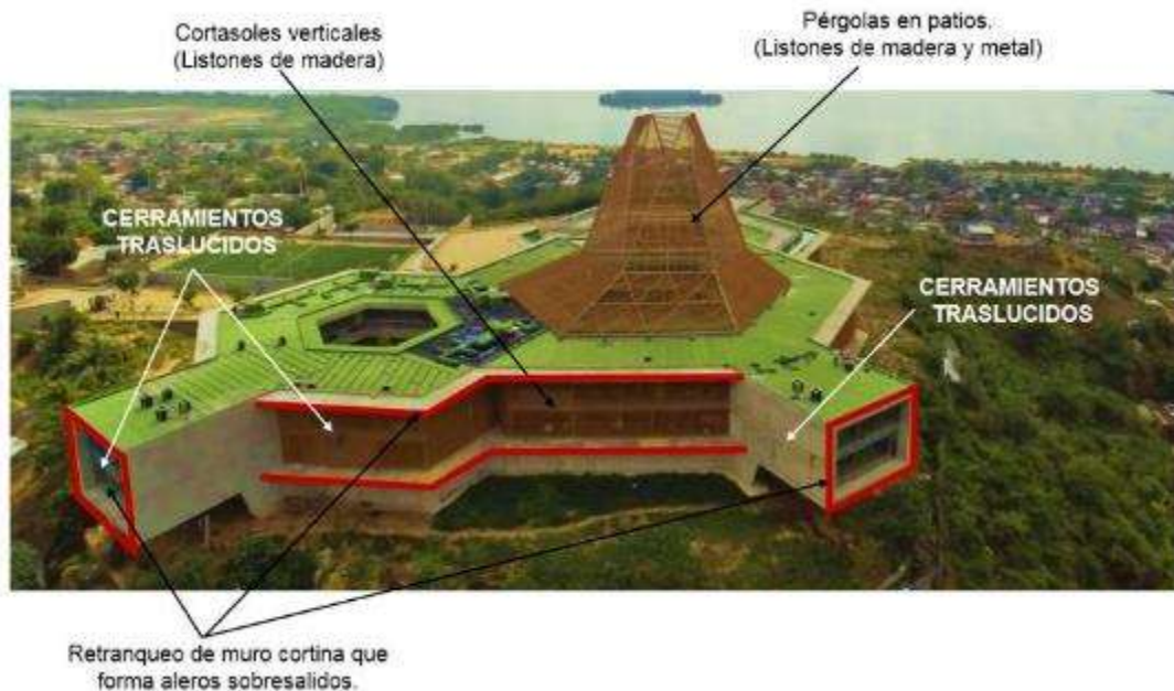
Figura 13: Análisis de la dimensión de estrategias de diseño arquitectónico pasivo del Colegio Pies Descalzos, Colombia - Fuente: Elaboración propia
