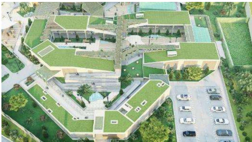
Figura 57. Vista a vuelo de pájaro del nuevo CITE de vino en Cascas 4
