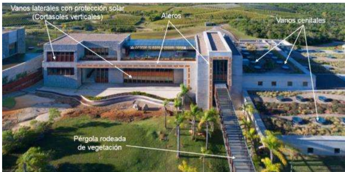
Figura 22: Análisis de la dimensión de estrategias de iluminación natural de la Bodega Garzón, Uruguay
