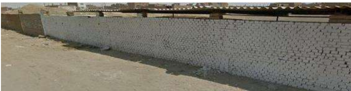
Imagen del 3° terreno - Vista lateral Izquierdo. FIGURA N° 40 - Elaboración propia.
