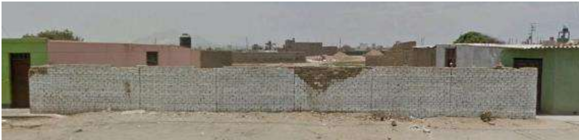
Imagen del 1° terreno - vista lateral izquierdo. Bolívar. FIGURA N° 33 - Elaboración propia.
