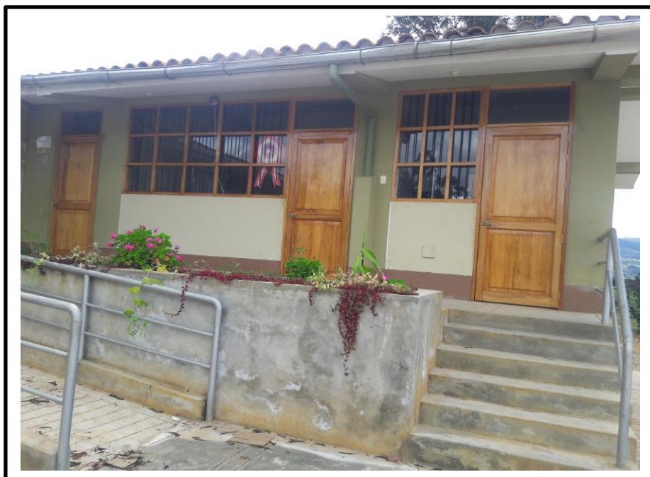
Figura 8: Mejoramiento del servicio en la institución educativa secundaria de menores en Shitamalca, San Marcos _ Cajamarca _ SNIP 329561
