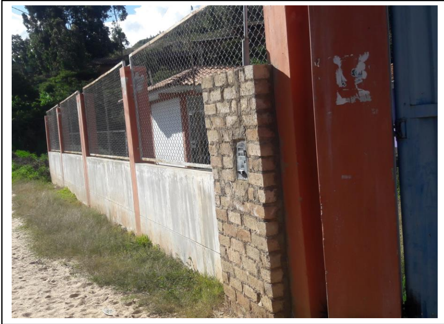
Figura 2: Construcción muro perimétrico PRONOEI El Gallito, San Marcos _ Cajamarca _ SNIP
