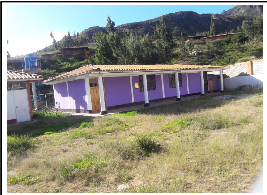
Figura 3: Construcción local PRONOEI El Gallito, San Marcos _ Cajamarca _ SNIP
