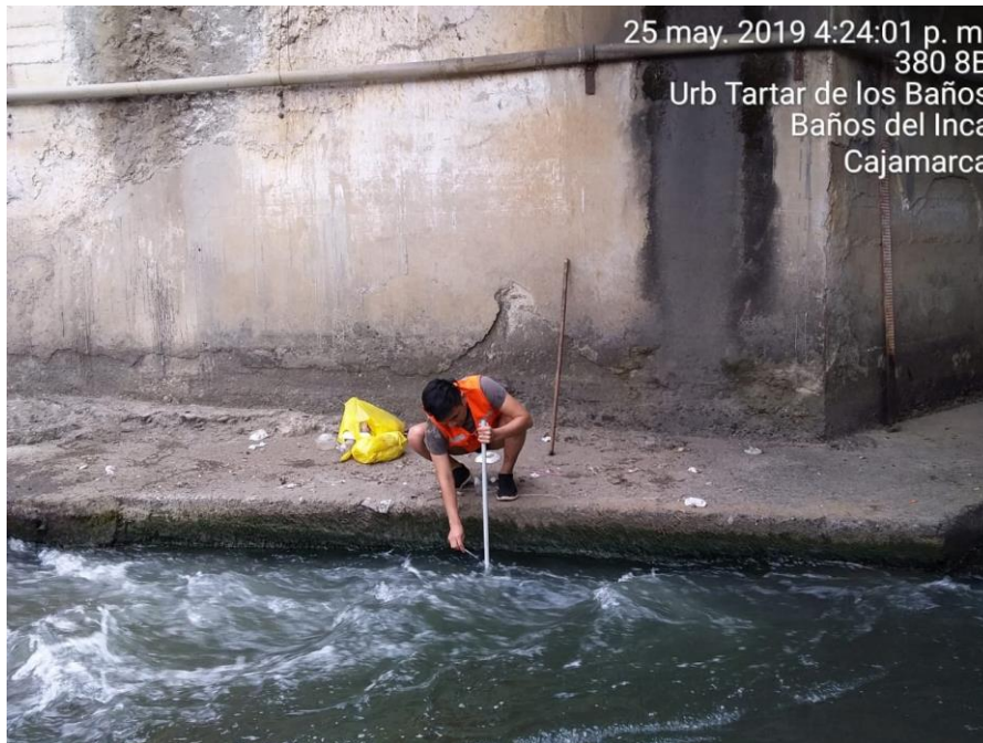
Figura 6. Medición de la socavación en campo
