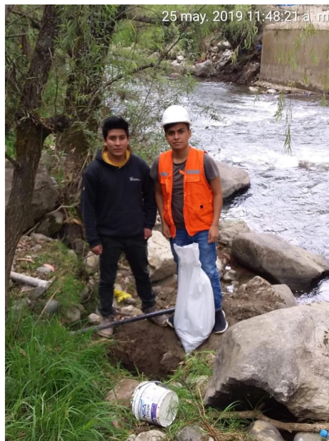
Figura 3. Calicata Correspondiente al Puente Rinconada
