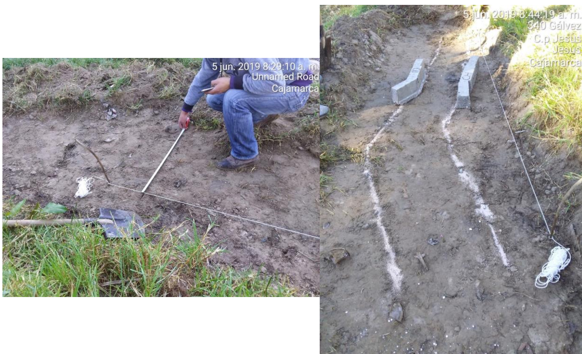
Figura 60. Replanteo para modelamiento
