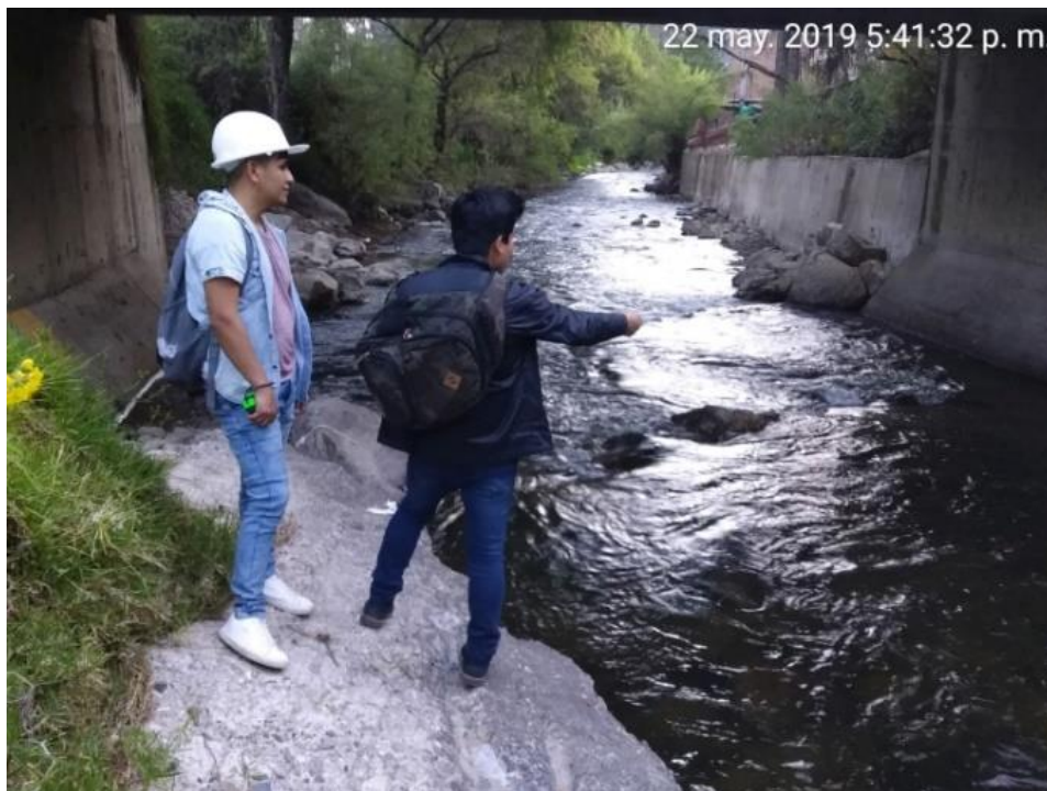
Figura 1. Vista general del Puente Rinconada
