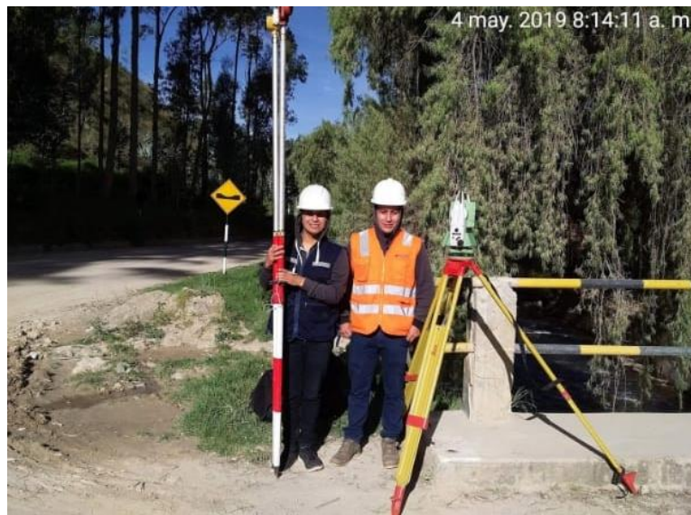
Figura 4. Inicio de Levantamiento Topográfico en el Puente Rinconada
