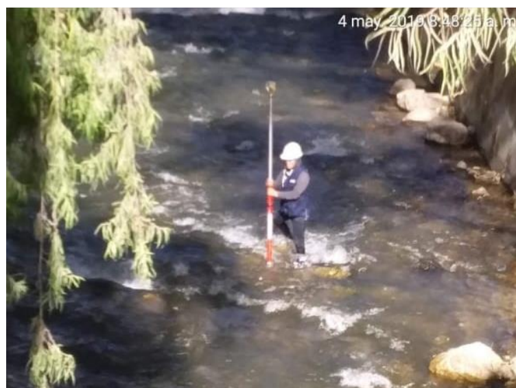
Figura 5. Levantamiento Topográfico en el Puente Rinconada
