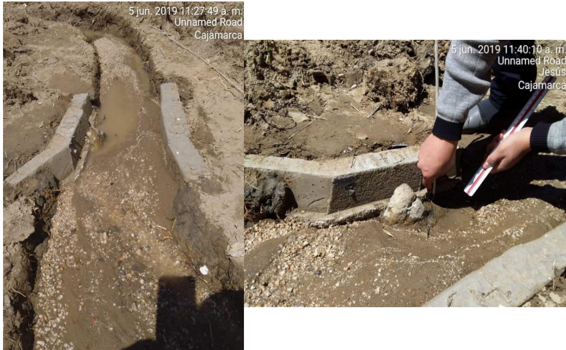
Figura 64. Medición de la socavación en el modelo.
