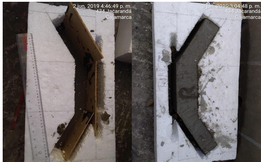
Figura 59. Elaboración de estribos
