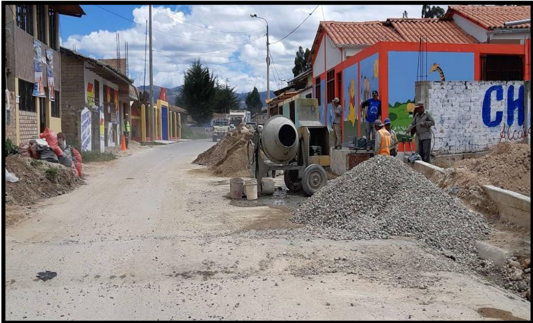
FOTOGRAFÍA 13: Agregado fino y grueso, utilizados para construcción, dentro del carril izquierdo y derecho
