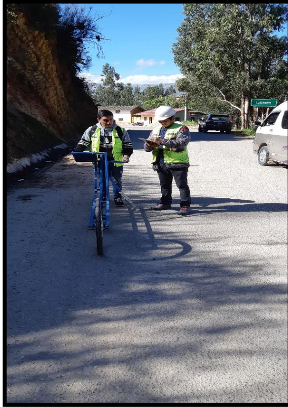
FOTOGRAFÍA 6: Inicio de toma de datos con el rugosímetro MERLIN, Carril Izquierdo.
