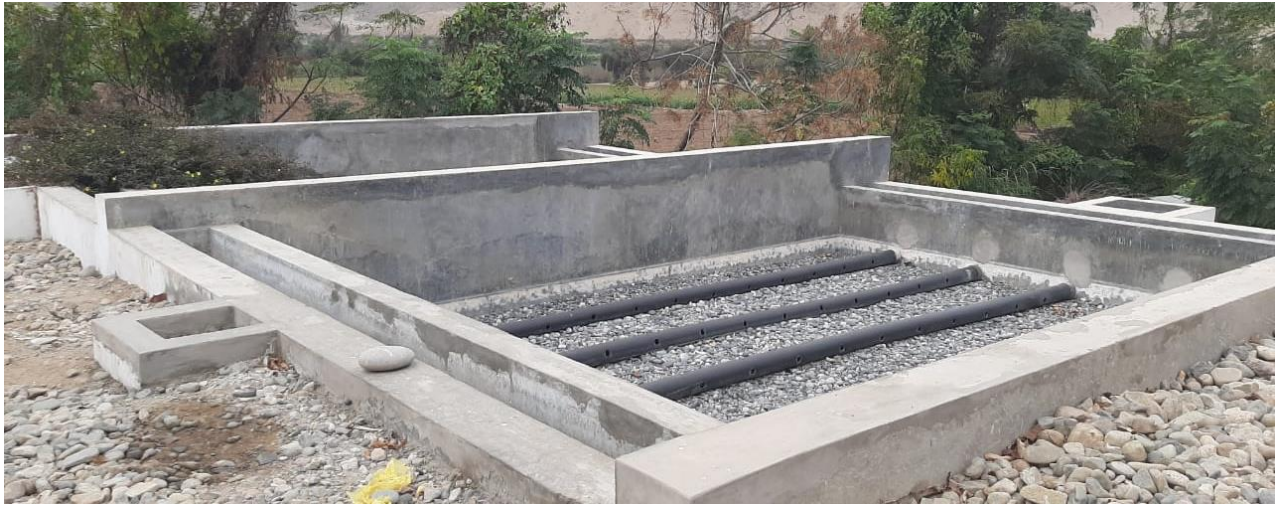
Figura 22. Filtros Biológicos de la Planta de Tratamiento de aguas residuales.
