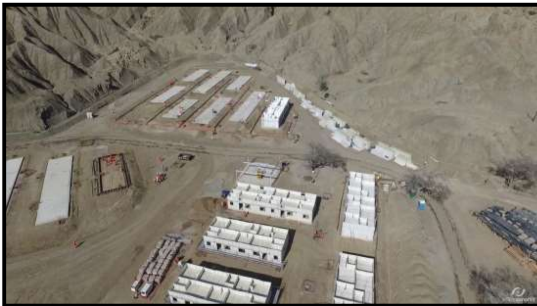
Instalación de Paneles Emmedue – Refinería Talara
