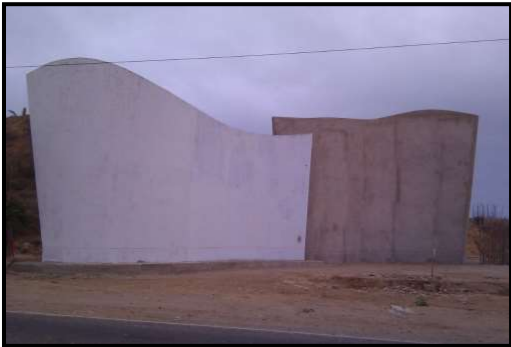
Pintado de Fachada de los Condominios Cabo Merlín
