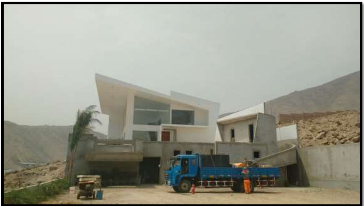
Construcción de vivienda Unifamiliar – La Molina
