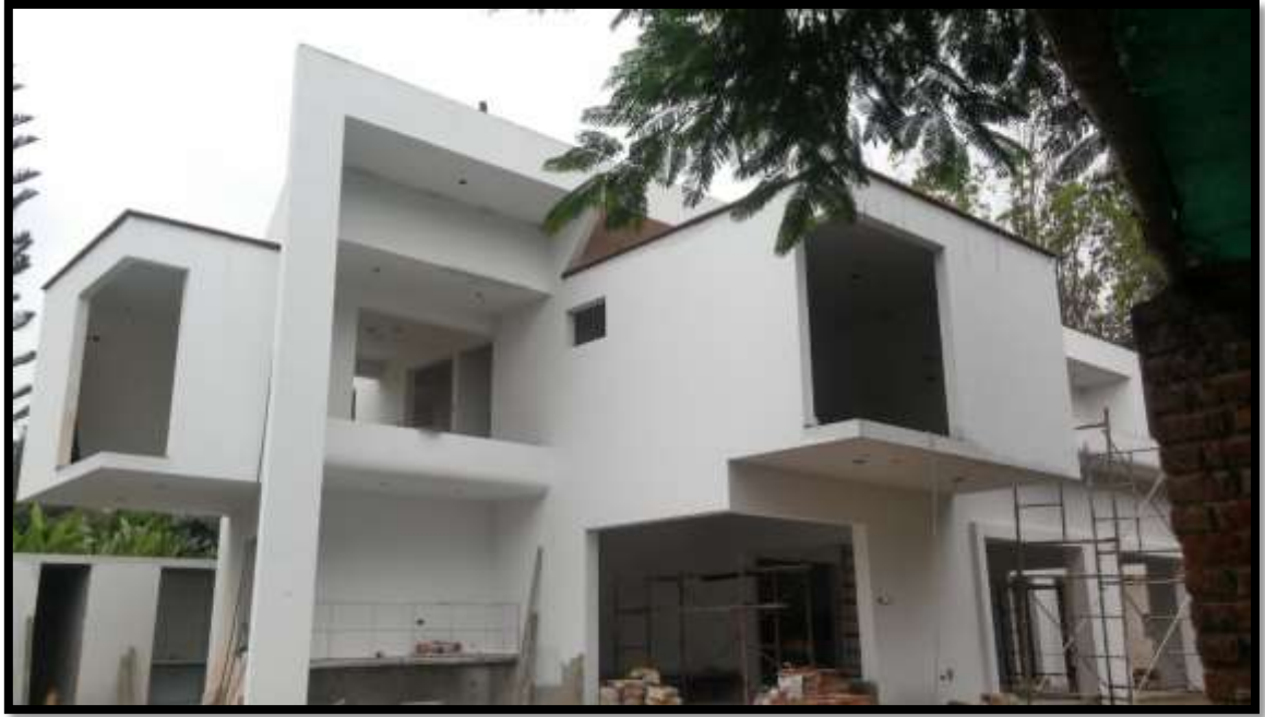
Construcción Casa de campo – Pachacamac
