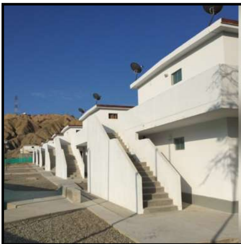
Construcción Terminada – Refinería Talara
