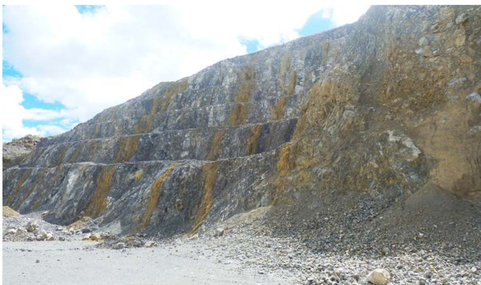
Fotografía 3.20 Áridos Pampamarca II, vista mirando al NO
