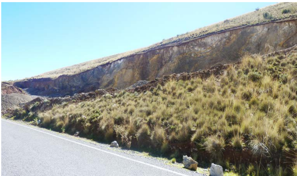
Fotografía 3.18 Áridos Tungasuca, vista mirando al NE
