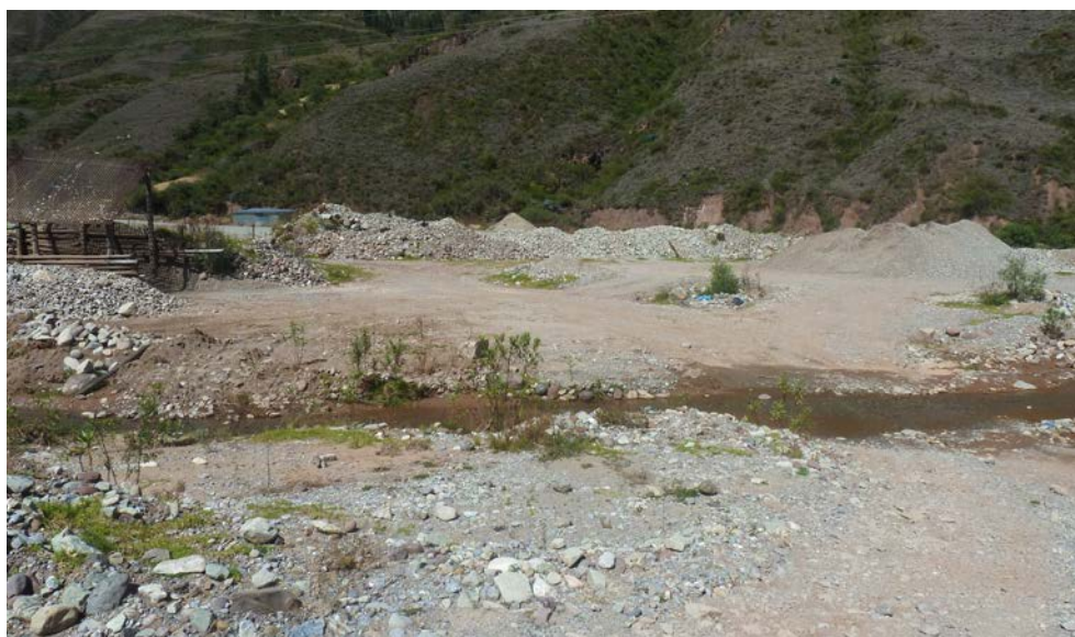
Fotografía 3.2 Áridos Acos, vista mirando al sur
