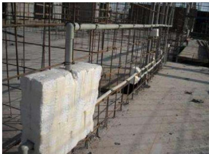
*Figura 8.* Armado de refuerzo, mallas colocación de tuberías.
