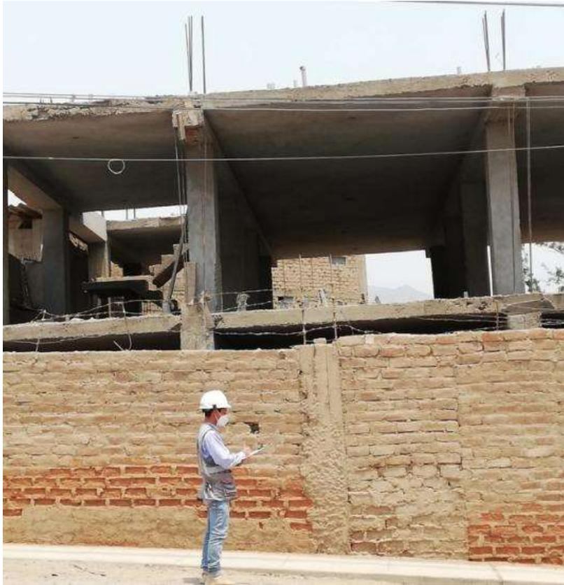
Se observa que no se encuentra nivelado los techos y las paredes
