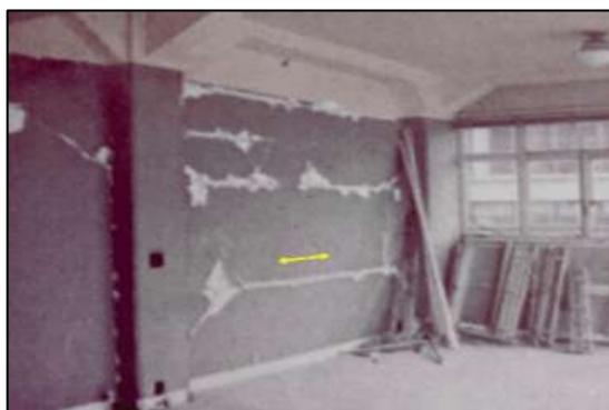
*Figura 36.* Falla por cizalle.
