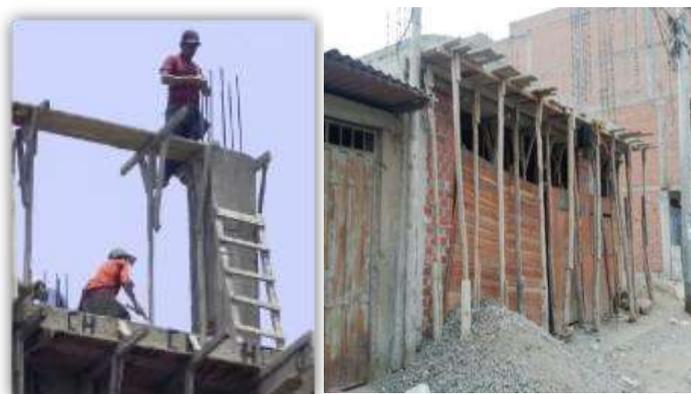
*Figura 13.* Falta de seguridad de los trabajadores de la obra
