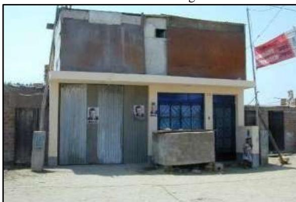
*Figura 32.* Vivienda con tarrajeo de muros y construcciones provisionales en el segundo piso.
