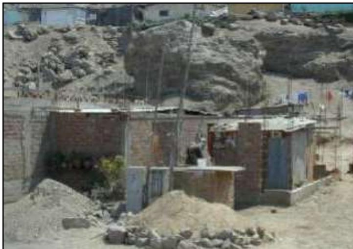
*Figura 30.* Elaboración de cimientos y algunos muros y columnas realizado por el mismo propietario.
