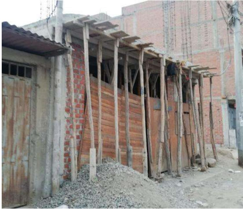
*Observación de desmonte y mal diseño de mescla*
