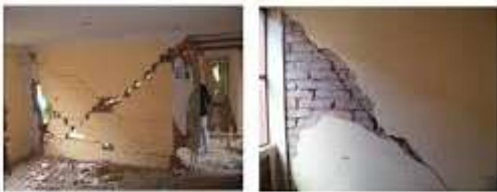
*Figura 35.* Falla por tracción diagonal.
