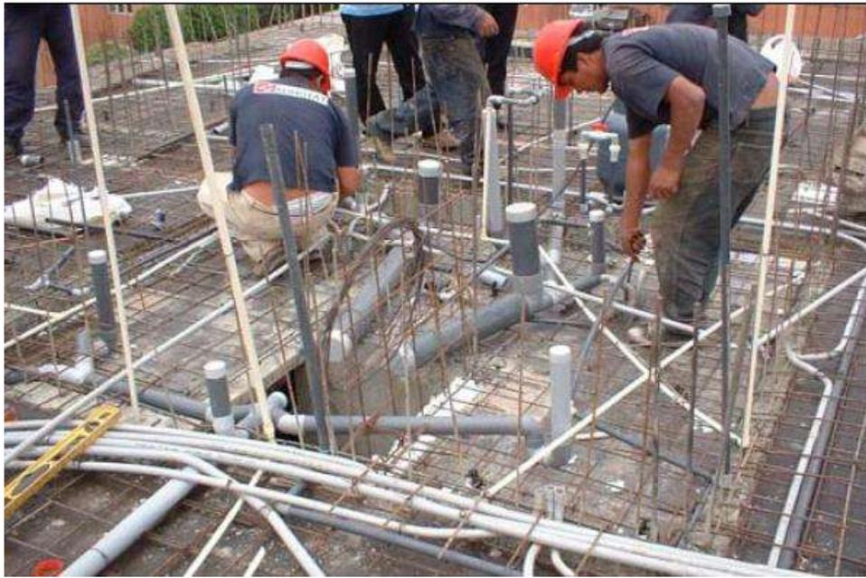
*Figura 9.* Armado de refuerzo, mallas colocación de tuberías.
