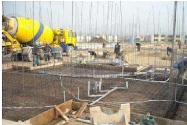
*Figura 6. Vaciado de losa.*
