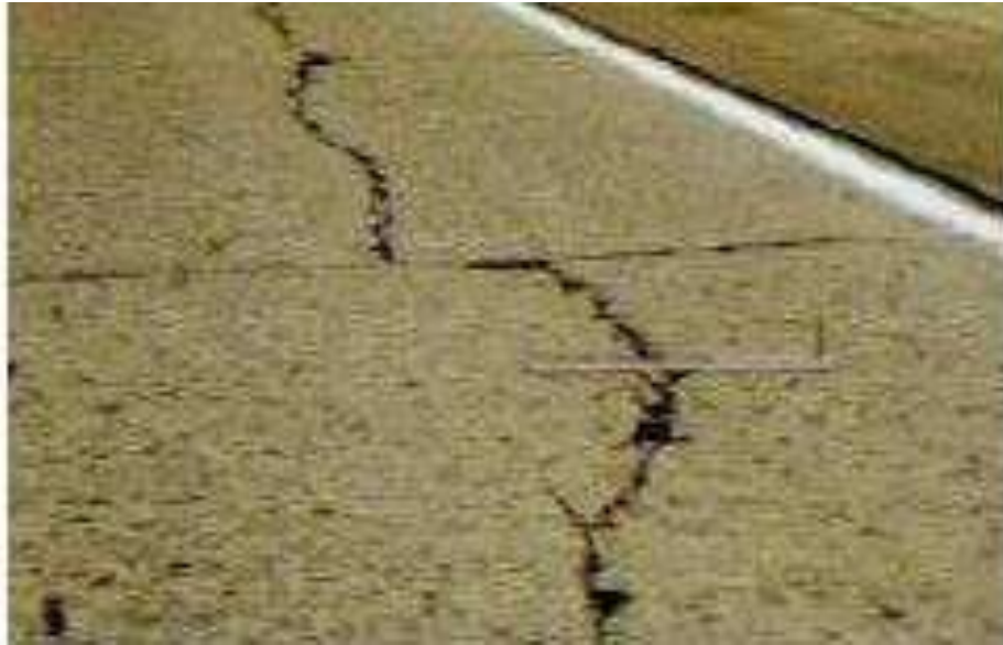
Figura 18 Fallas longitudinales
