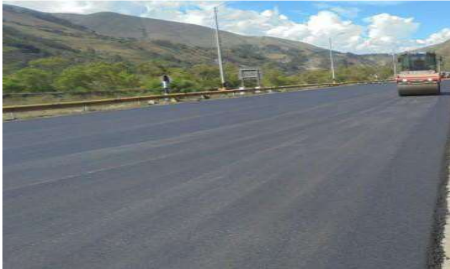
Figura 5 Acabado de una vía asfaltada
