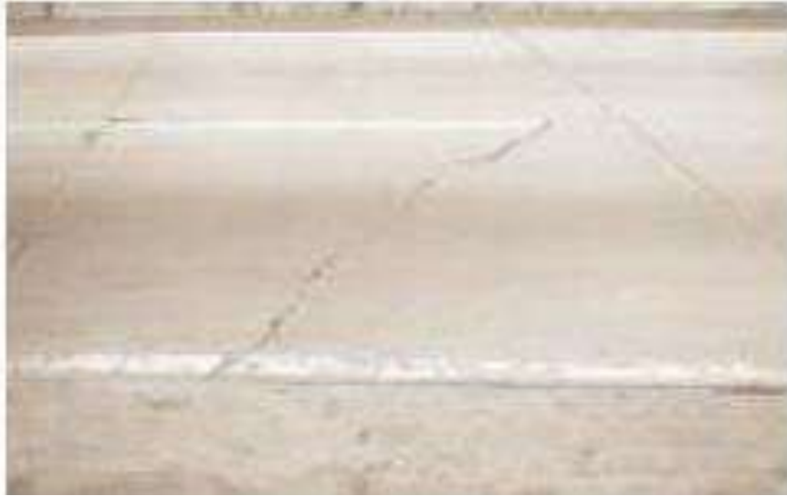
Figura 19 Fallas transversales
