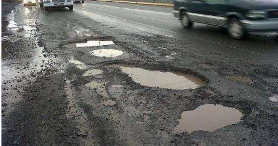
Figura 16 Presencia de baches en las vías
