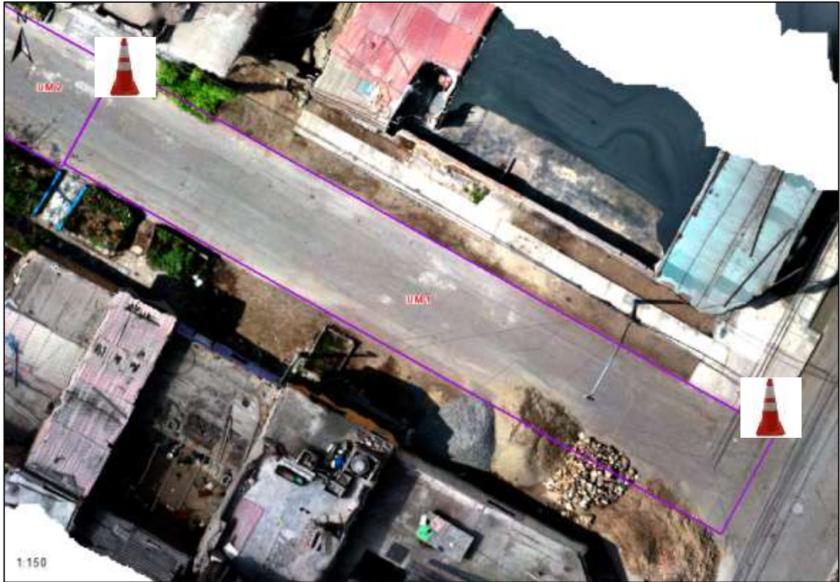
Figura 24. Cierre parcial de la vía utilizando conos de seguridad para la medición de fallas.
