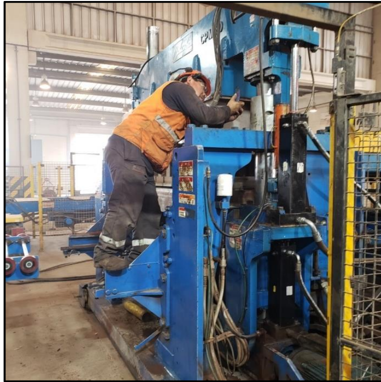
Figura 47. Trabajo correctivo CPM 60.
