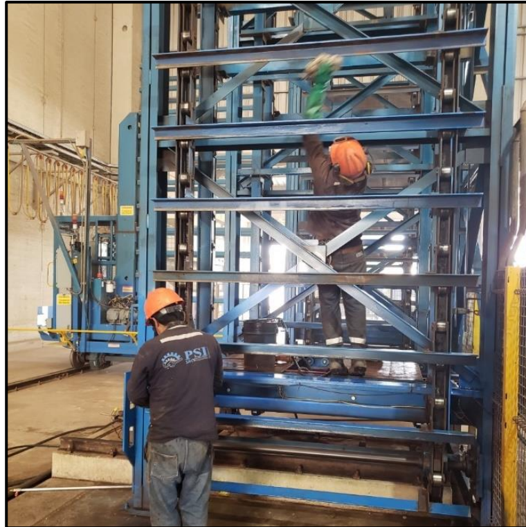
Figura 53. Limpieza y verificación de estructura de la torre de descarga del PTS.
