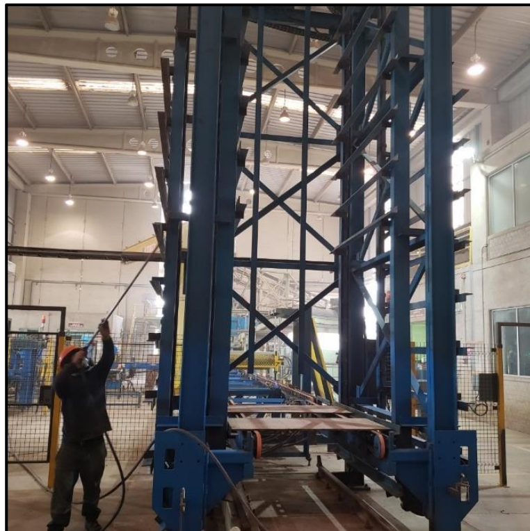
Figura 52. Limpieza y verificación de estructura de la torre de carga PTS.
