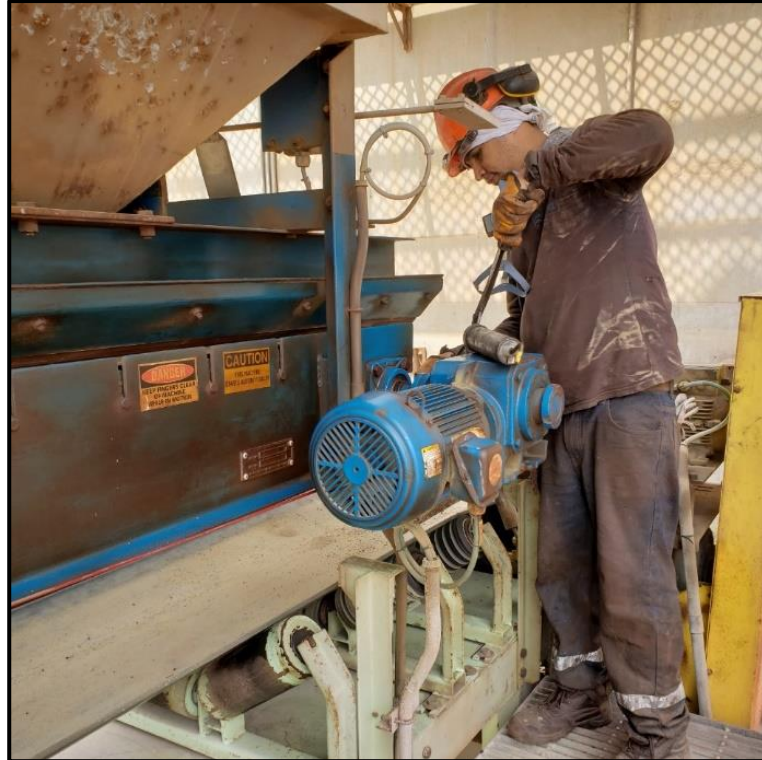
Figura 51. Inspección a la balanza de cementos de la mezcladora.
