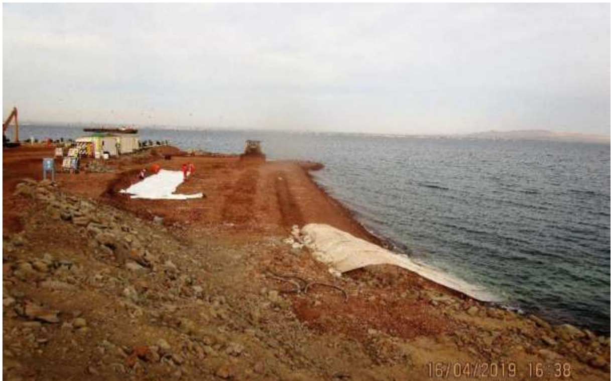
Figura 19. Trabajos para Instalación de Colchaceto. Fuente: Propia
