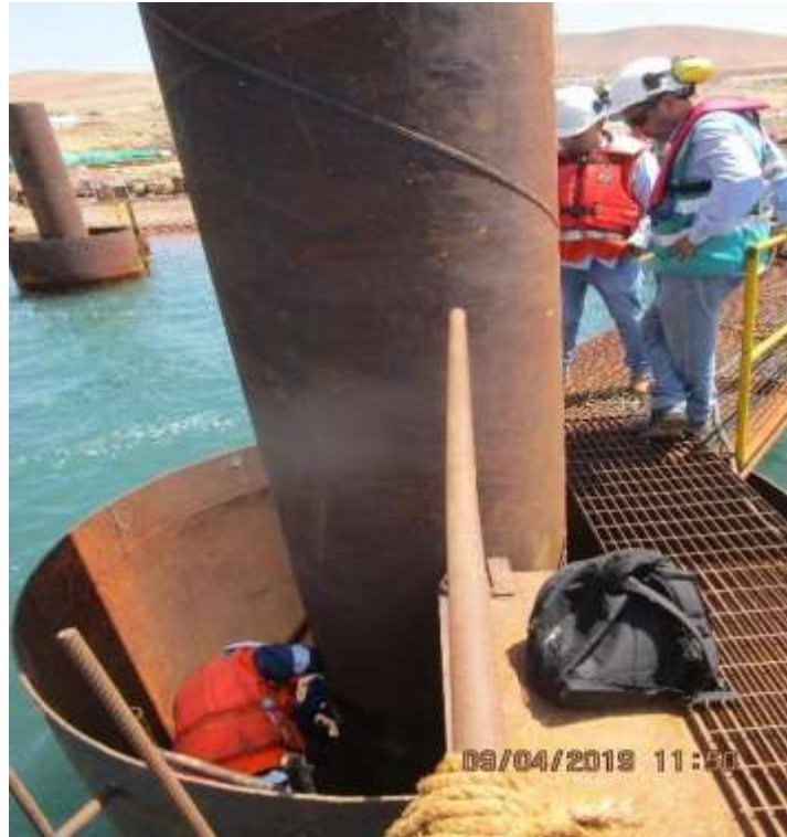
Figura 43. Prueba de Ultrasonido de Soldadura de Empalmes de Pilotes. Fuente: Propia
