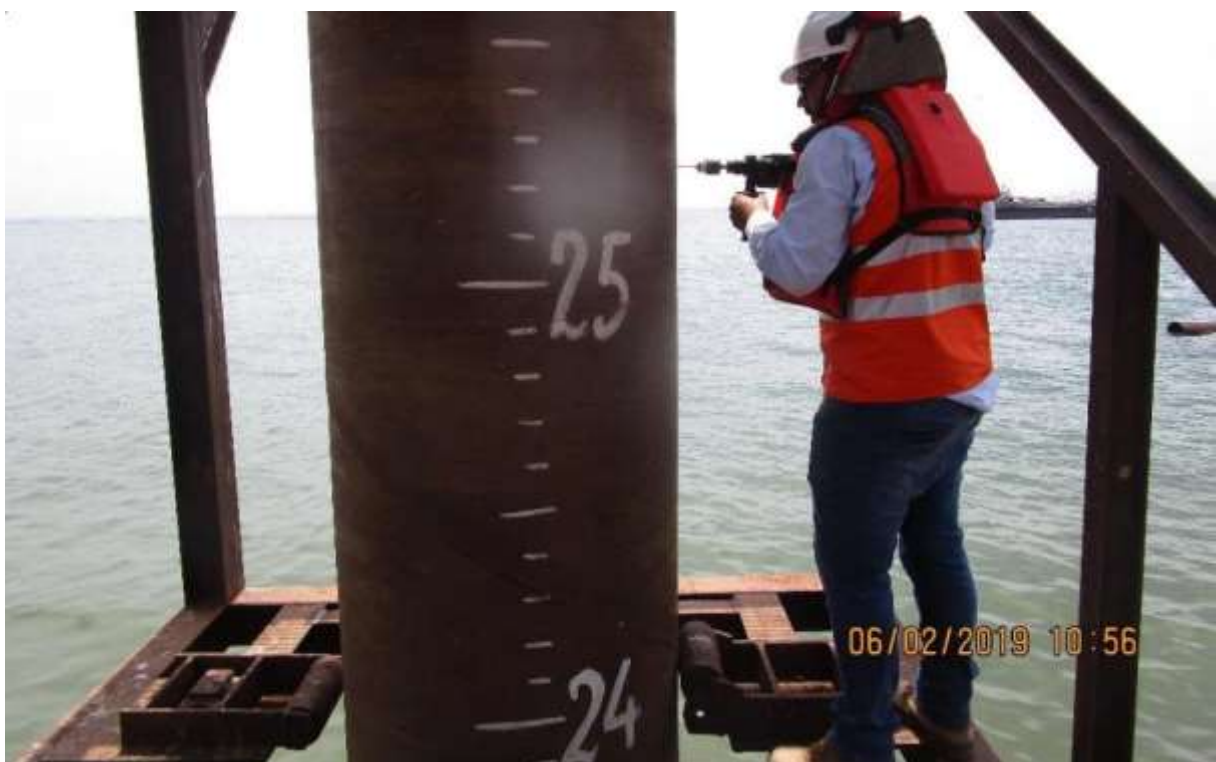
Figura 40. Prueba PDA en Pilote Permanente. Fuente: Propia
