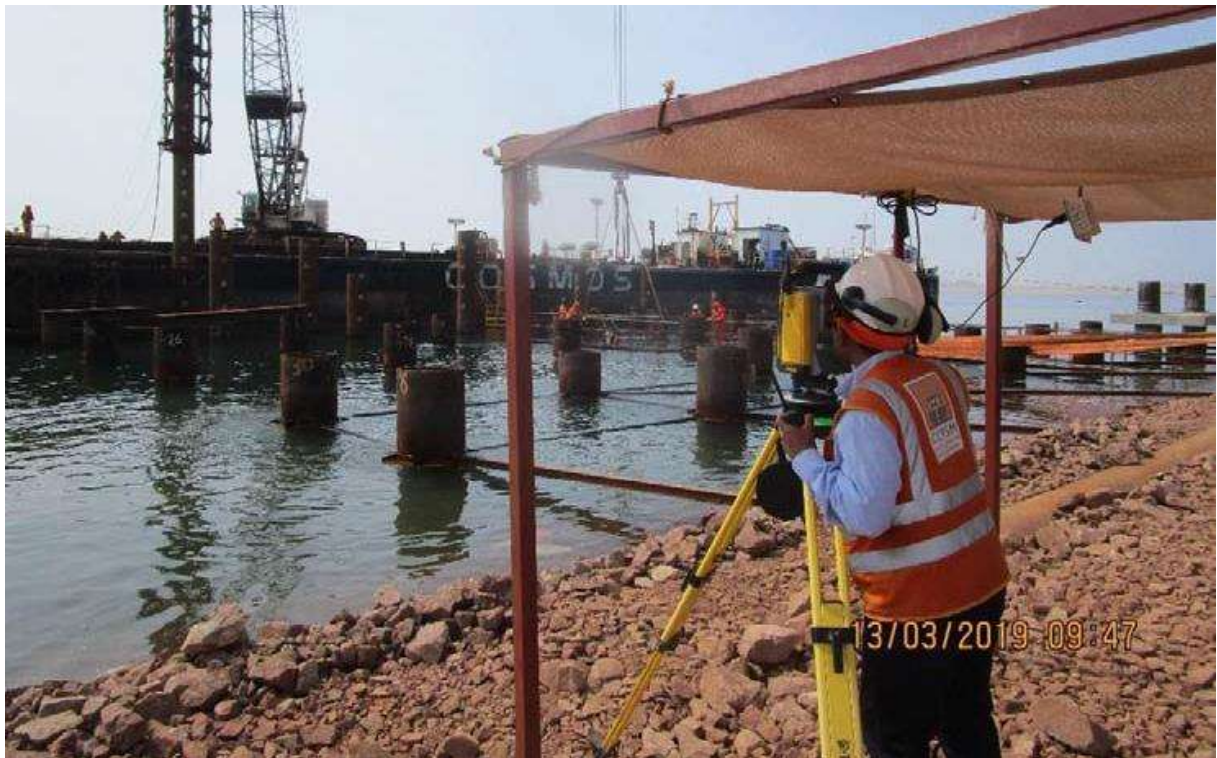
Figura 35. Monitoreo de hincado de pilotes. Fuente: Propia
