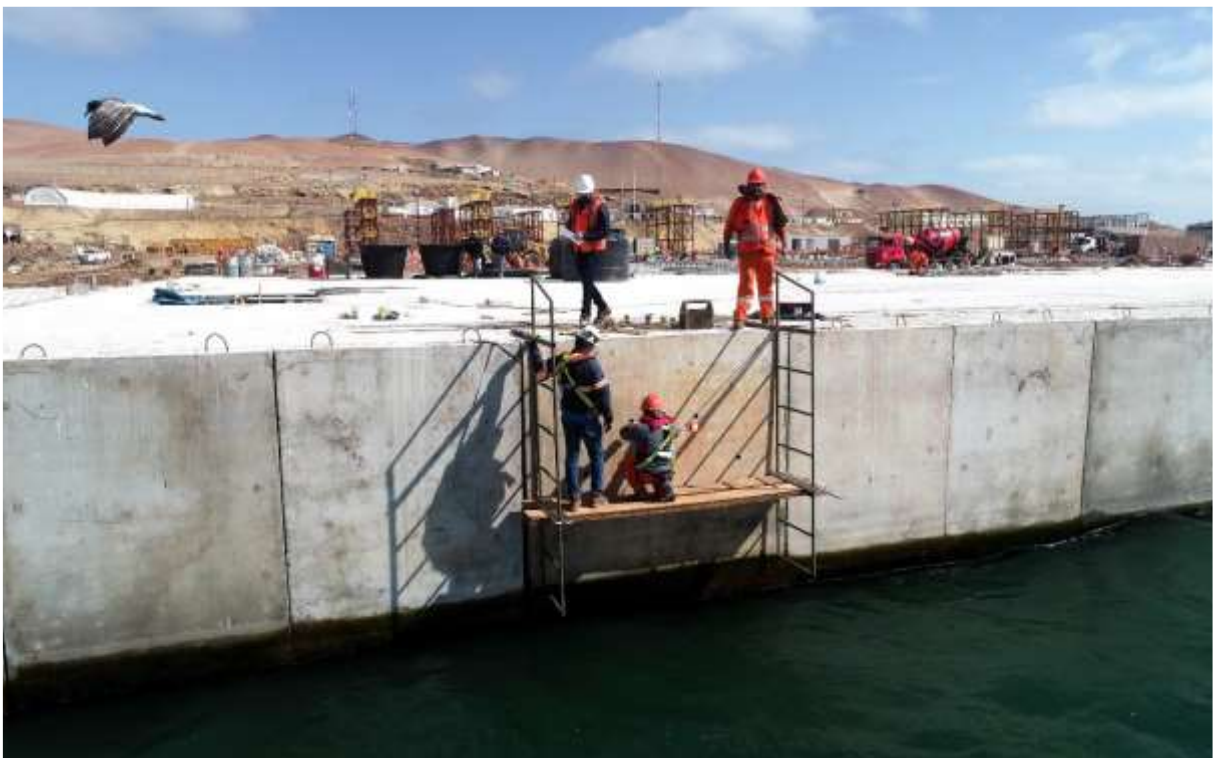
Figura 77. Trabajos de Colocación de Pernos Fuente: Propia
