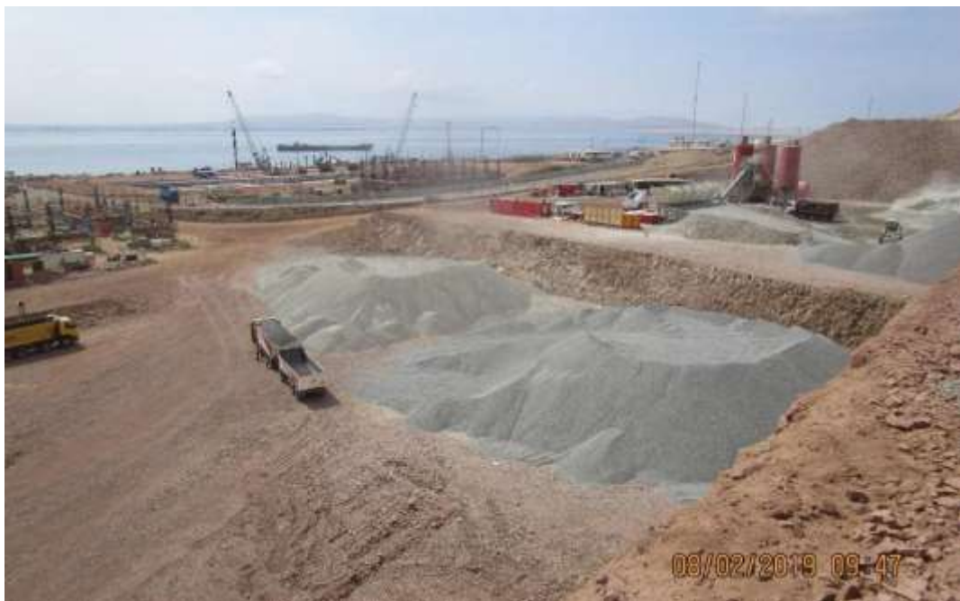
Figura 52. Acopio de Agregados para Concreto de Prefabricados Fuente: Propia
