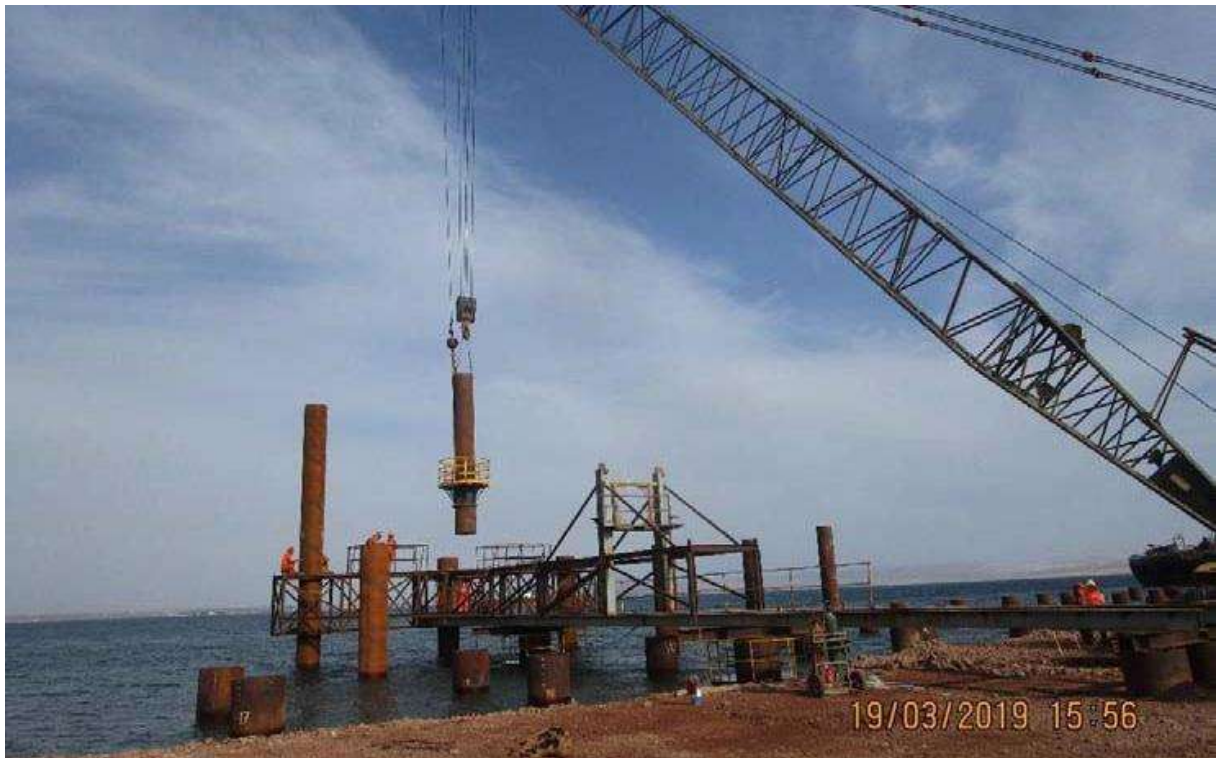
Figura 37. Corte de Pilotes Fuente: Propia
