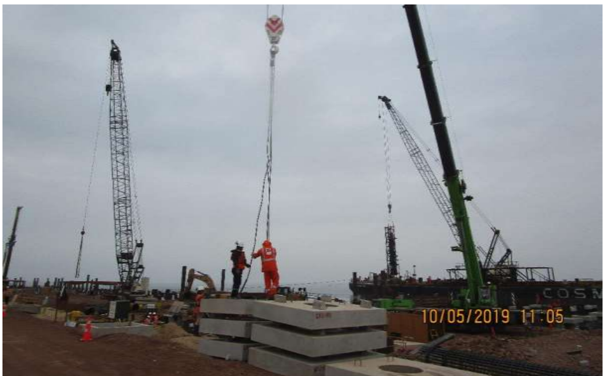
Figura 48. Trabajos de Montaje de Capiteles en Muelle.
