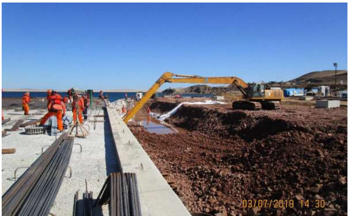
Figura 64. Vista de Trabajos de Excavación en Zona de Muelle Fuente: Propia
