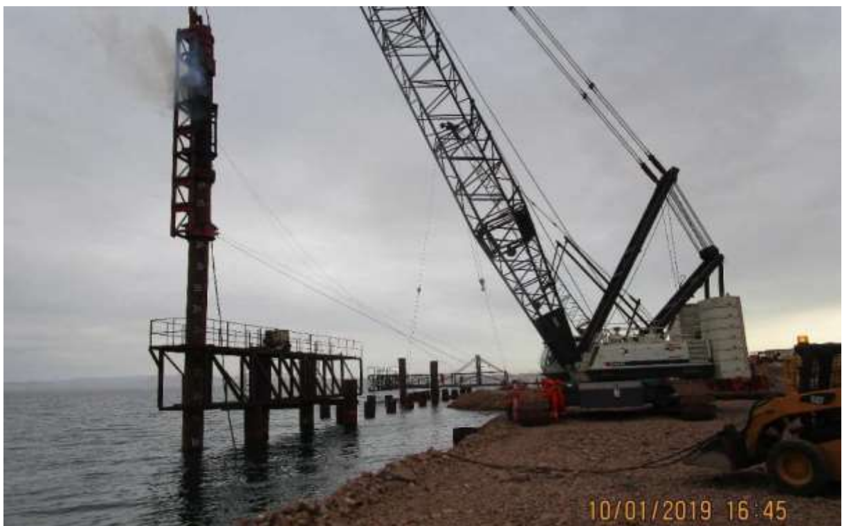
Figura 26. Hincado de Pilotes Fuente: Propia
