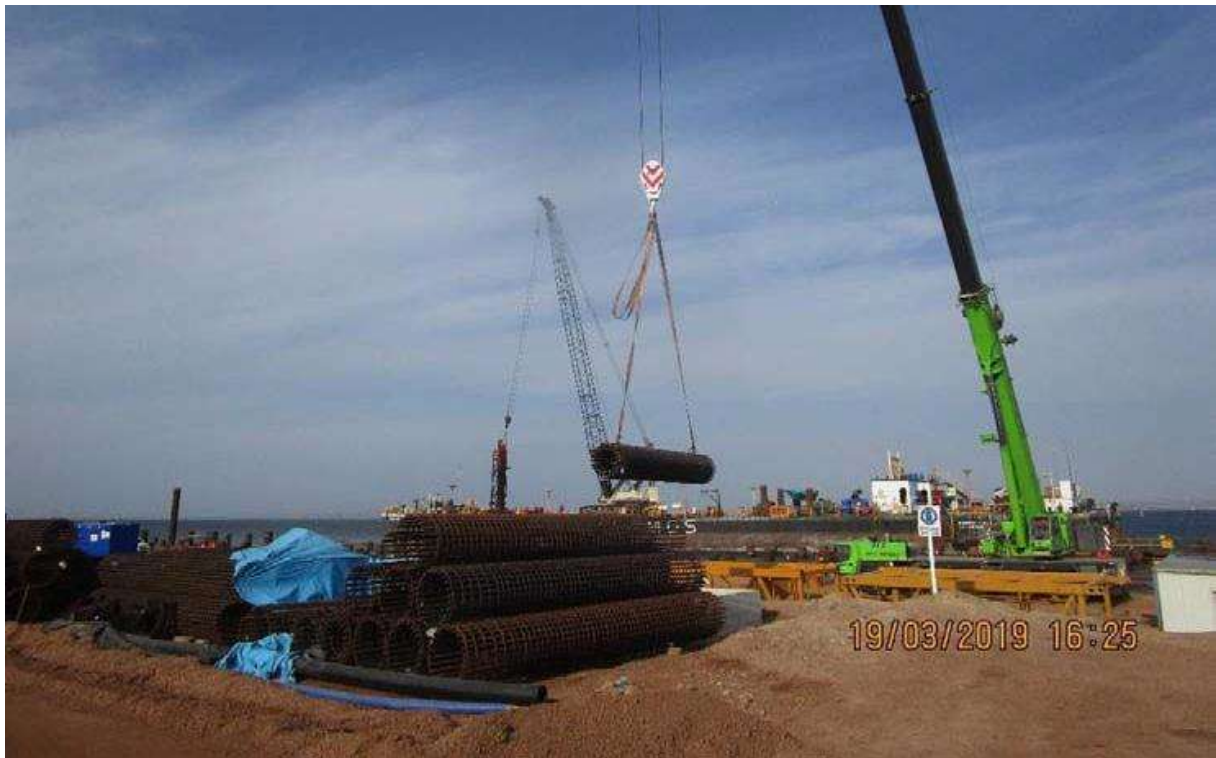
Figura 41. Instalación de Armadura en Pilote. Fuente: Propia
