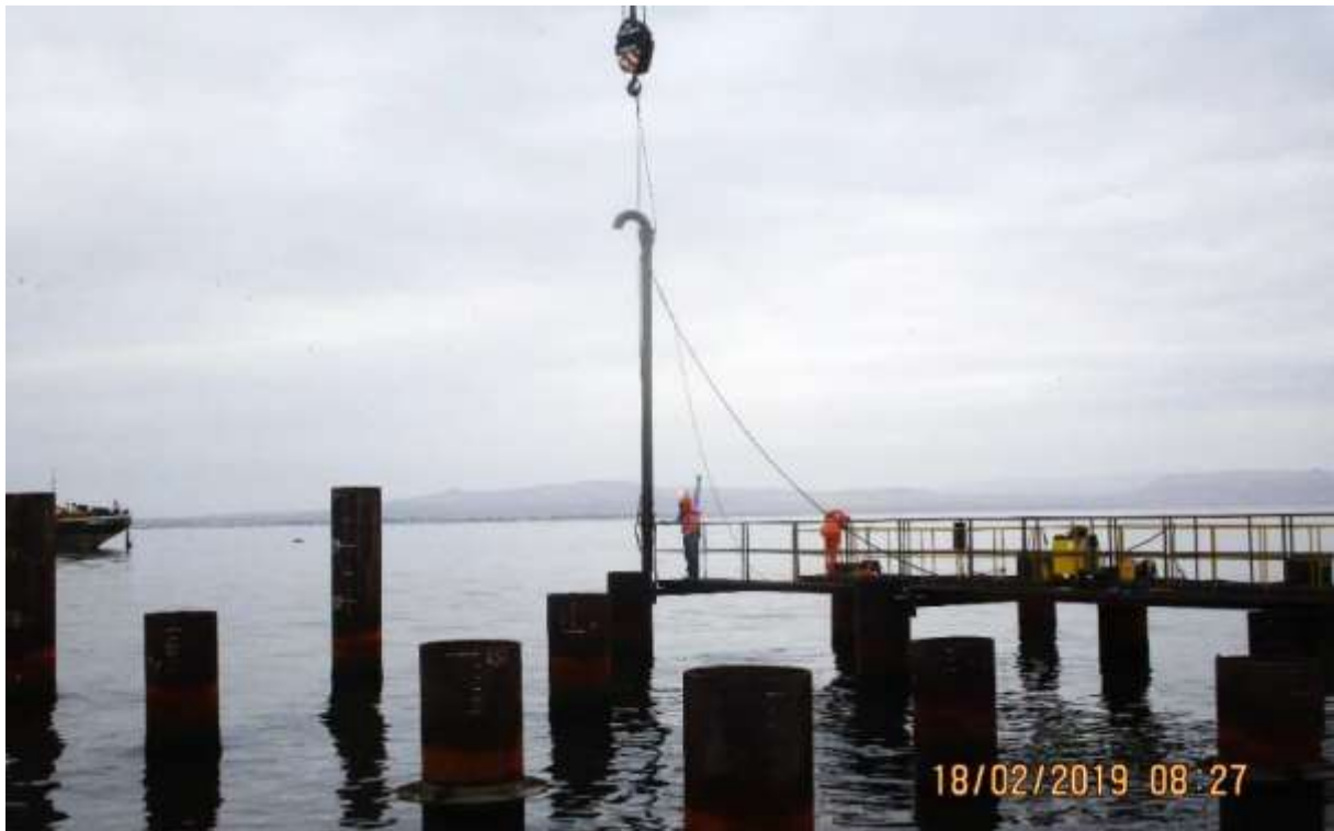
Figura 39. Colocación de Tubería para Retiro de agua del Pilote Fuente: Propia
