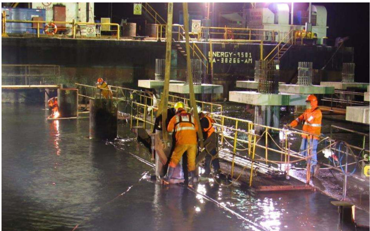
Figura 32. Alineamiento de Pilotes en Zona de Muelle. Fuente: Propia
