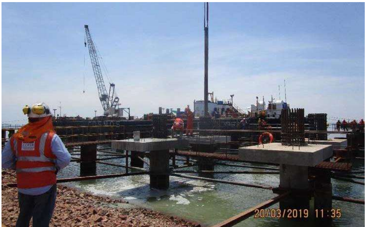
Figura 44. Vaciado de Concreto en Pile Plug. Fuente: Propia
