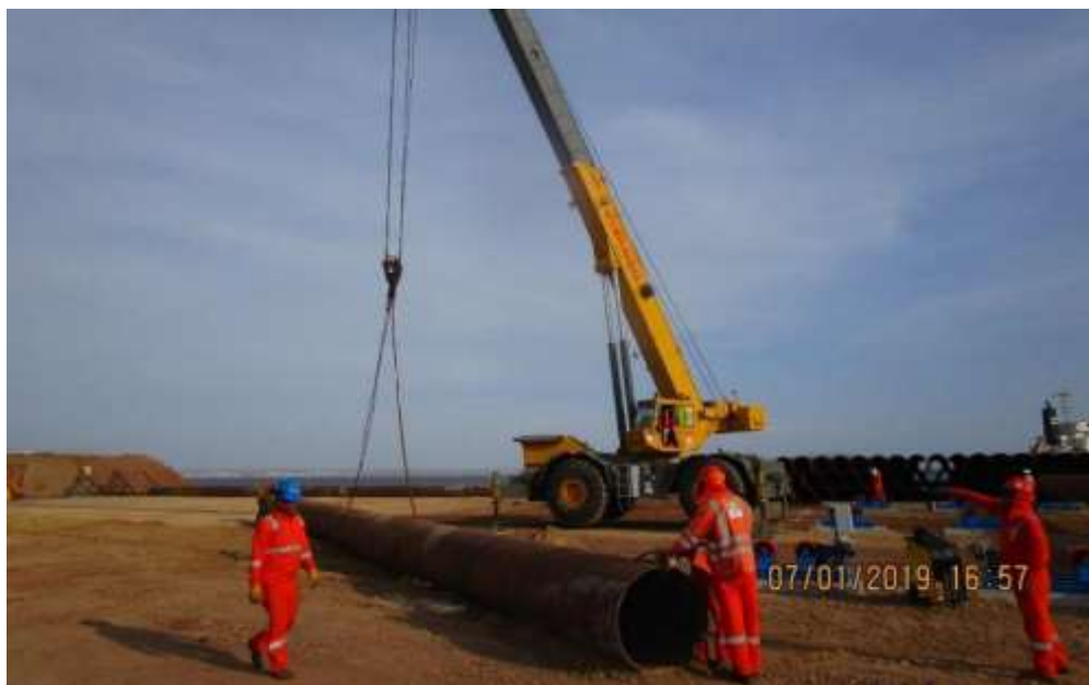
Figura 22. Preparación de Pilotes en Acopio para Traslado. Fuente: Propia
