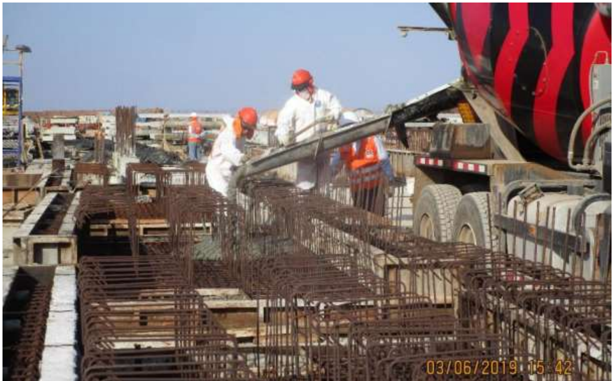
Figura 57. Vaciado de Concreto en Prefabricados para Muelle. Fuente: Propia
