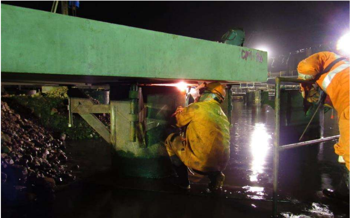
Figura 33. Soldadura para posicionamiento de capiteles en Muelle. Fuente: Propia
