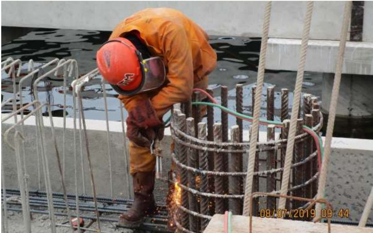
Figura 69. Trabajo de Soldadura de Pilotes Fuente: Propia
