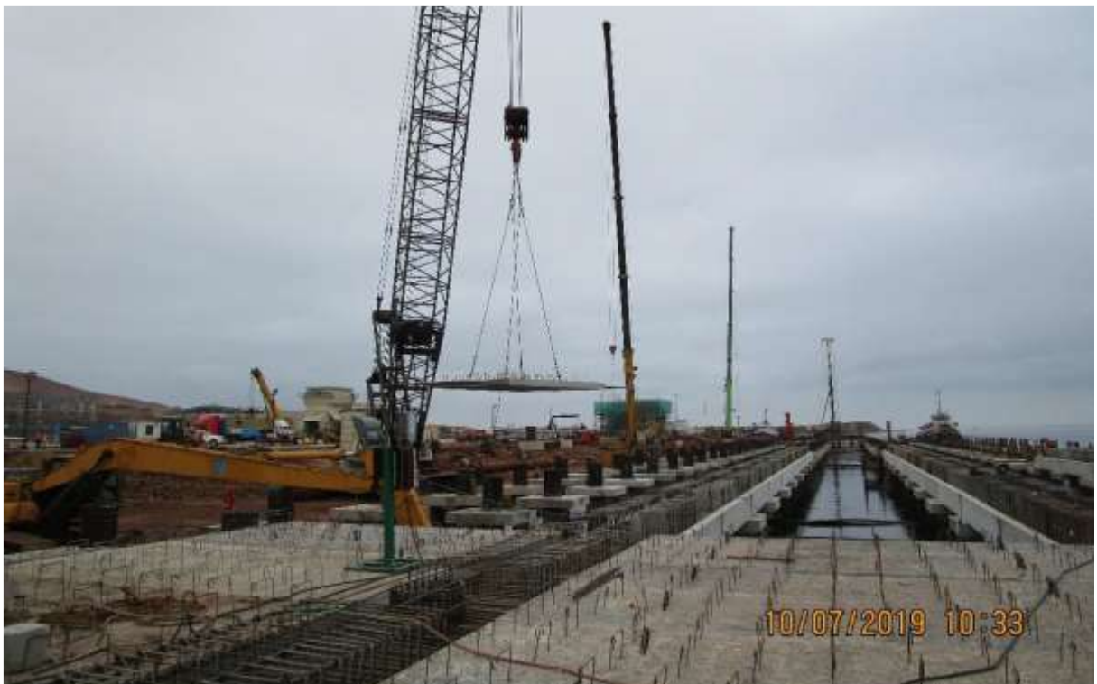
Figura 68. Vista de Montajes de Losa en Muelle. Fuente: Propia
