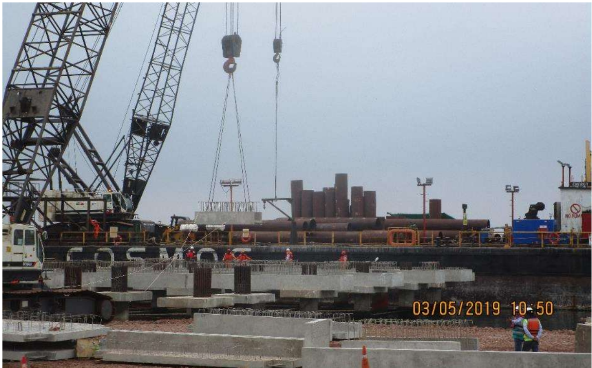
Figura 63. Montaje de Prelosas en Muelle. Fuente: Propia
