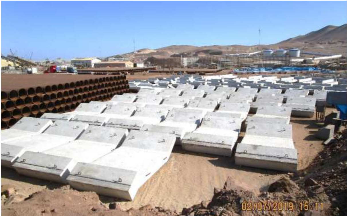
Figura 59. Vista de Zona de Acopio de Elementos Prefabricados Fuente: Propia
