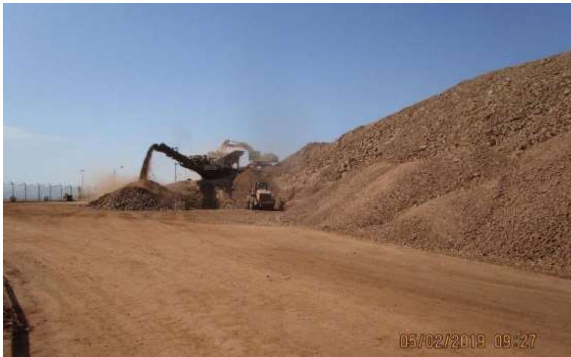
Figura 15. Procesamiento de Quarry Run Fuente: Propia
