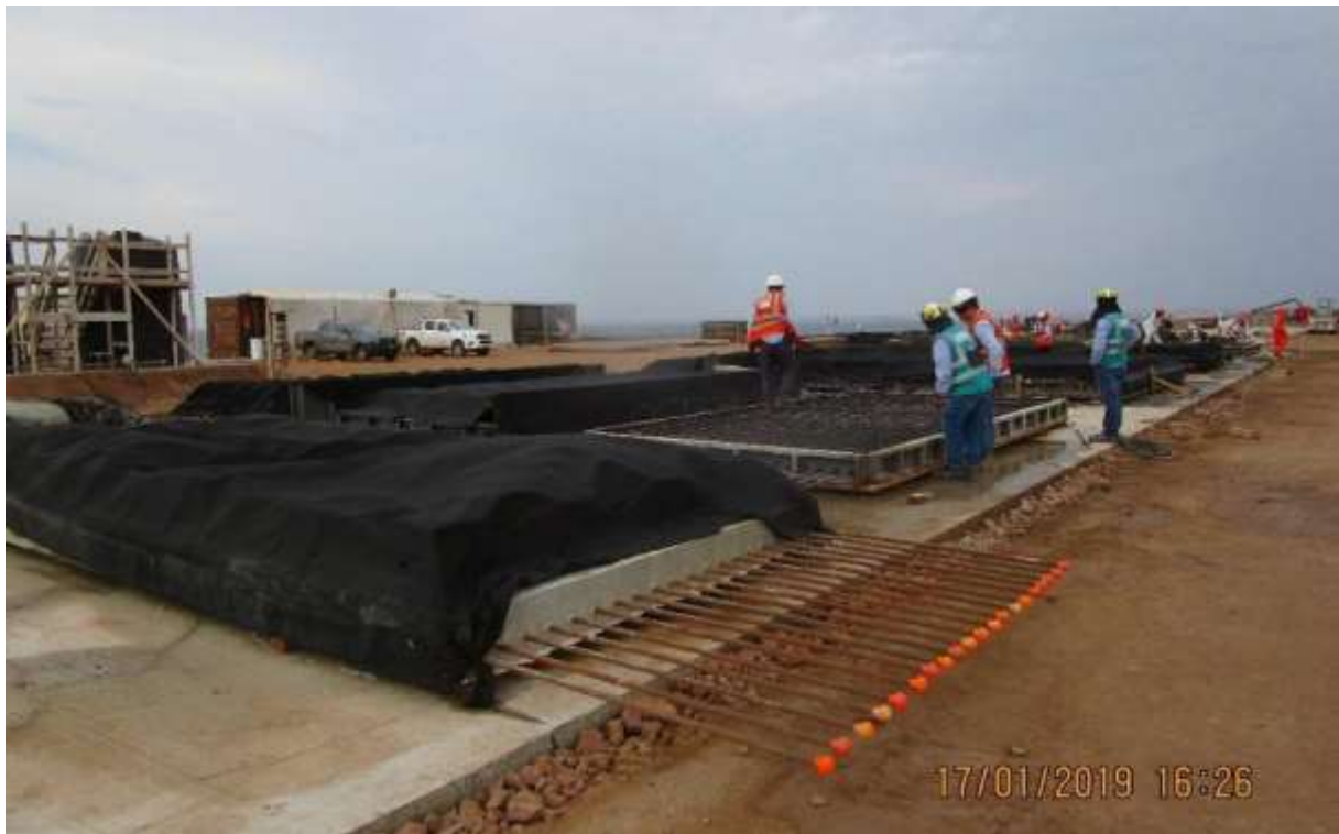
Figura 55. Curado y Habilitación de Acero en Estructuras de Prefabricados. Fuente: Propia
