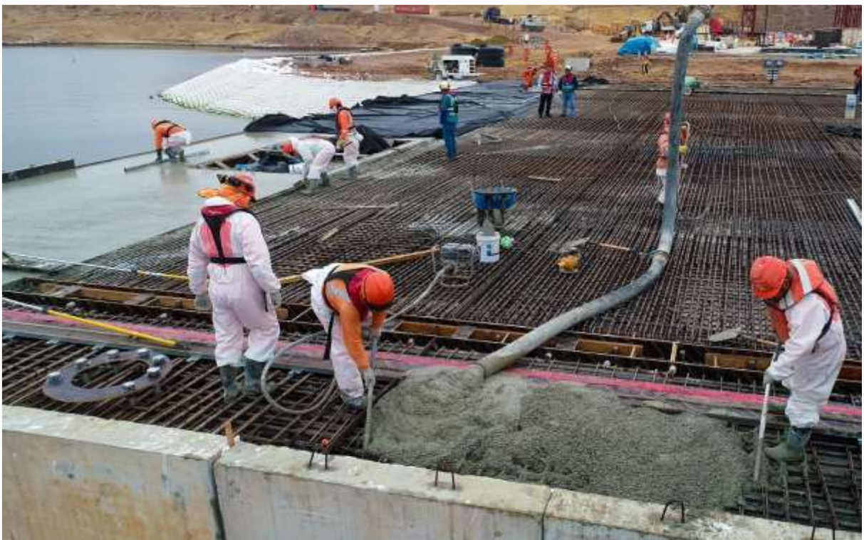
Figura 72. Vaciado de concreto en Losa de Muelle Fuente: Propia
