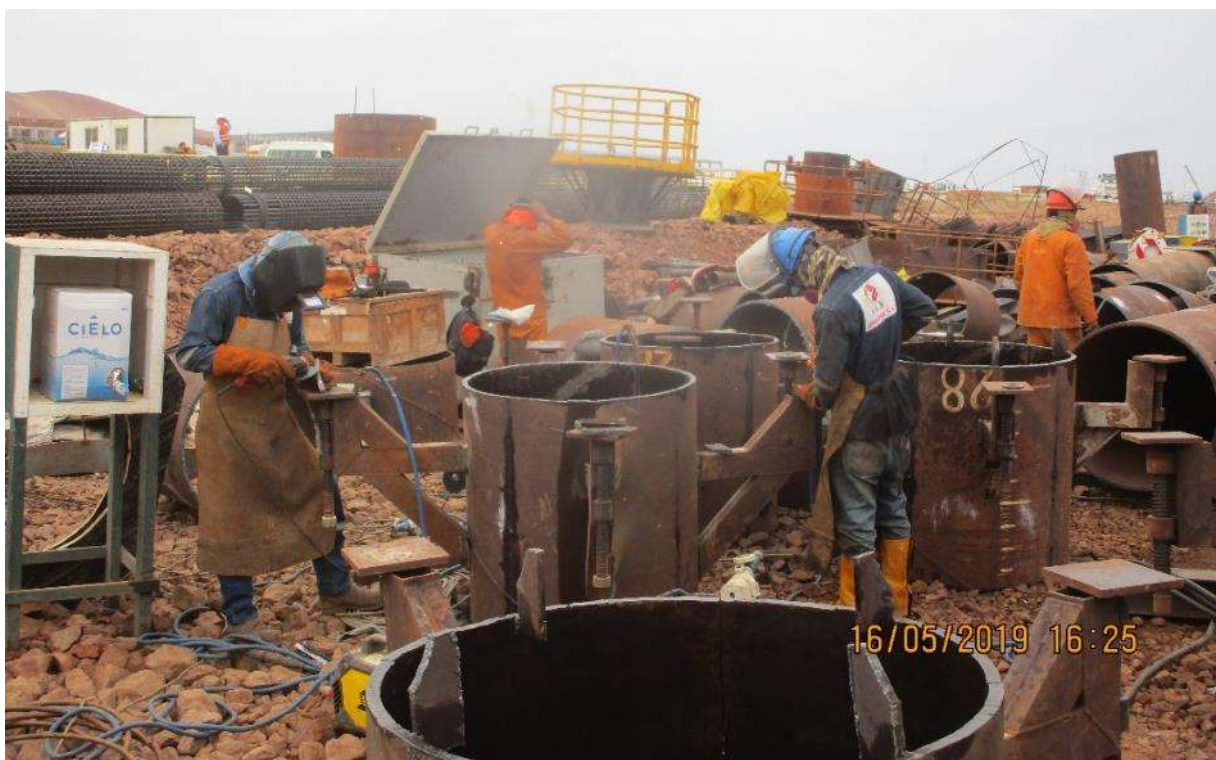
Figura 42. Preparación de Arriostre Metálico de Capiteles. Fuente: Propia
