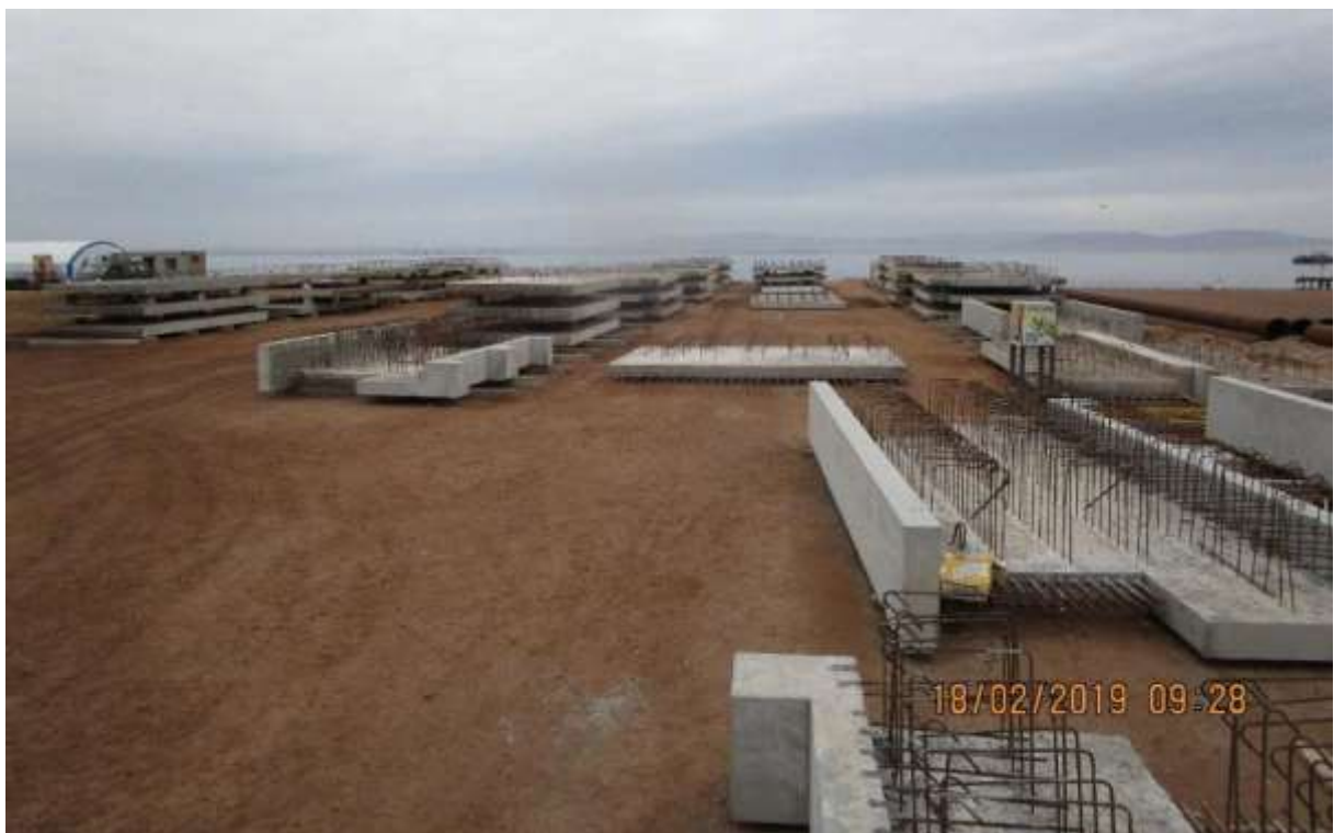
Figura 58. Acopio de Prefabricados. Fuente: Propia
