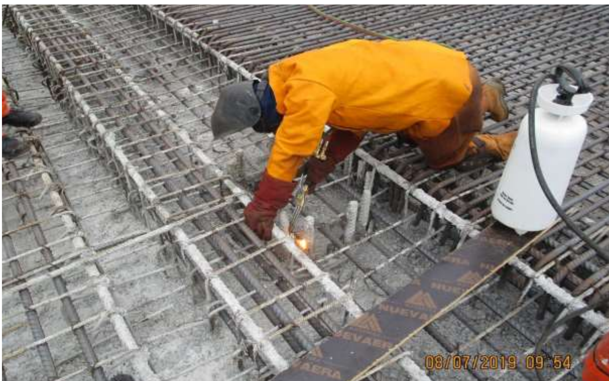
Figura 70. Trabajo de Soldadura de Pilotes Fuente: Propia
