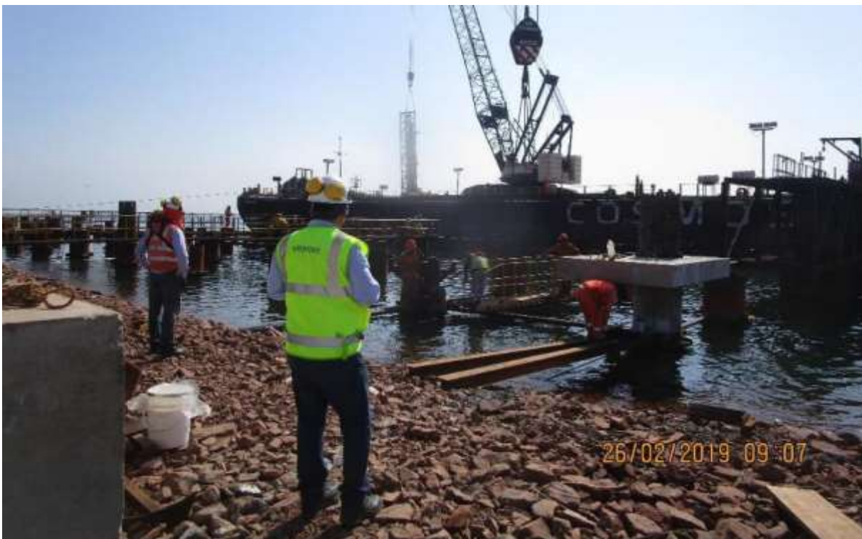
Figura 60. Trabajos Preliminares para Colocación de Prefabricados de Muelle. Fuente: Propia
