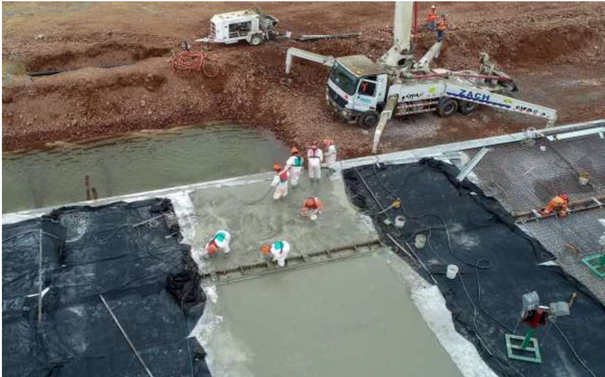
Figura 73. Vaciado de Concreto en Losa de Muelle Fuente: Propia
