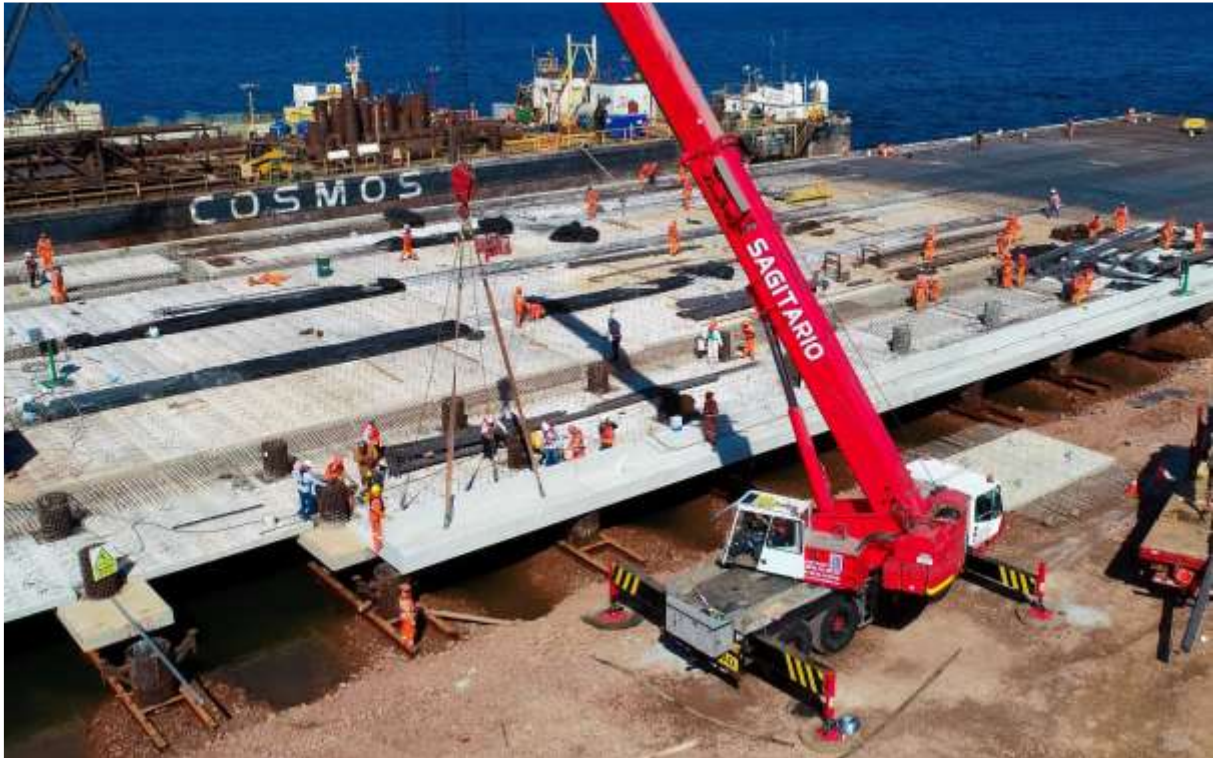
Figura 67. Trabajos de Montaje de Vigas Prefabricadas en Muelle Fuente: Propia
