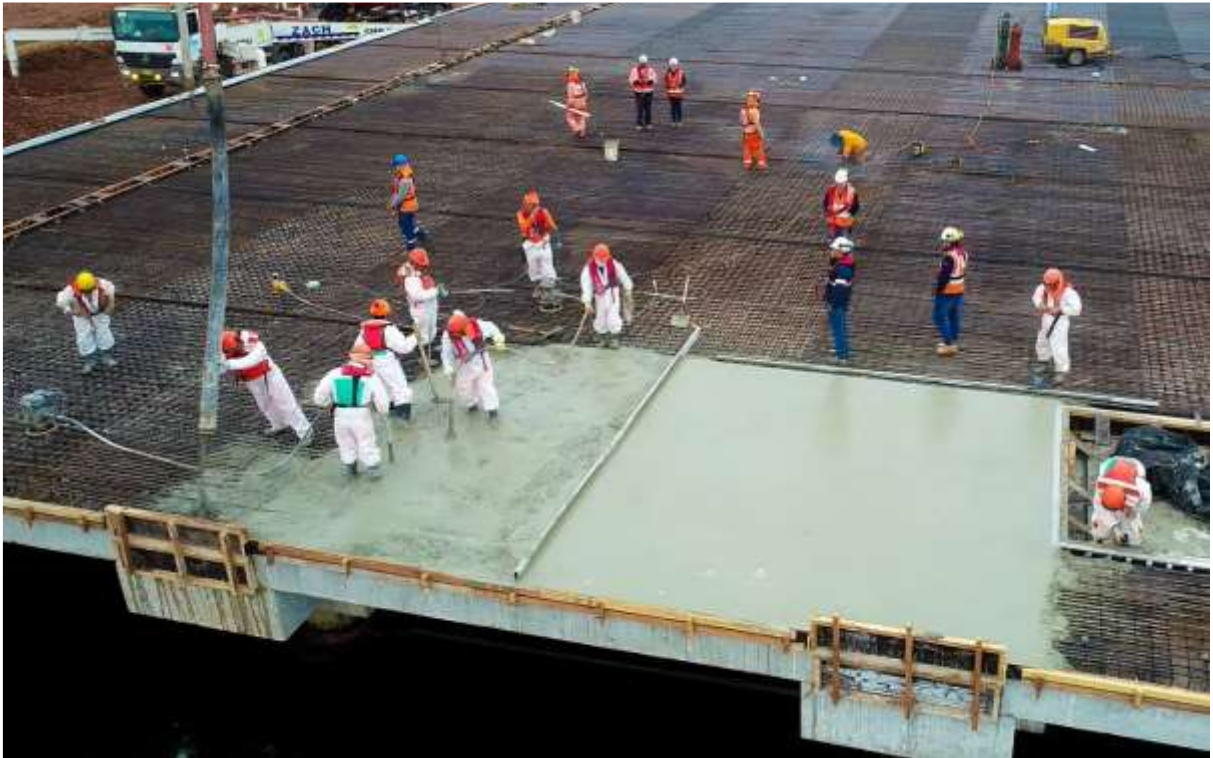
Figura 71: Vaciado de Concreto en Losa de Muelle Fuente: Propia
