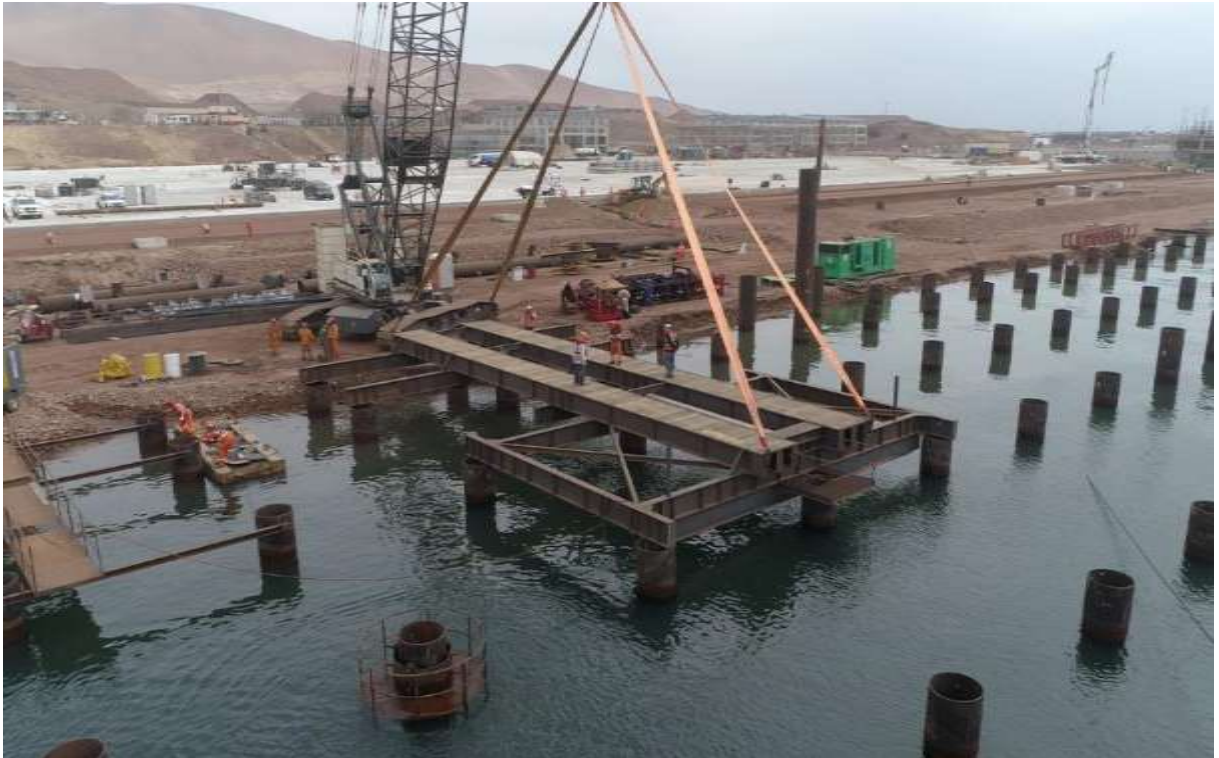
Figura 29. Hincado de Pilotes Fuente: Propia
