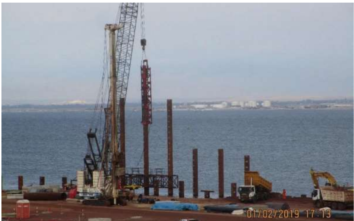
Figura 28. Hincado de Pilotes Fuente: Propia
