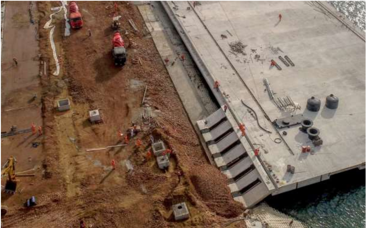
Figura 76. Montaje de Losa de Transición. Fuente: Propia
