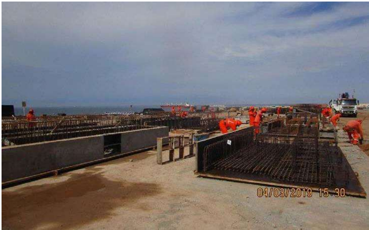
Figura 53. Habilitado de Acero para Estructuras de Prefabricados para Muelle. Fuente: Propia
