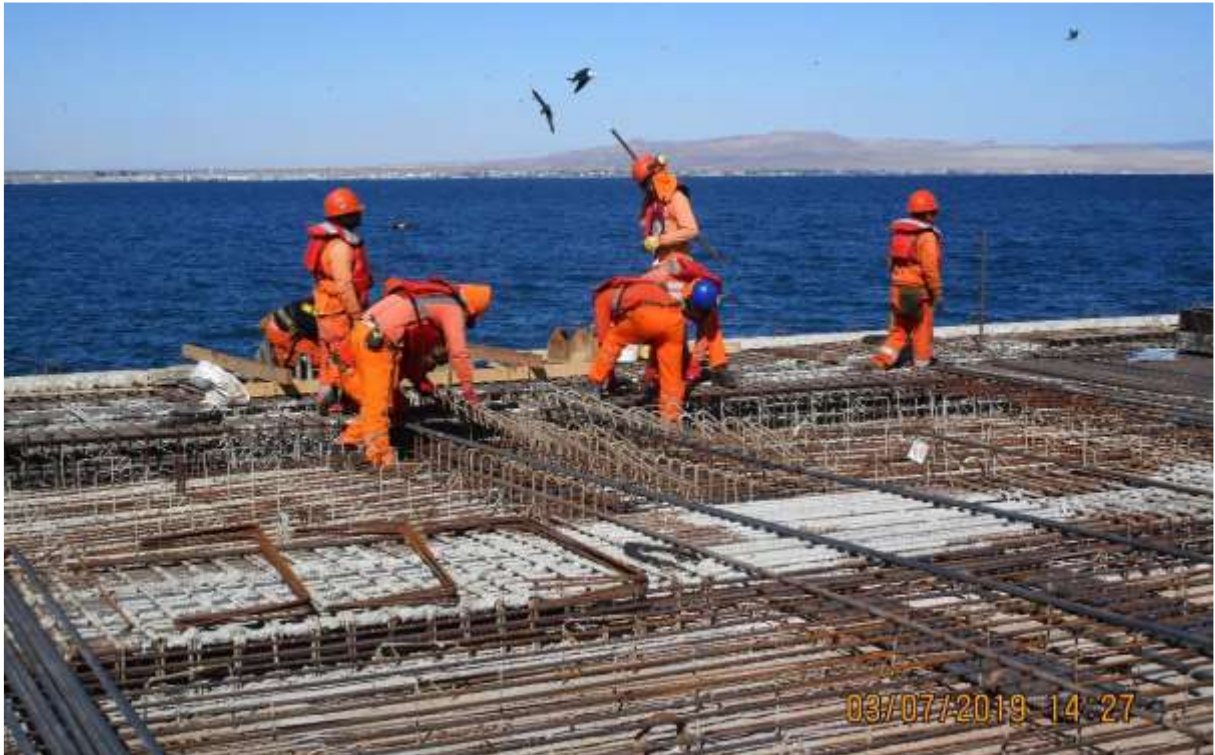
Figura 65. Colocación de Acero en Losa del Muelle Fuente: Propia
