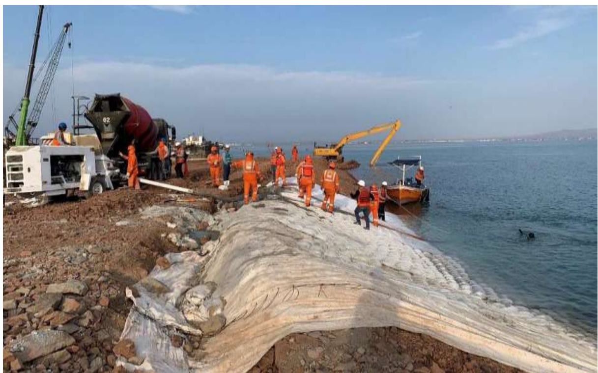
Figura 20. Trabajos para Instalación de Colchaceto. Fuente: Propia
