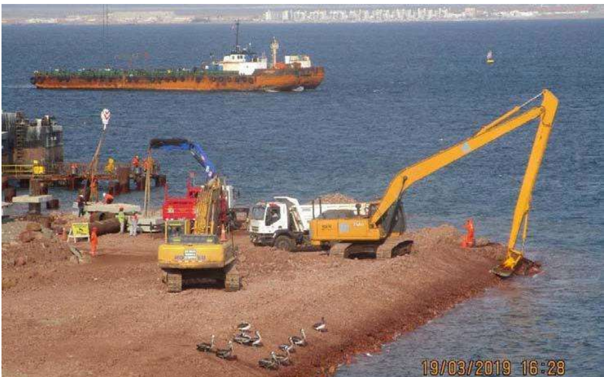
Figura 18. Conformación de Talud de Muelle Fuente: Propia
