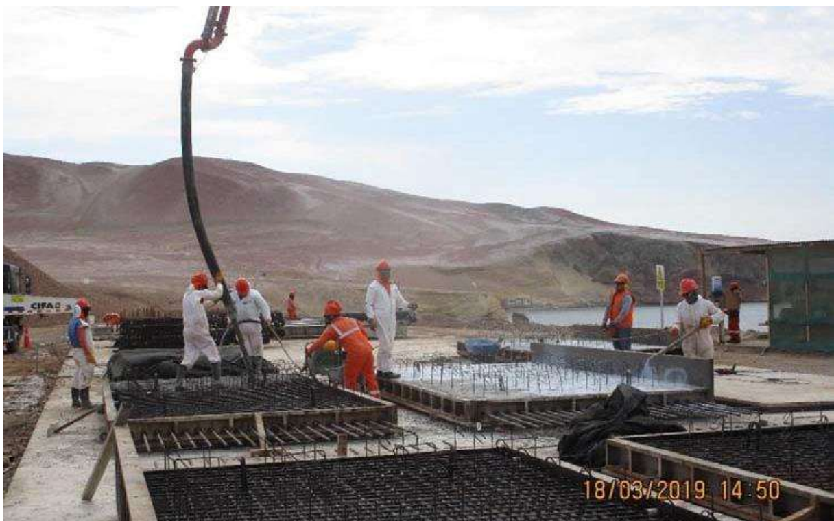
Figura 56. Vaciado de Concreto en Prefabricados para Muelle. Fuente: Propia
