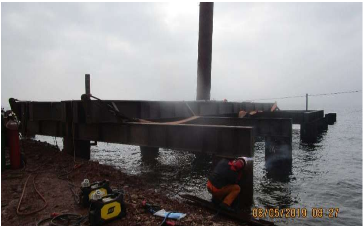
Figura 30. Soldadura de Plataforma de Soporte de Perforadora Fuente: Propia
