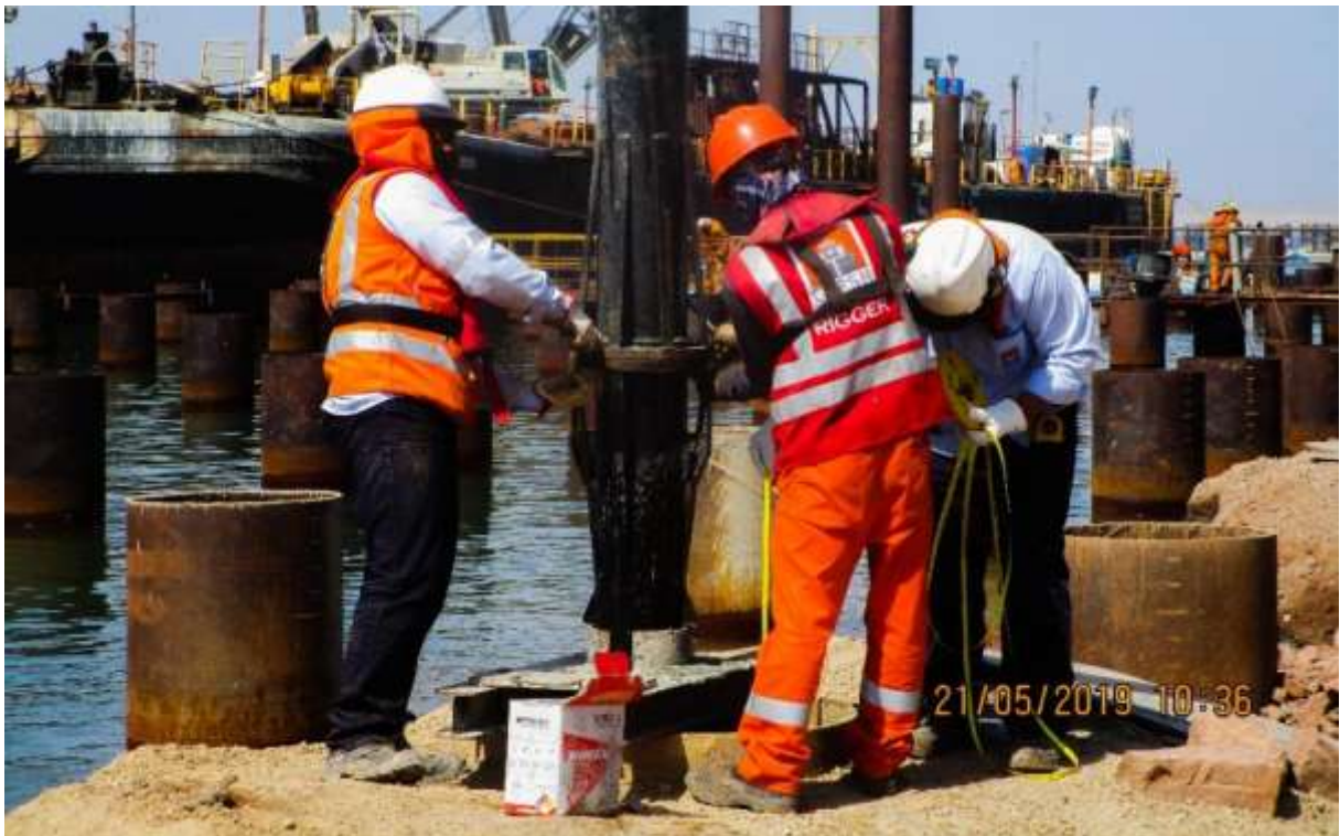
Figura 45. Vertido de Concreto para Pile Plug Fuente: Propia
