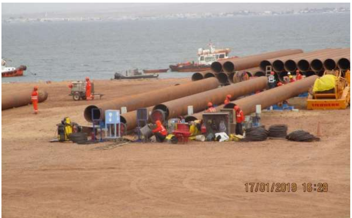
Figura 24. Soldadura de Anillos Interiores en los Pilotes. Fuente: Propia
