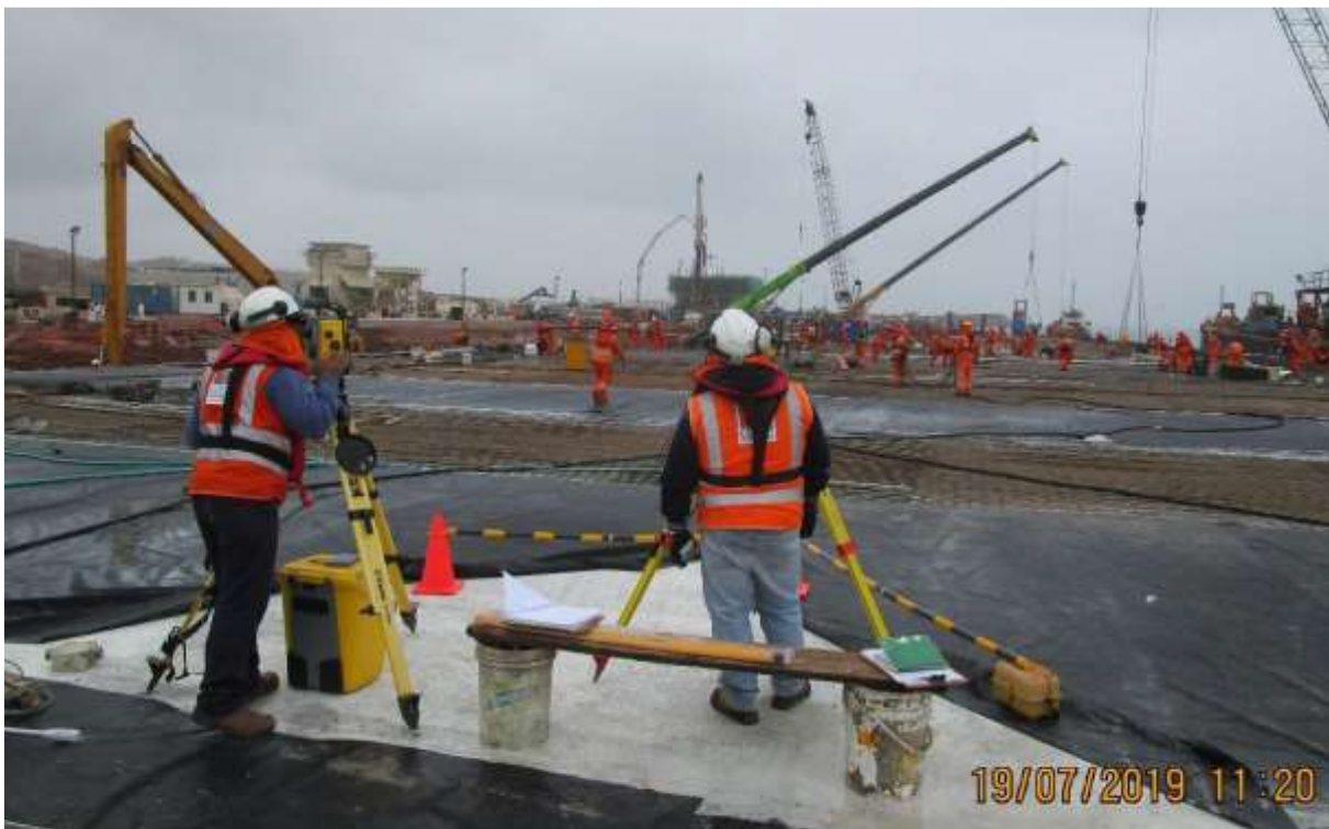
Figura 74. Trabajos de Nivelación de Losa en Muelle Fuente: Propia
