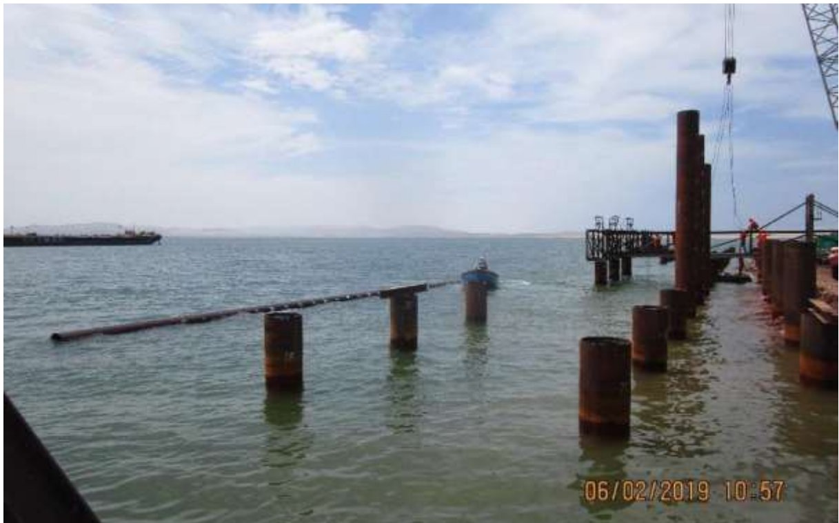
Figura 23. Traslado de Pilote para Hincado. Fuente: Propia
