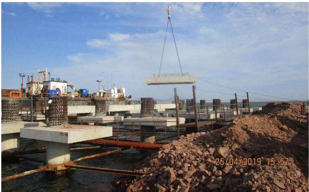
Figura 62. Montaje de estructuras de prefabricados en muelle. Fuente: Propia
