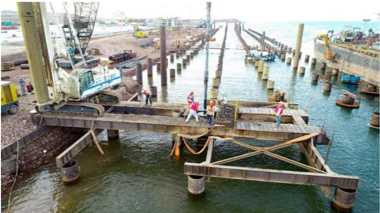
Figura 46. Vertido de Concreto para Pile Plug Fuente: Propia
