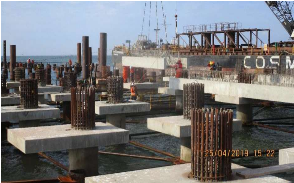
Figura 61. Montaje de Estructuras de Prefabricados en Muelle. Fuente: Propia
