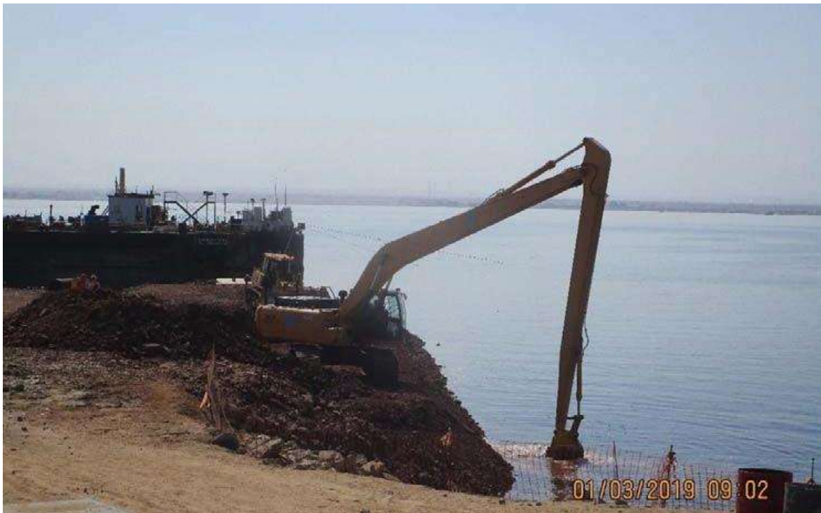
Figura 17. Conformación de Talud de Muelle Fuente: Propia
