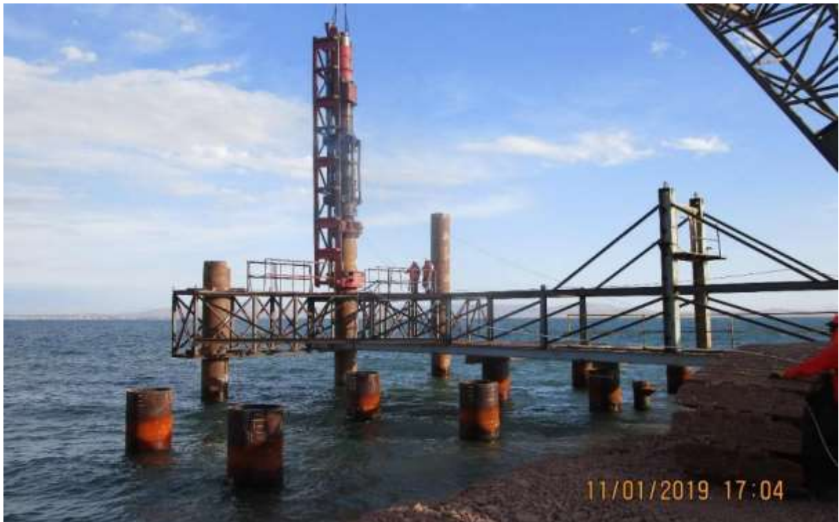
Figura 27. Hincado de Pilotes Fuente: Propia
