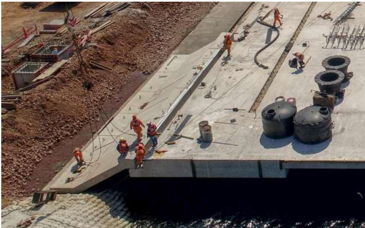
Figura 75. Montaje de Losa de Transición. Fuente: Propia
