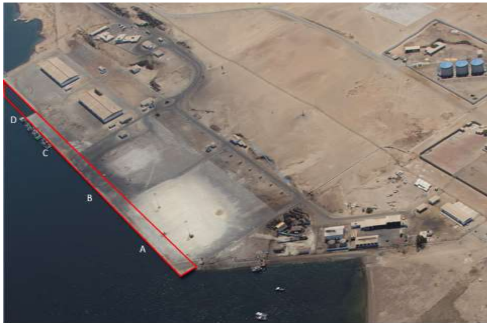
Figura 10. Terminal Portuario en 2016 Fuente: Archivo fotográfico del contratista CCPSM
