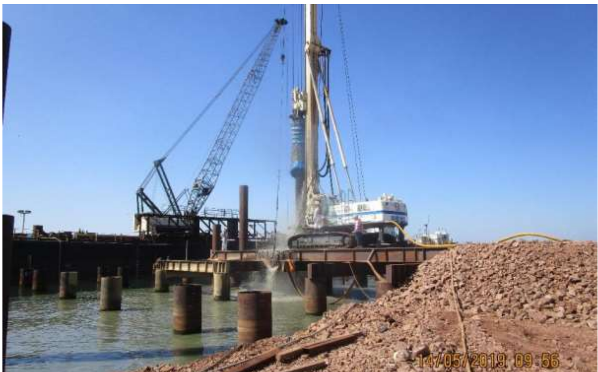
Figura 36. Rehincado de pilotes en muelle. Fuente: Propia
