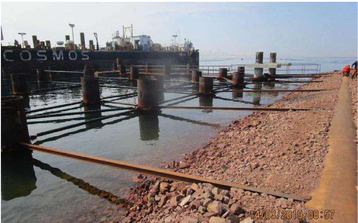
Figura 34. Vista de arriostres en pilotes de muelle. Fuente: Propia
