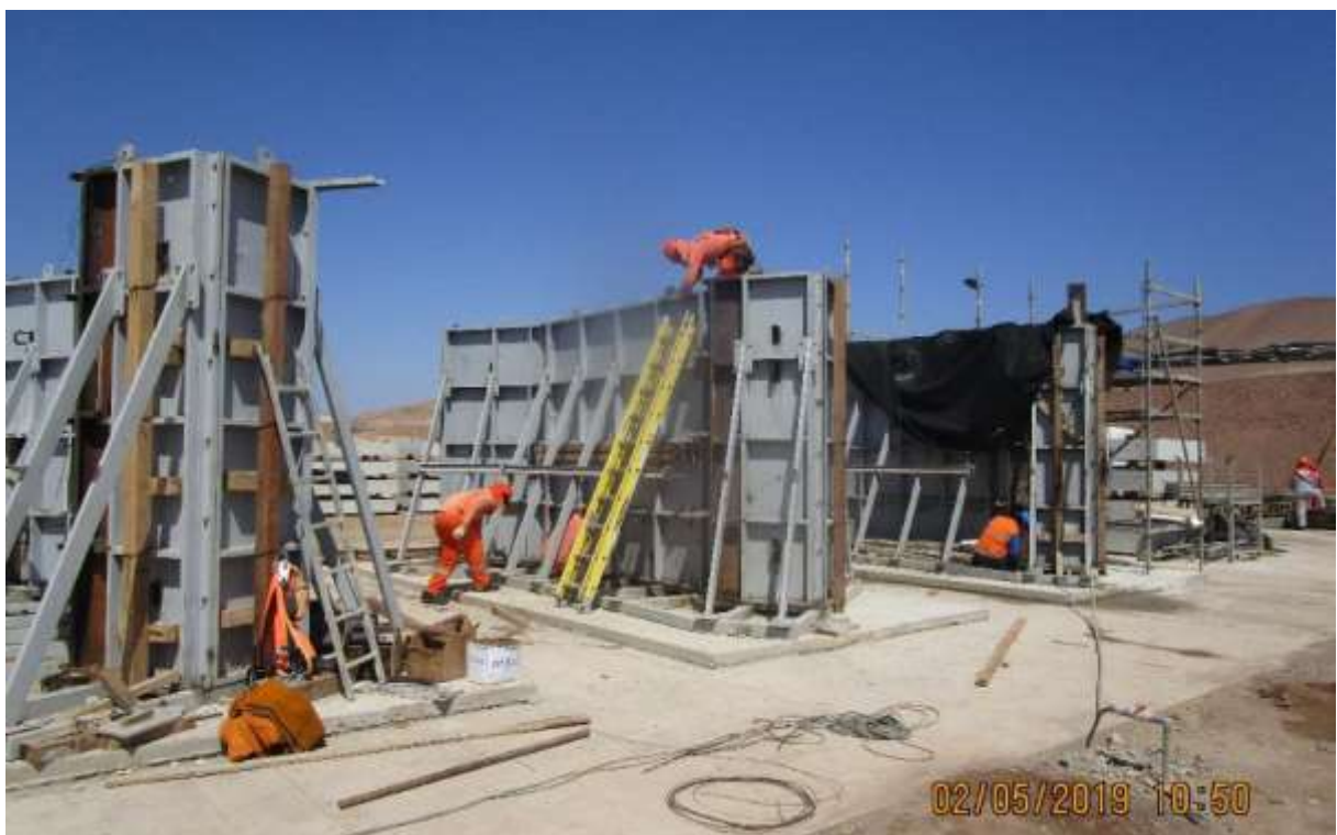
Figura 54. Encofrado de elementos Prefabricados para muelle. Fuente: Propia
