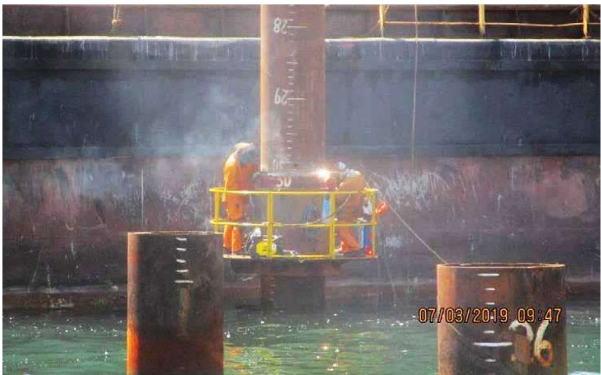
Figura 38. Trabajos de Corte de Pilotes Fuente: Propia
