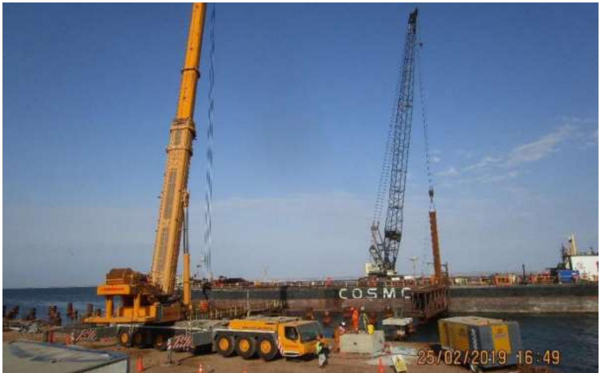
Figura 31. Hincado de Pilotes por Mar (Barcaza) Fuente: Propia
