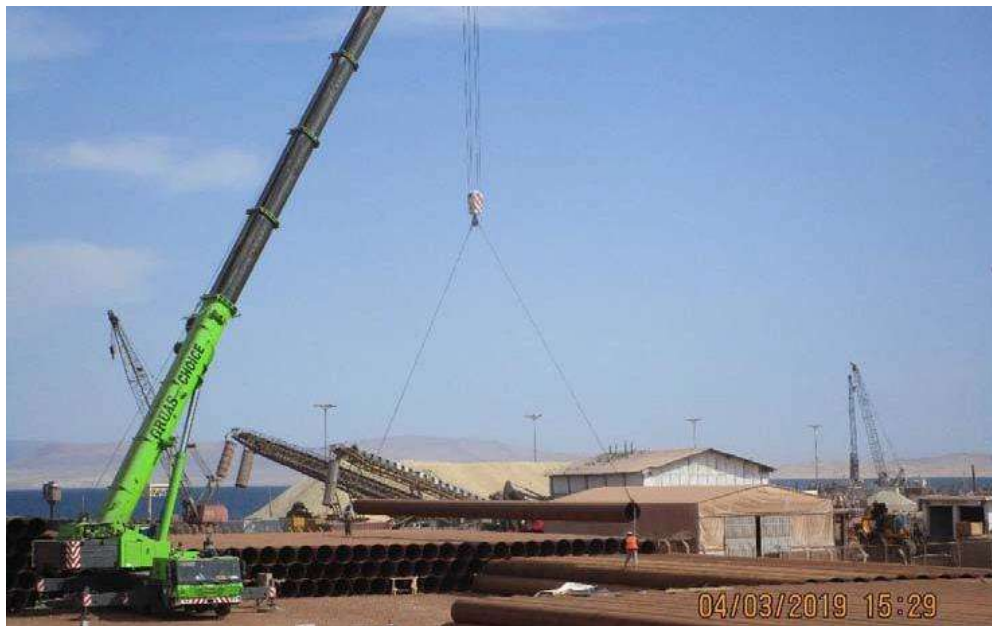
Figura 21. Suministro de Pilotes para Hincado Fuente: Propia
