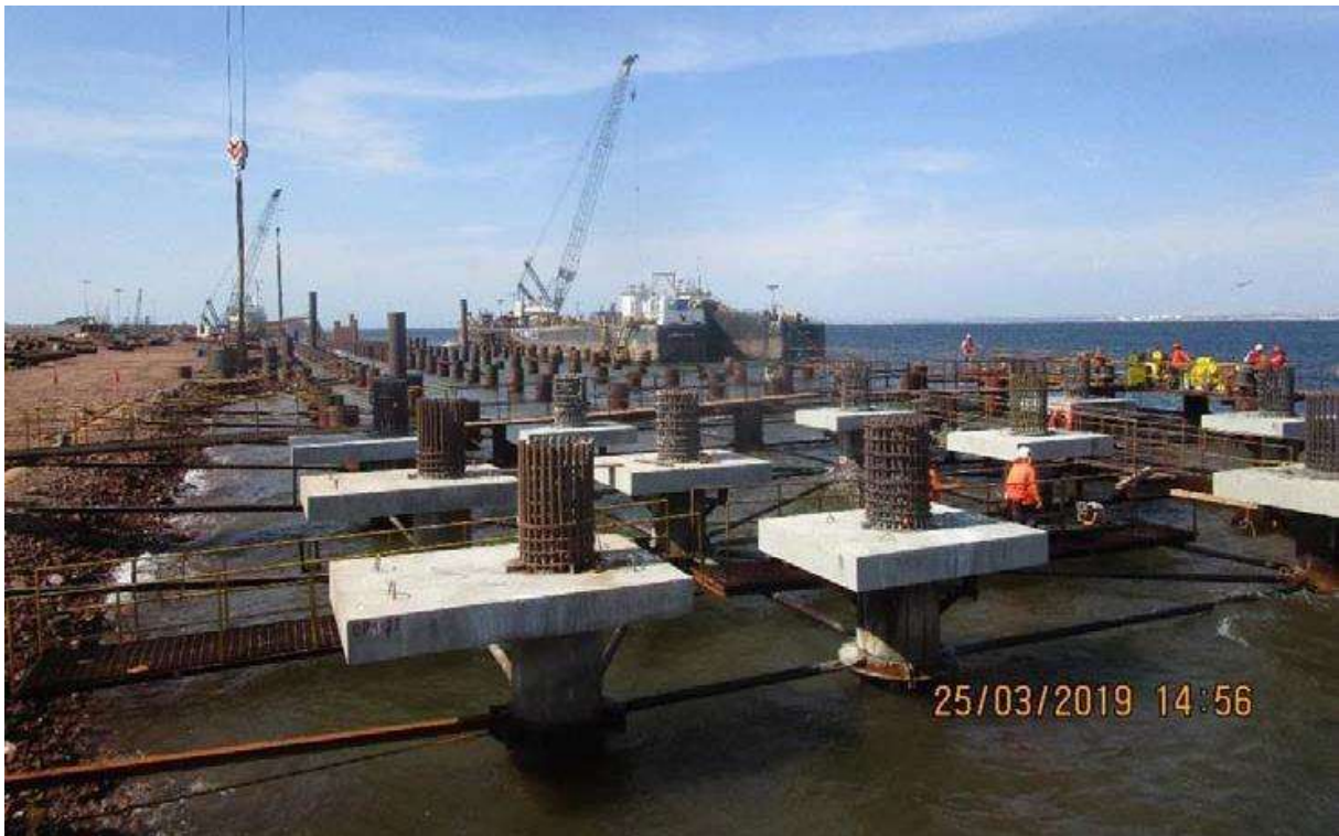
Figura 51. Instalación de Capiteles en Estructura de Muelle.
