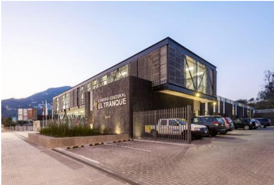
Figura 05. Vista principal del Centro Cultural El Tranque Fuente: Vargas (2017)
