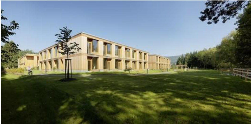
Figura 4: Vista principal de caso 04 - Residencia Hogar de Cuidados Andritz / Dietger Wissounig Architekten
