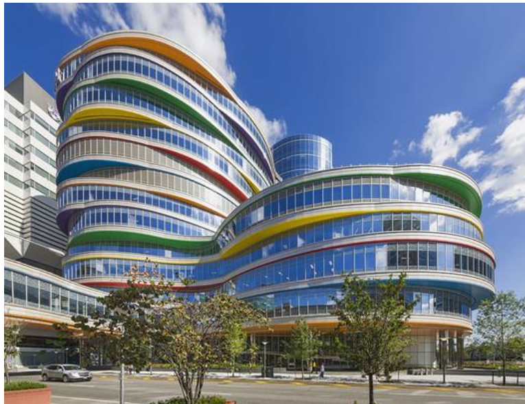
Figura 2. Vista de fachada caso 2
