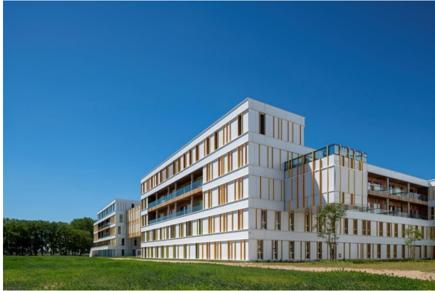
Figura 6. Vista de fachada de caso arquitectónico caso 6
