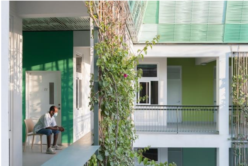
Figura 6: Vista interior del caso 04
