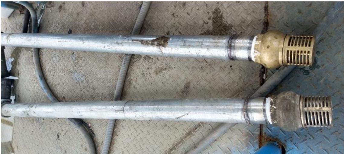
*Figura 30.* Tubería de succión de la bomba luego del mantenimiento.
