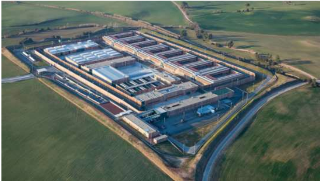
Figura 03. Vista de la fachada principal del caso internacional 03
