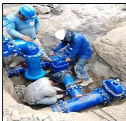
Fotografía N° 01 02, 03 y 04: Se aprecia el proceso de instalación de los tanques de 25 m3, árbol hidráulico, electrobombas y By Pass, para el sistema de abastecimiento provisional del Reservorio Collique R-6, el cual va a bombear agua potable hacia los reservorios Collique R-7 y Collique R-8.
