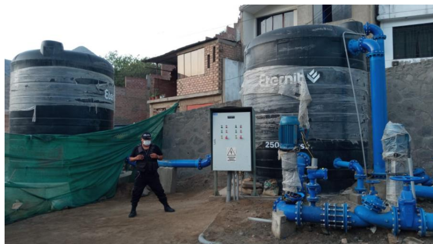
Fotografía N° 20 y 21: Se aprecia al personal técnico capacitado para el funcionamiento y operatividad del sistema provisional. Asimismo, el personal de seguridad está presente desde el primer día que comenzaron los trabajos para la implementación del sistema de abastecimiento provisional del reservorio R-23 Collique R-6.
