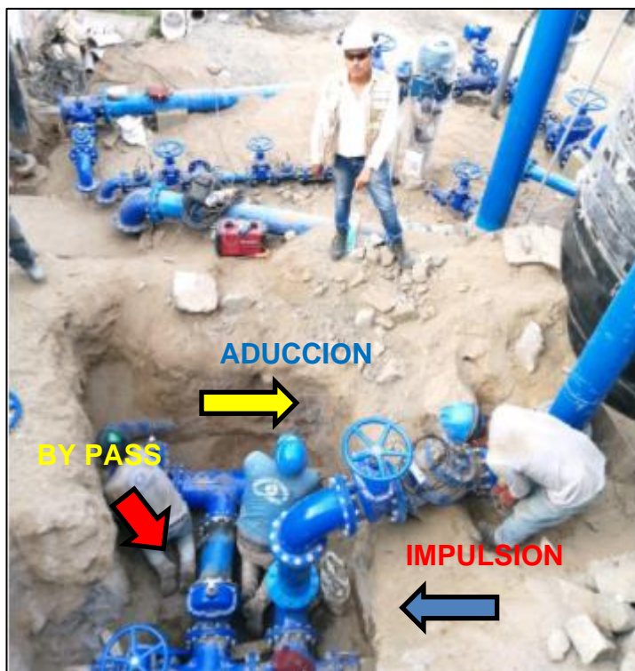
Figura 17. Instalación del By Pass provisional Fuente: Elaboración propia
