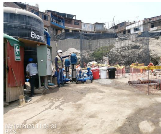
Fotografía N° 22, 23 y 24: Se aprecia el Sistema de Abastecimiento Provisional del Reservorio Collique R-6 en funcionamiento, durante los trabajos de desmontaje del árbol hidráulico existente de la CR-97, demolición de reservorio y construcción del nuevo reservorio y caseta.
