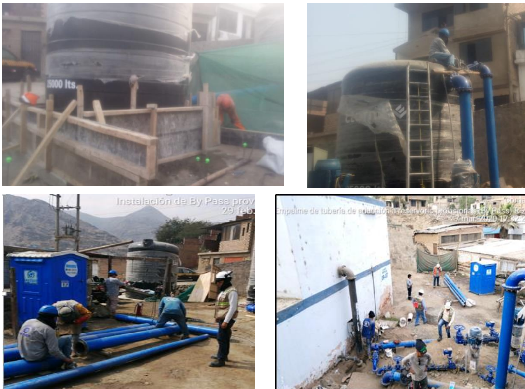
Fotografía N° 01 02, 03 y 04: Se aprecia el proceso de instalación de los tanques de 25 m3, árbol hidráulico, electrobombas y By Pass, para el sistema de abastecimiento provisional del Reservorio Collique R-6, el cual va a bombear agua potable hacia los reservorios Collique R-7 y Collique R-8.
