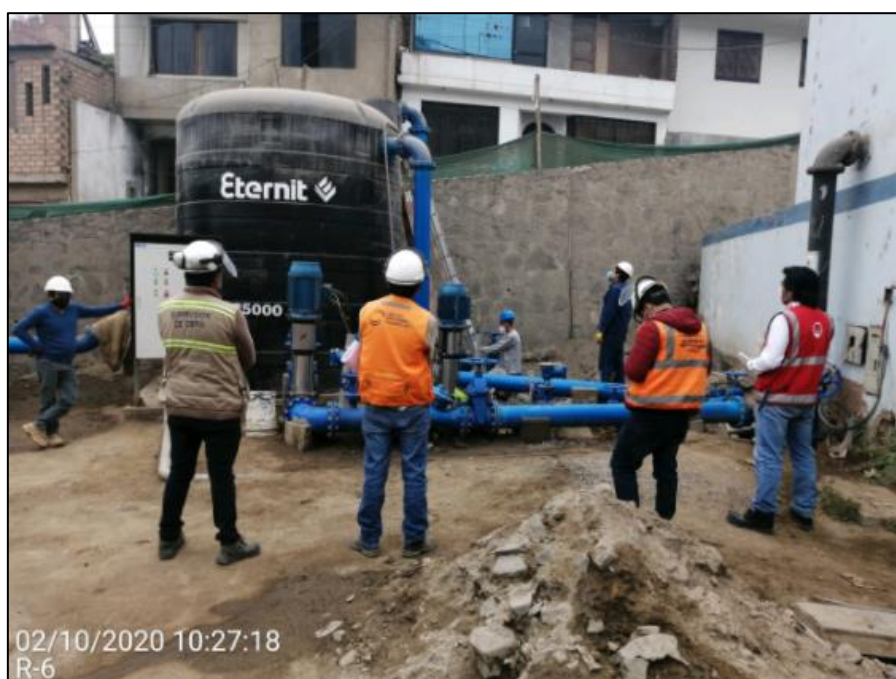
Figura 19. Marcha Blanca. Prueba del abastecimiento del equipo de bombeo provisional Fuente: Elaboración propia
