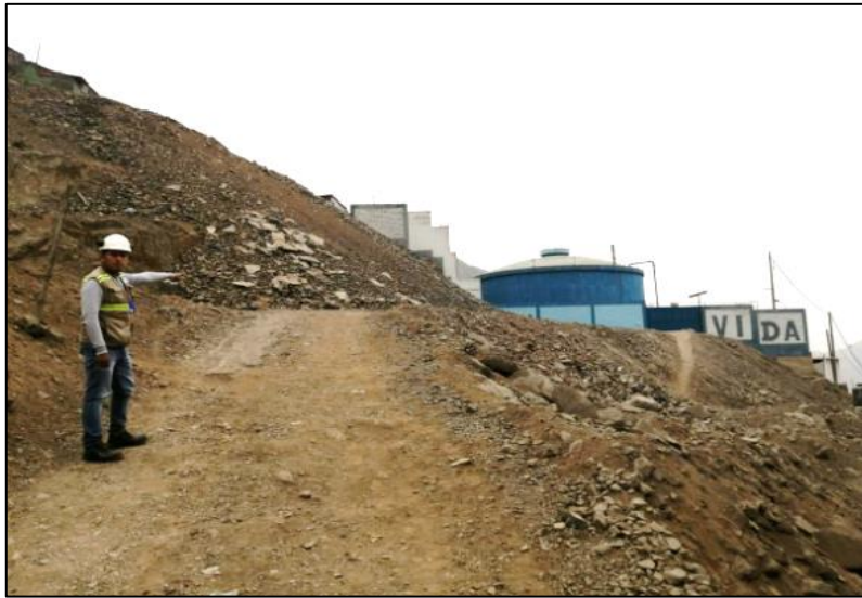
Figura 6. Acceso vehicular para el abastecimiento del reservorio R-7 Fuente: Elaboración propia
