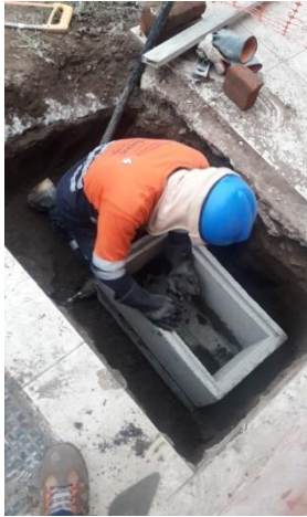
Figura 39 Instalación de caja de alcantarillado y solaqueado
