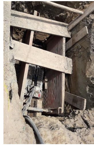
Figura 62 Instalación de máquina de fragmentación.
