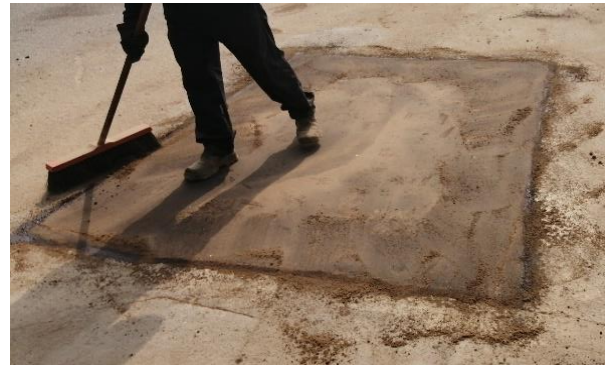
Figura 56 Sellado de juntas con arena fina y limpieza.
