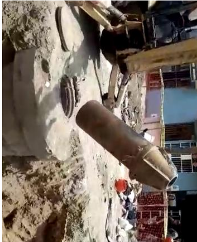
Figura 63 Cabezal fragmentador del equipo de fragmentación.
