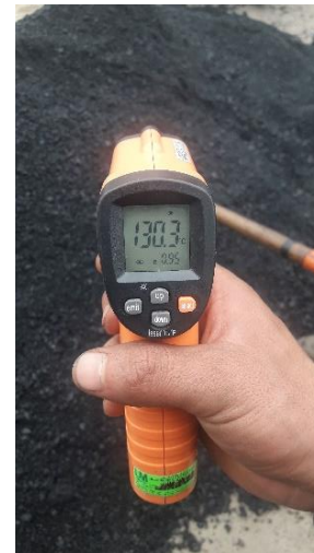
Figura 52 Control de temperatura del material granular de asfalto.
