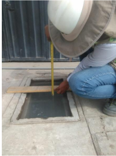
Figura 27 Prueba hidráulica a zanja tapada
