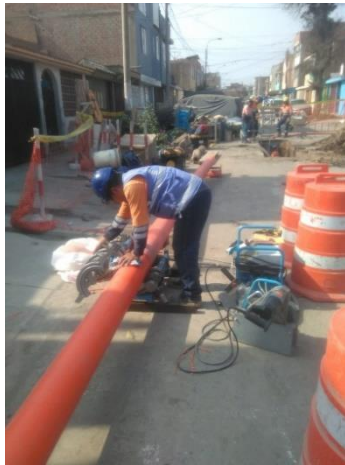
Figura 35 Termofusión de tubería HDPE, a ser instalada en colectora de alcantarillado.
