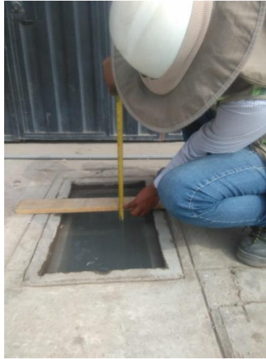
Figura 46 Prueba hidráulica a zanja tapada
