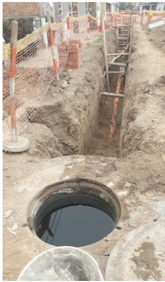
Figura 20 Prueba hidráulica a zanja abierta de colectora y conexiones de alcantarillado.
