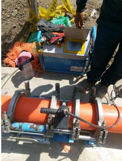
Figura 69 Corte de tuberías para alineación.
