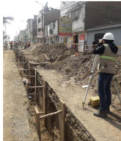
Figura 17 Verificación de pendiente longitudinal de tubería tendida.
