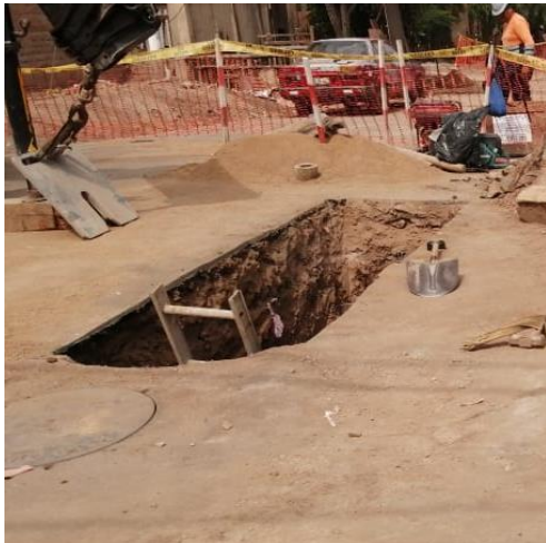
Figura 33 Excavación de ventana de fragmentación y conexiones de alcantarillado, debidamente señalizado.
