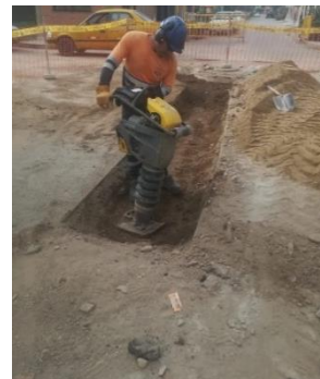
Figura 42 Relleno y compactación de base con material afirmado para tapado de zanja.
