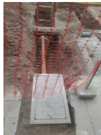
Figura 19 Instalación de conexión de alcantarillado PVC a red colectora.
