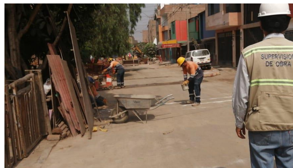
Figura 11 Corte con disco diamantado sobre el trazo de la línea y conexiones de alcantarillado
