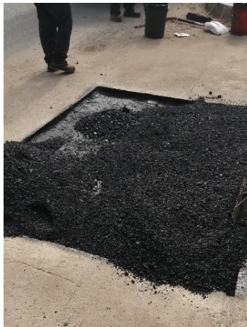
Figura 47 Reposición de asfalto
