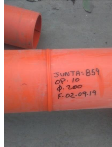
Figura 15 Verificación de juntas de pega de termofusión en tubería HDPE
