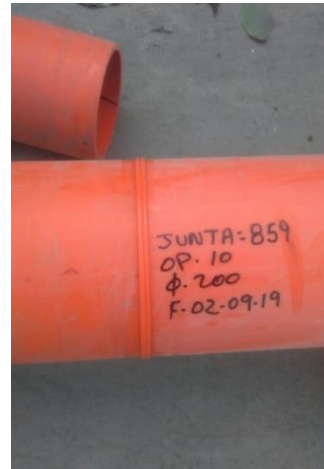
Figura 36 Verificación de juntas de pega de termofusión en tubería HDPE
