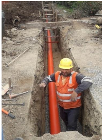
Figura 16 Instalación de tubería HDPE, sobre cama de arena.
