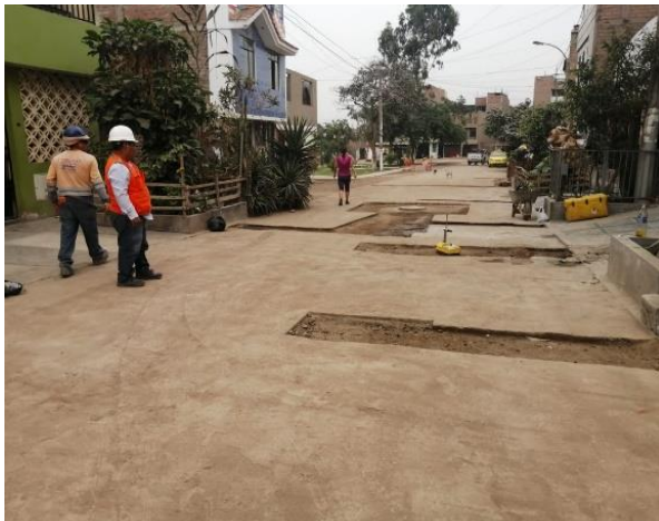
Figura 45 Prueba de compactación con densímetro nuclear.
