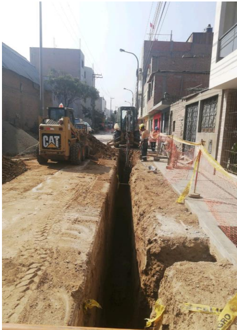
Figura 12 Excavación de colectora y conexiones de alcantarillado, debidamente señalizado.
