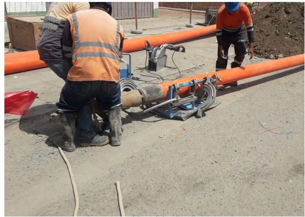
Figura 64 Termofusión de cabezal fragmentador a la tubería HDPE.
