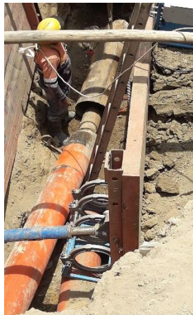
Figura 37 Lanzamiento de tubería de alcantarillado por fragmentación.
