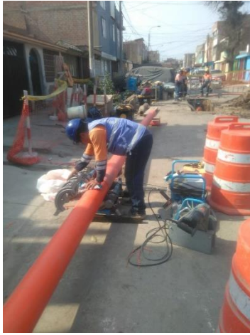
Figura 14 Termofusión de tubería HDPE, a ser instalada en colectora de alcantarillado.
