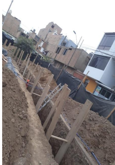
Figura 13 Colocación de entibado de madera en zanja
