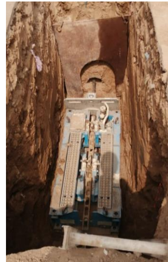
Figura 34 Instalación de maquina de fragmentación y entibado.
