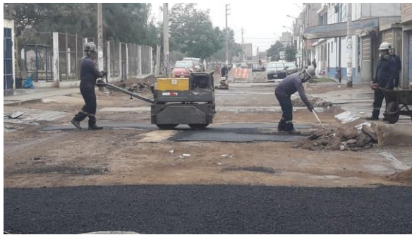
Figura 55 Compactación con rodillo vibratorio sobre material granular.
