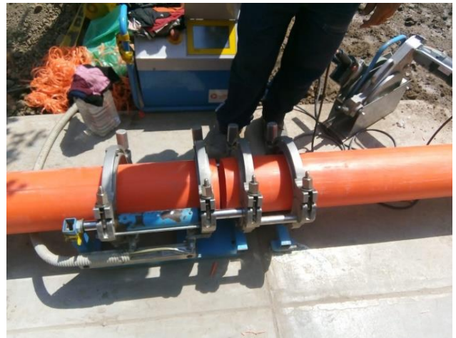
Figura 68 Alineamiento de tuberías HDPE para termofusión.
