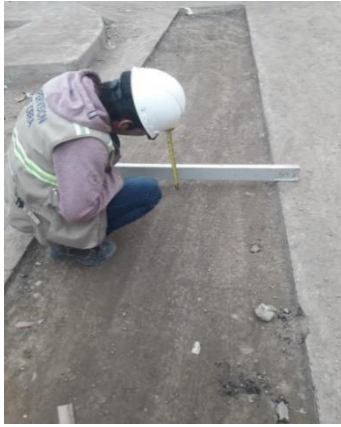
Figura 43 Verificación de espesor para reposición de carpeta asfáltica en ventana de fragmentación.
