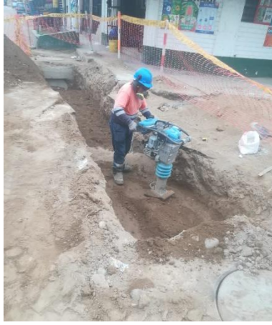
Figura 22 Relleno y compactación con material propio para tapado de zanja.
