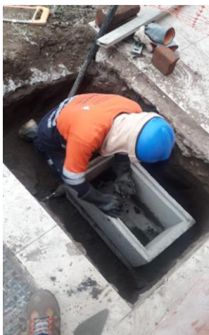
Figura 18 Instalación de caja de alcantarillado y solaqueado.
