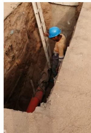
Figura 38 Llegada de tubería del lanzamiento de máquina de fragmentación.
