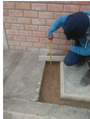
Figura 25 Verificación de espesor de veredas para reposición de concreto en conexiones
