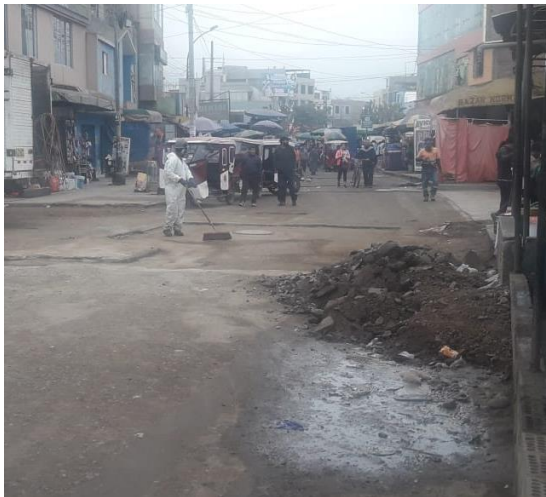
Figura 51 Limpieza de terreno para reposición de asfalto
