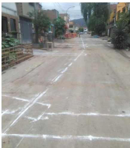
Figura 10 Trazo para excavación de redes y conexiones domiciliarias de alcantarillado.
