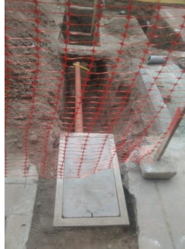
Figura 40 Instalación de conexión de alcantarillado PVC a red colectora.
