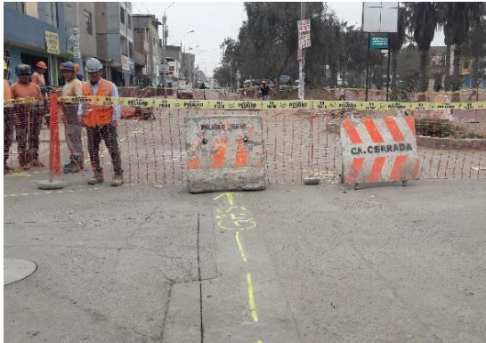
Figura 31 Trazo para excavación de red y conexiones domiciliarias de alcantarillado. Señalización de interferencias.
