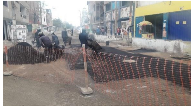
Figura 54 Vaciado de material granular de asfalto sobre el área a reponer.
