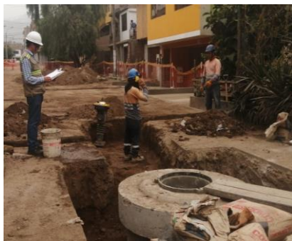
Figura 41 Relleno y compactación con material propio para tapado de zanja.
