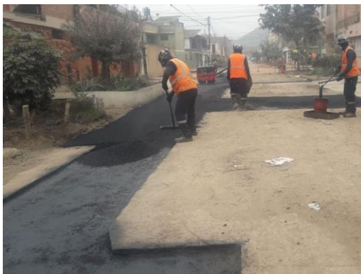
Figura 28 Reposición de asfalto
