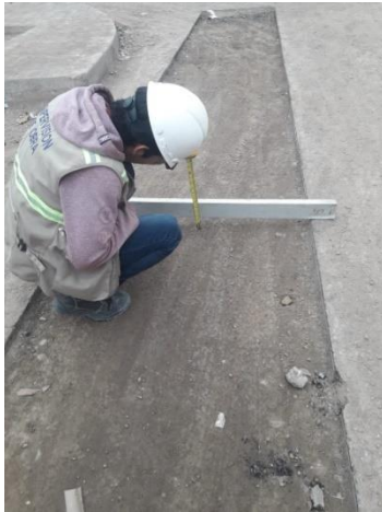
Figura 24 Verificación de espesor para reposición de carpeta asfáltica en colectora.
