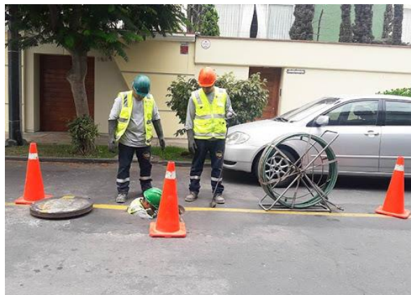
Figura 50 Verificación de red de alcantarillado por inspección televisiva.
