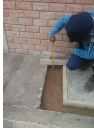
Figura 44 Verificación de espesor de veredas para reposición de concreto en conexiones.
