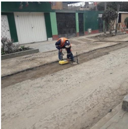
Figura 26 Prueba de compactación con densímetro nuclear.
