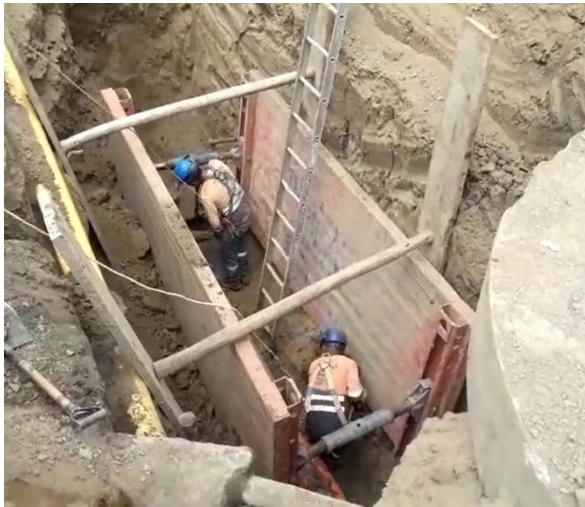
Figura 61 Instalación de entibado metálico.
