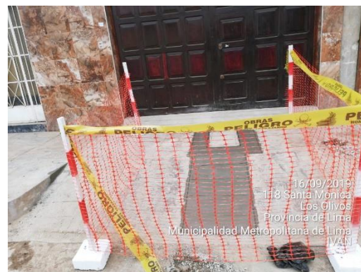
Figura 29 Reposición de concreto en veredas.
