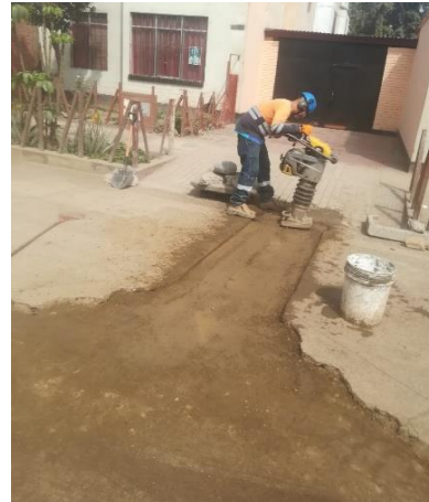
Figura 23 Relleno y compactación de base con material afirmado para tapado de zanja.
