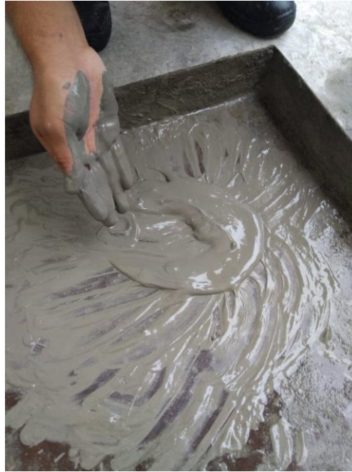
Figura N° 11: Lechada de Cemento 1/2
