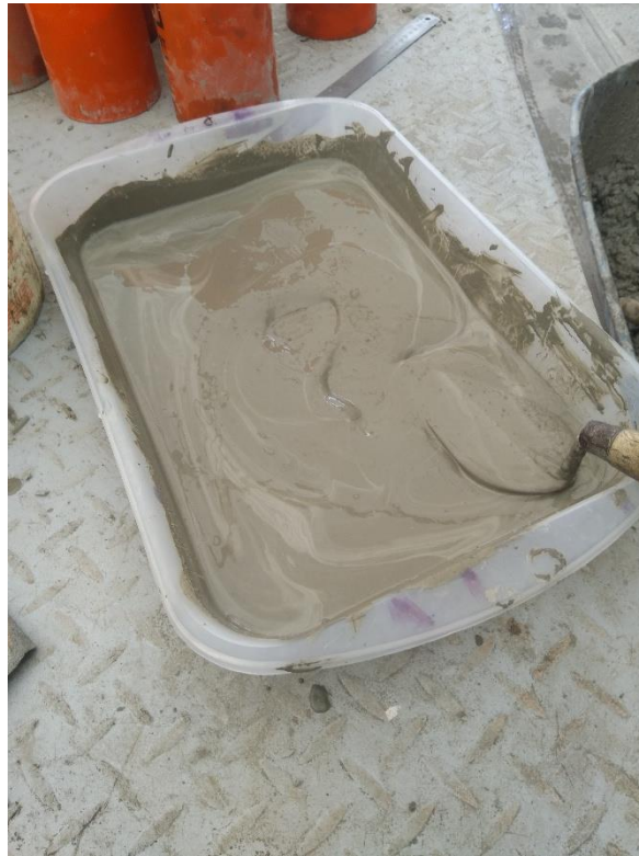
Fotografía N° 27: Preparación de lechada cementicia
