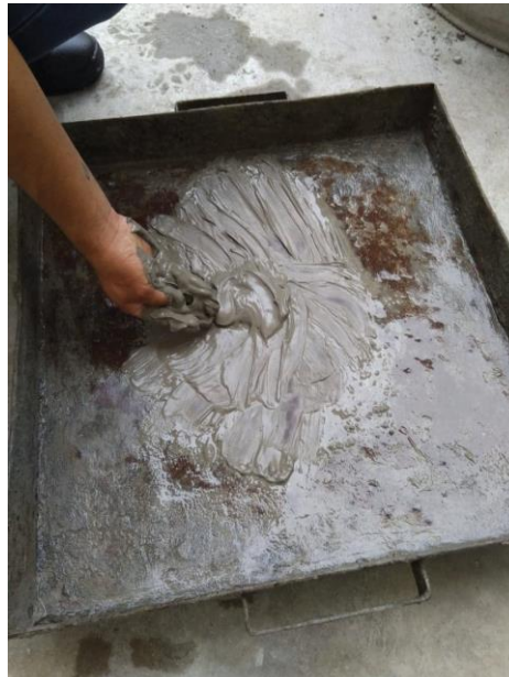
Figura N° 12: Lechada de Cemento 1/3
