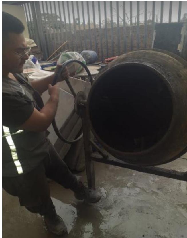
Fotografía N° 22: Mezcla de Concreto en Trompo Mezclador
