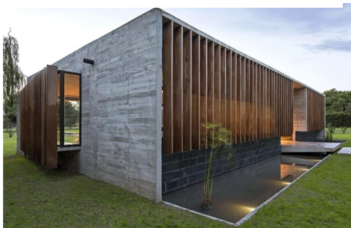
Figura N° 18. Espejo de agua aplicado en vivienda.
