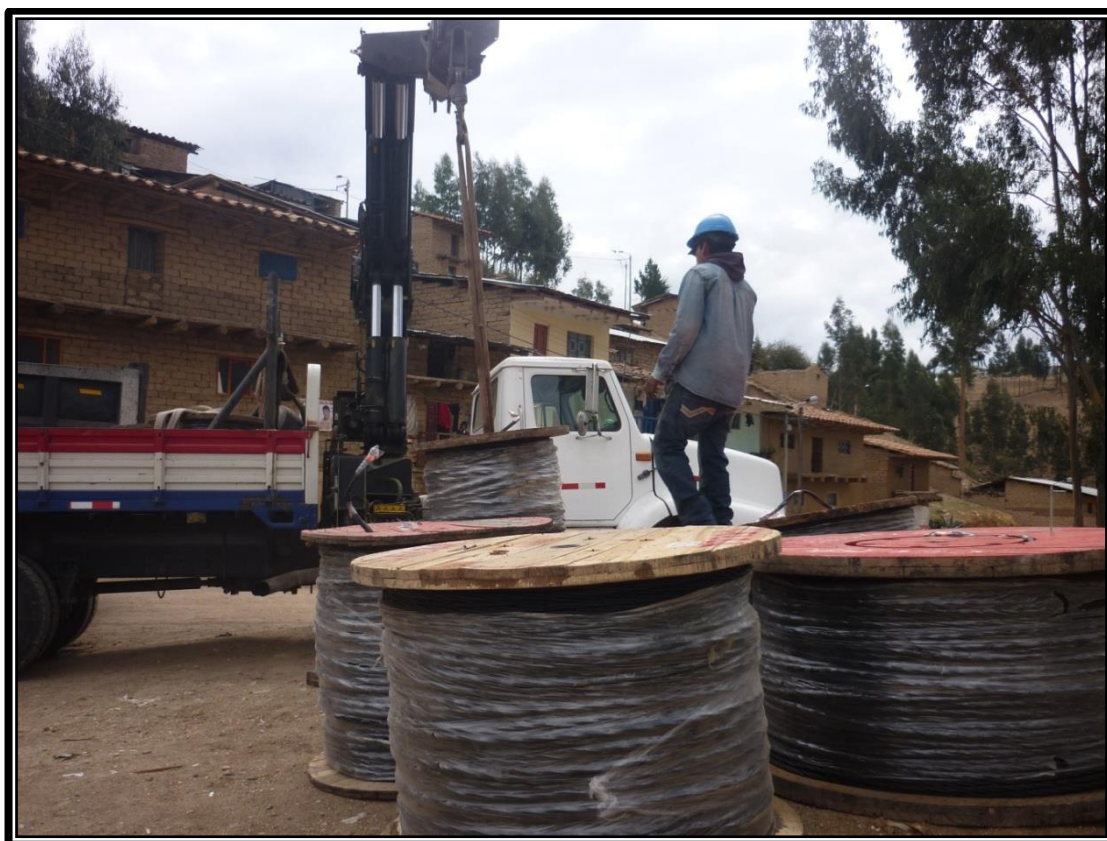
Figura 8: Llegada de materiales como cable de cobre a Obra 003 -2018.
