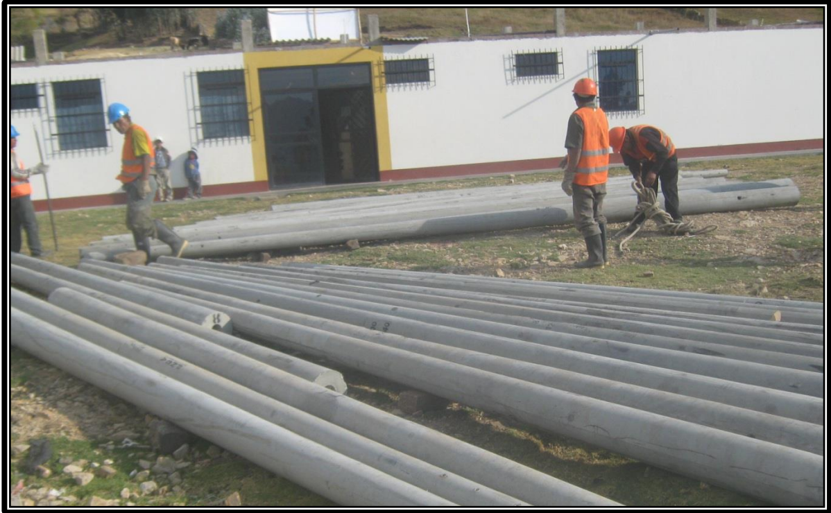
Figura 11: Distribución de postes a Obra 003 -2018.
