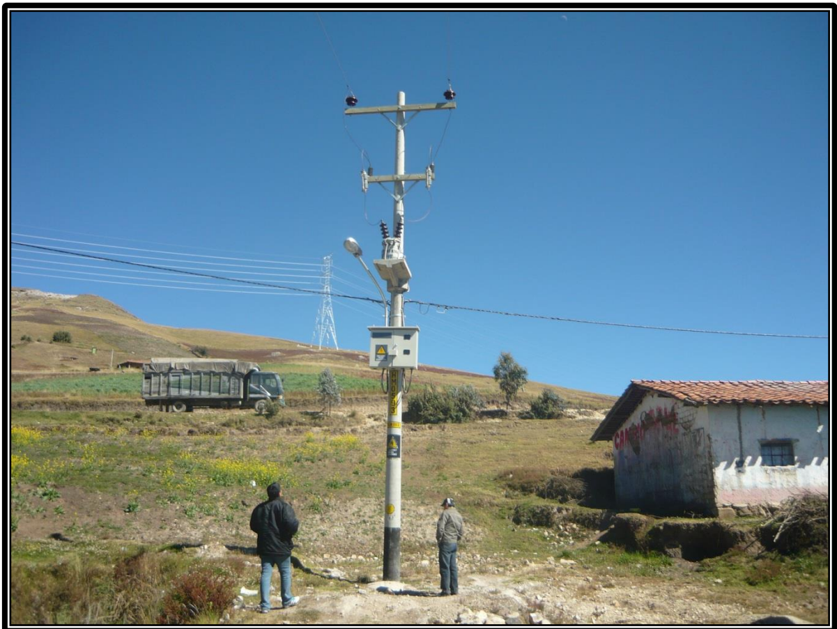
Figura 14: Culminación de Obra 003 -2018.
