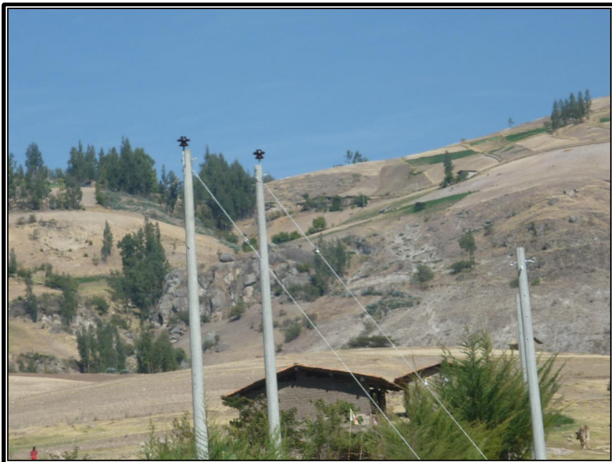
Figura 2: Lugar donde se ejecuta la Obra N° 004-2018. Caserío Colpa Seca- Distrito de Angamarca – Provincia de Santiago de Chuco – Departamento de La Libertad
