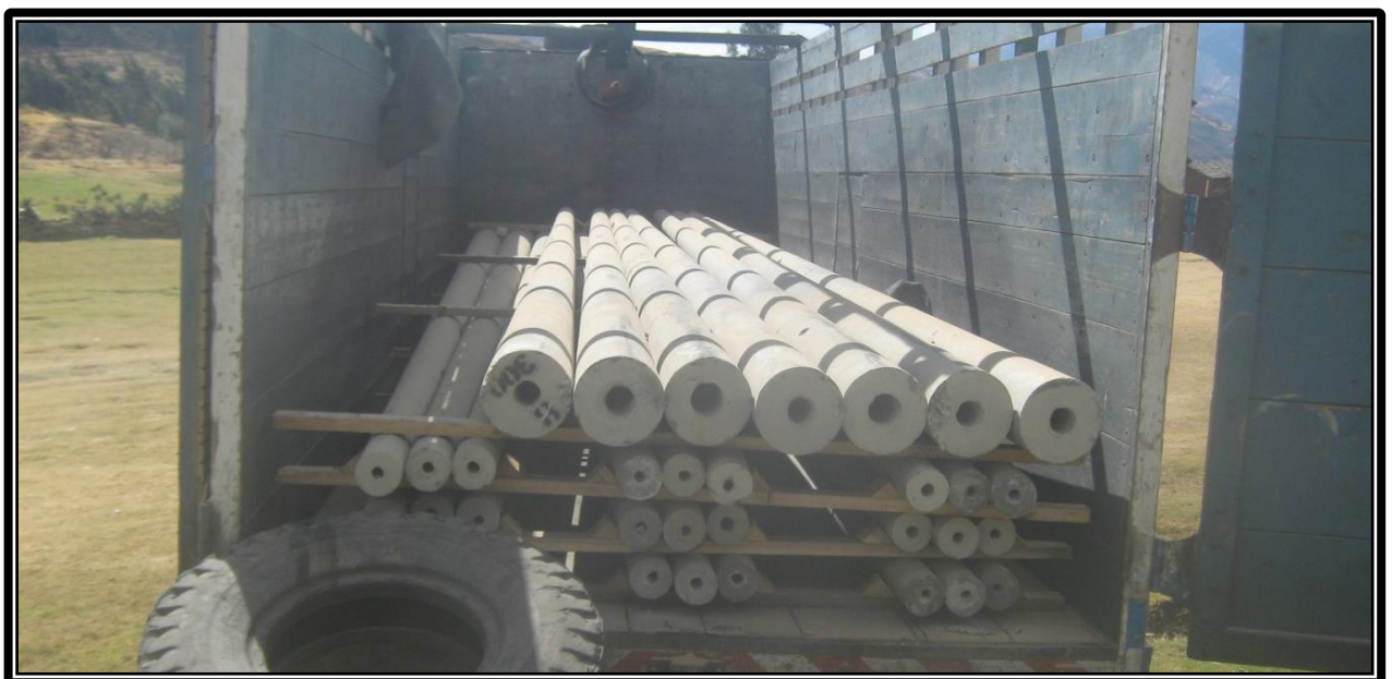
Figura 10: Llegada de postes a Obra 003 -2018.
