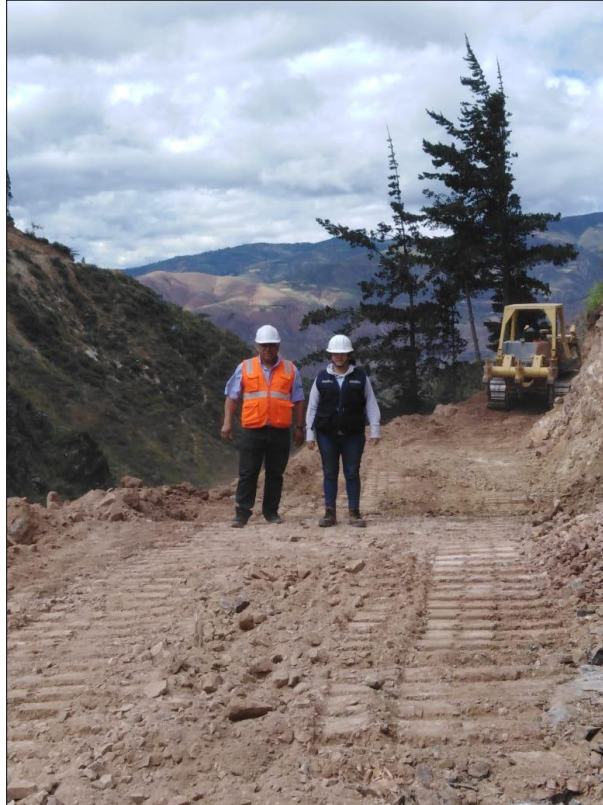
Foto N°09: Trabajos de movimiento de tierras, corte a media ladera.
