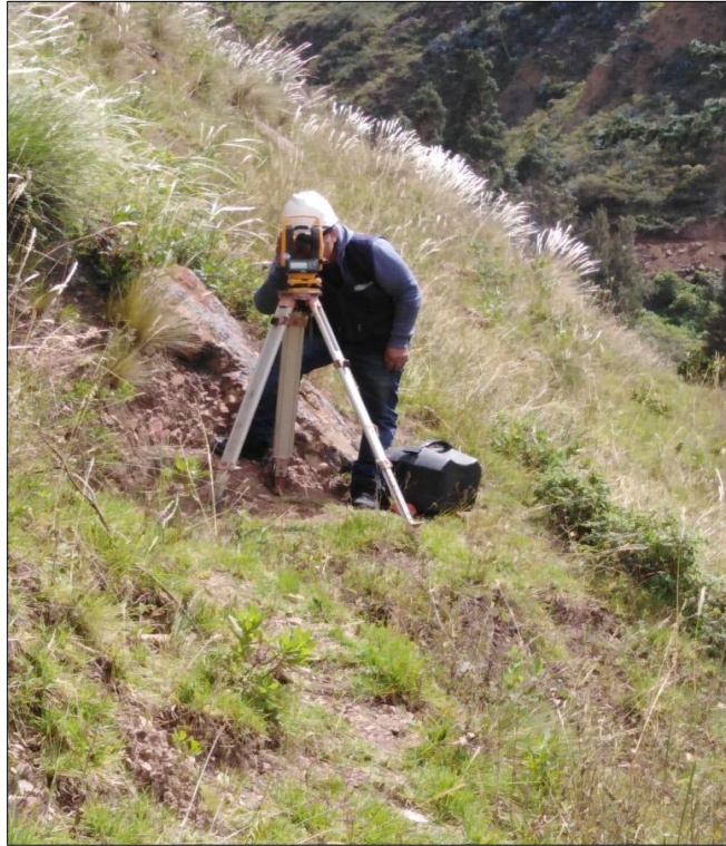
Foto N°05: Trabajos de Replanteo en proyecto con equipo de estación total
