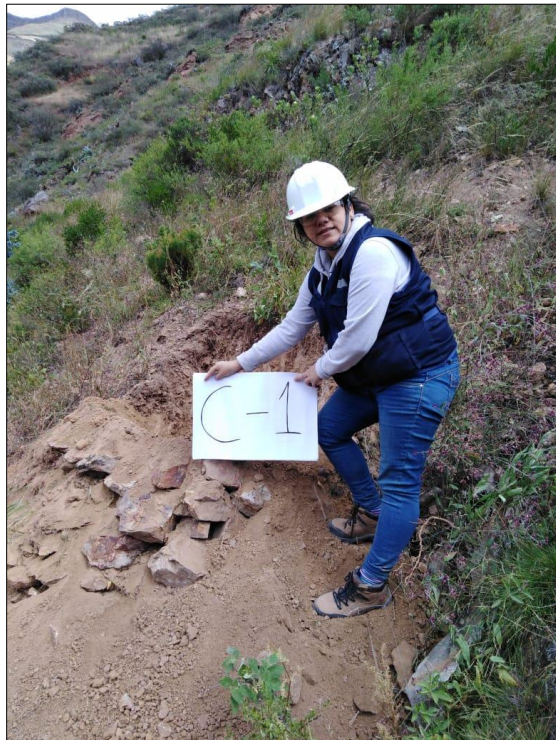
Foto N°07: Trabajos de exploración de suelos y toma de muestras mediante calicatas.
