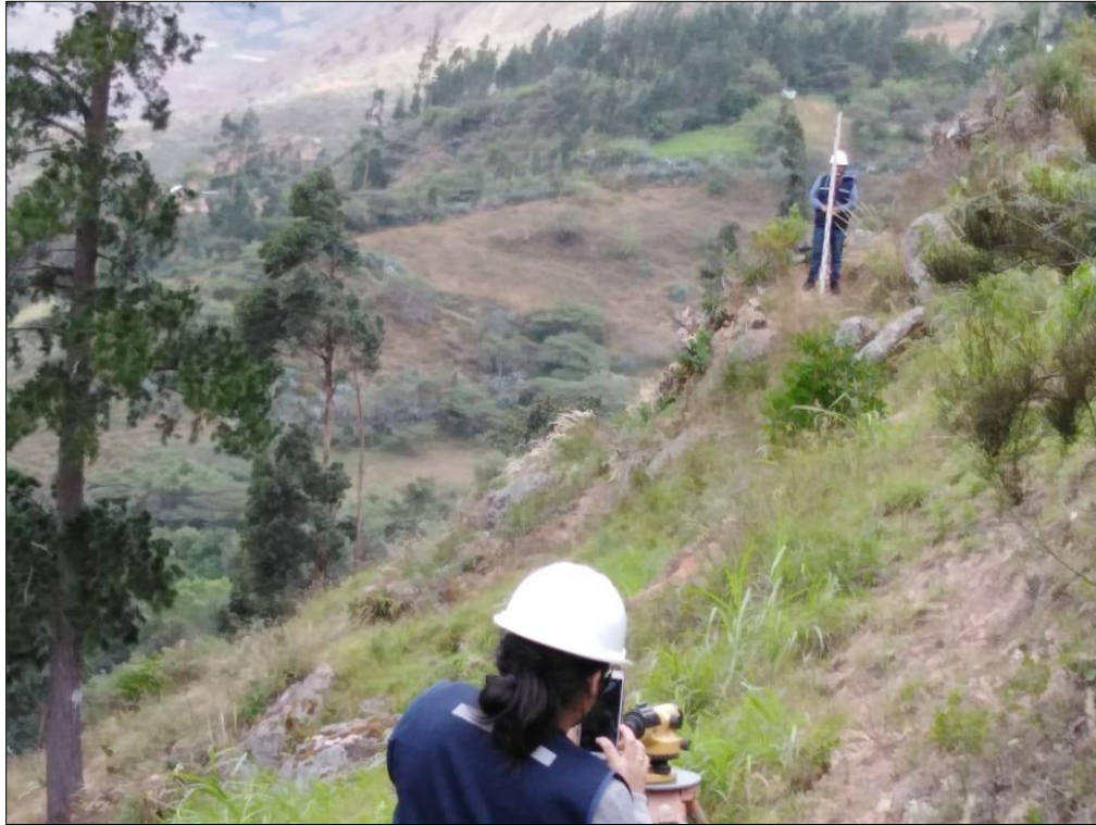
Foto N°04: Trabajos de Nivelación en proyecto, verificación de pendientes longitudinales
