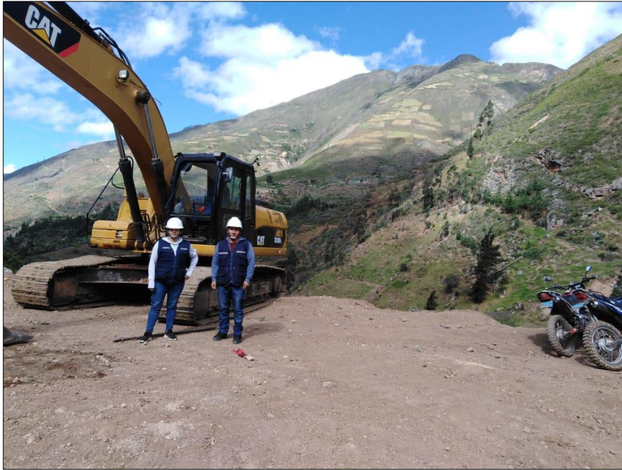
Foto N°10: Trabajos de movimiento de tierras, perfilado en taludes.
