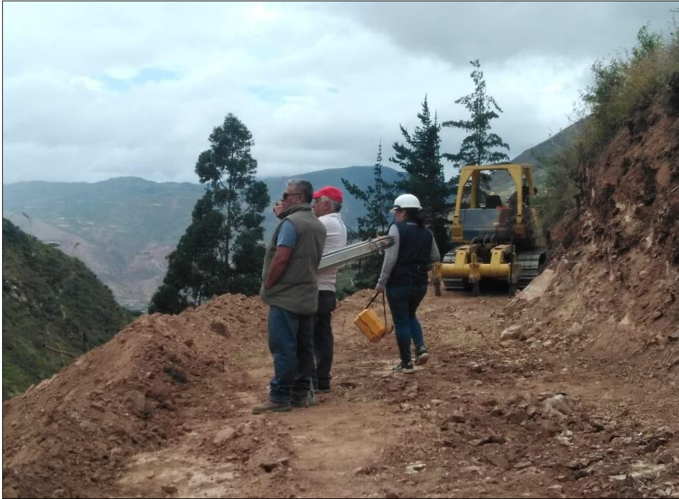
Foto N°08: Trabajos de movimiento de tierras, corte a media ladera.
