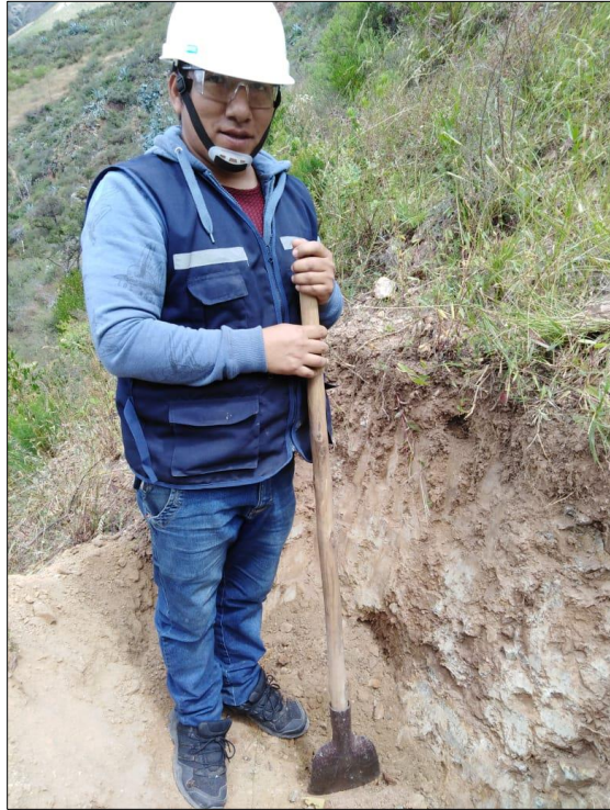
Foto N°06: Trabajos de exploración de suelos y toma de muestras mediante calicatas.
