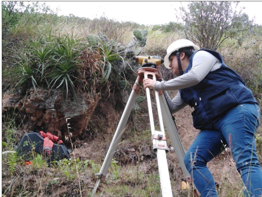
Foto N°05: Trabajos de Nivelación en proyecto, verificación de pendientes longitudinales
