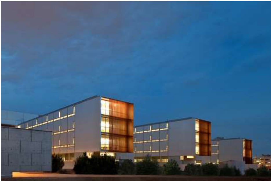
Figura 17: Control de iluminación y ventilación
