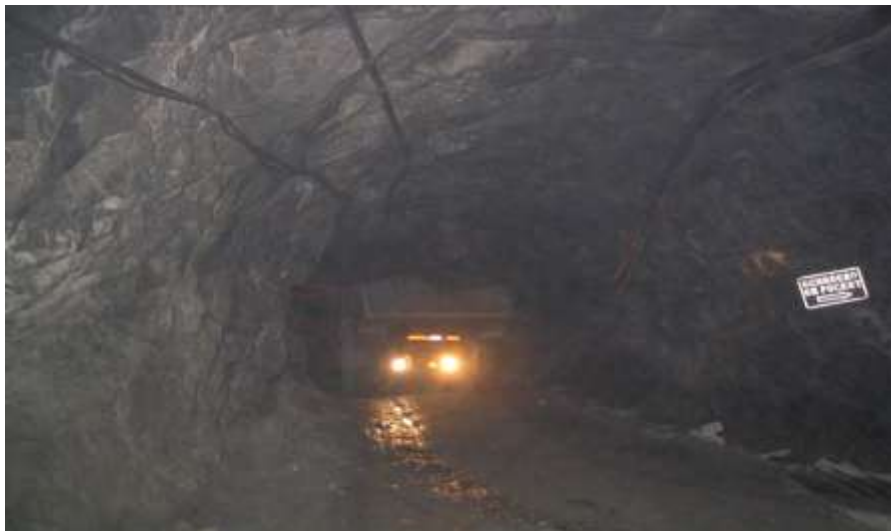
Figura 3. Vías de transporte en mal estado con agua. Dumper TH 315
