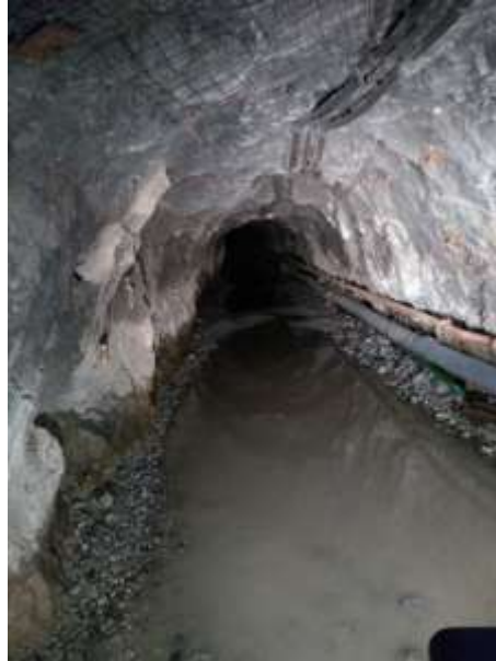
a) Vías sin cunetas con problemas de anegamiento
