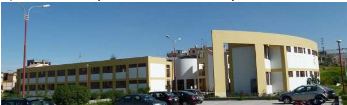
Figura 19. Fachada diseñada a base de muros no paralelos entre si
