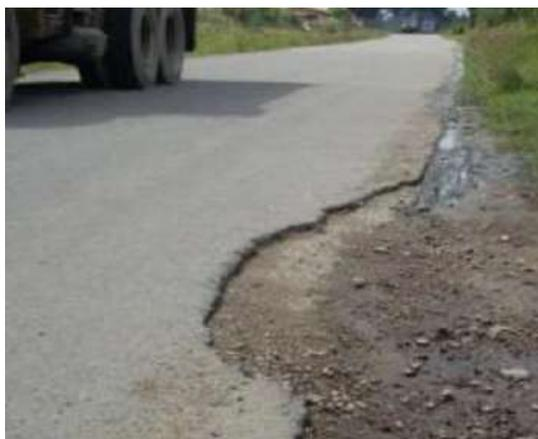
*Figura 12 : Desintegración de Bordes de Pavimento*
