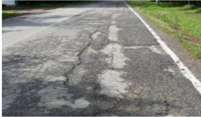
*Figura 10: Perdida de Agregado*
