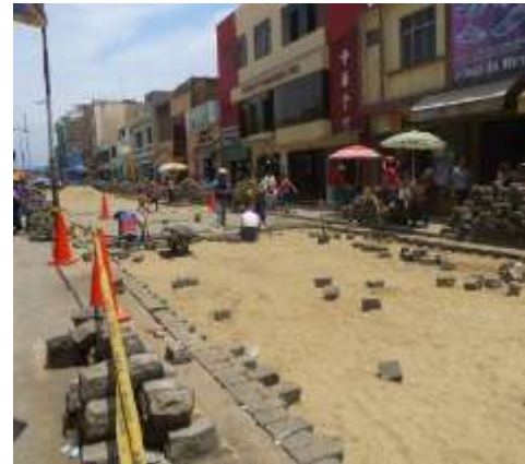
Figura 46. Instalación de adoquines del Jr. Grau – Trujillo
