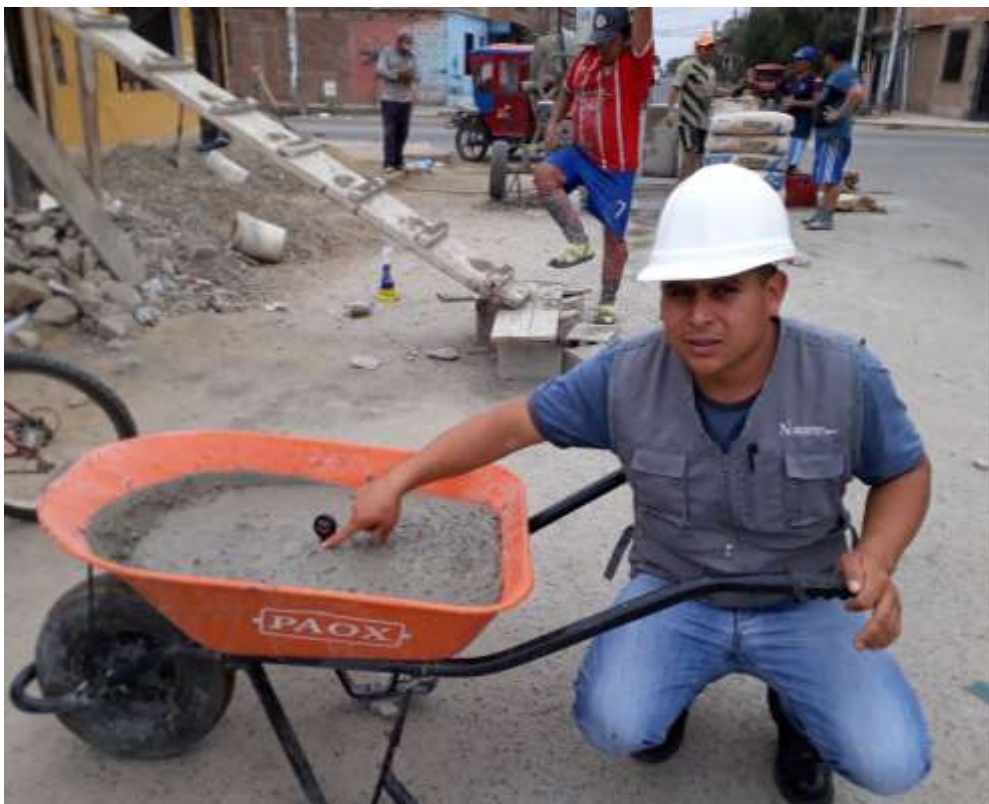
Figura N.º 09 Determinación de la temperatura de la mezcla de concreto convencional en estado fresco.
