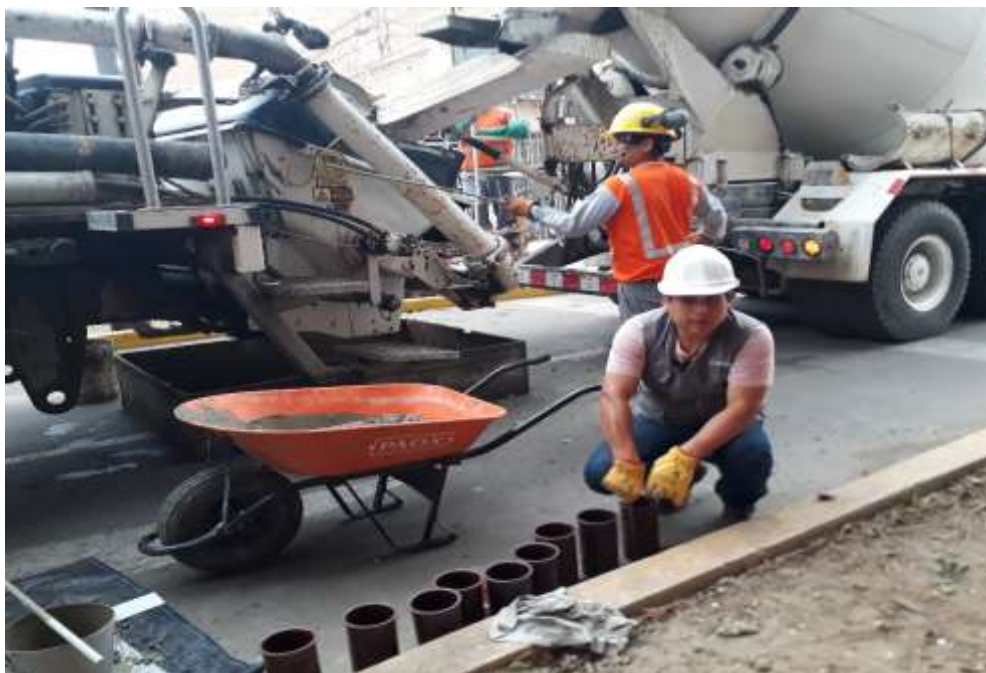
Figura N.º 04 Elaboración de especímenes de concreto premezclado en campo.
