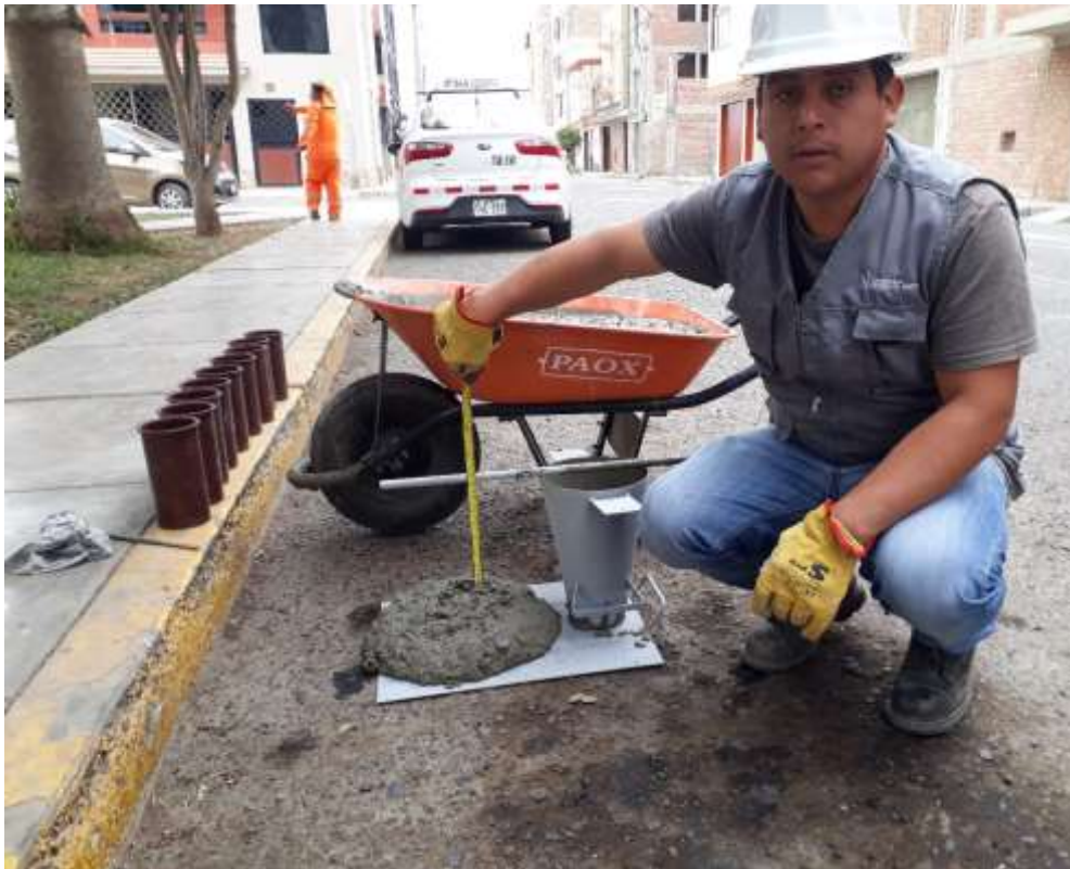
Figura N.º 03 Medición del asentamiento de concreto premezclado.
