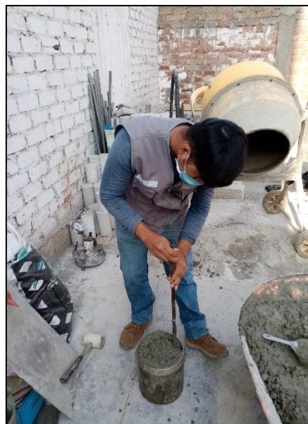
Figura 76: Llenado de molde con concreto Fuente: Autores de tesis
