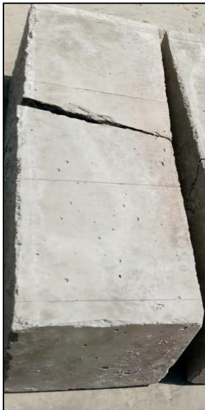
Figura 107: Corte central con de concreto tradicional Fuente: Autores de tesis
