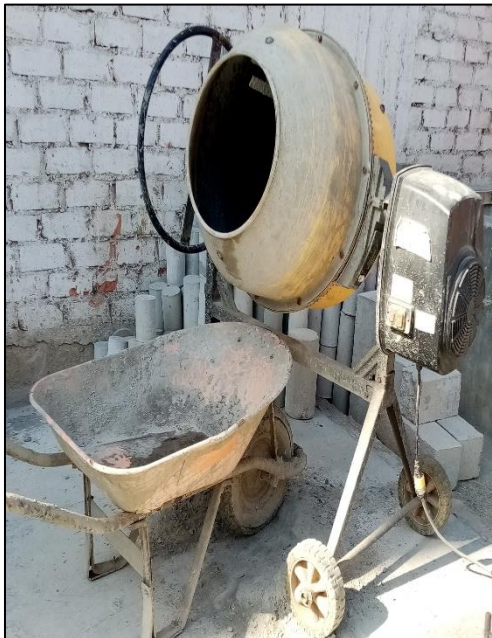
Figura 64: Mezcladora y carretilla para realizar la mezcla Fuente: Autores de tesis
