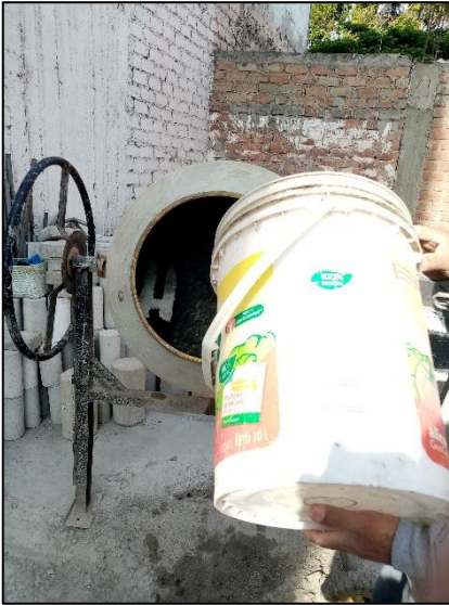
Figura 65: Mezclado de materiales en el trompo Fuente: Autores de tesis
