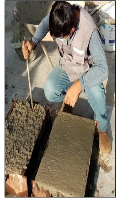
Figura 84: Acabado del llenado de probetas prismáticas Fuente: Autores de tesis
