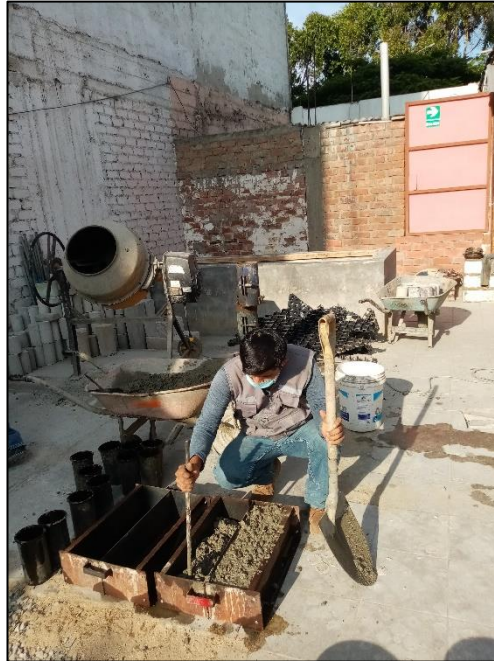
Figura 85: Chuseado de concreto en vigas Fuente: Autores de tesis
