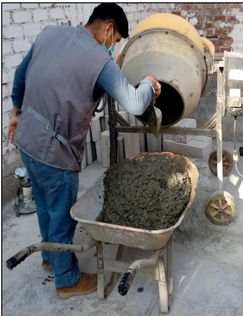
Figura 70: Vaciado de mezcla a la carretilla Fuente: Autores de tesis
