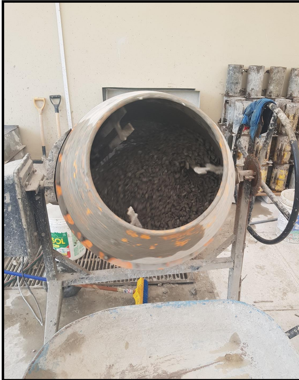
Imagen N°18: Preparación de mezcla en trompo.
