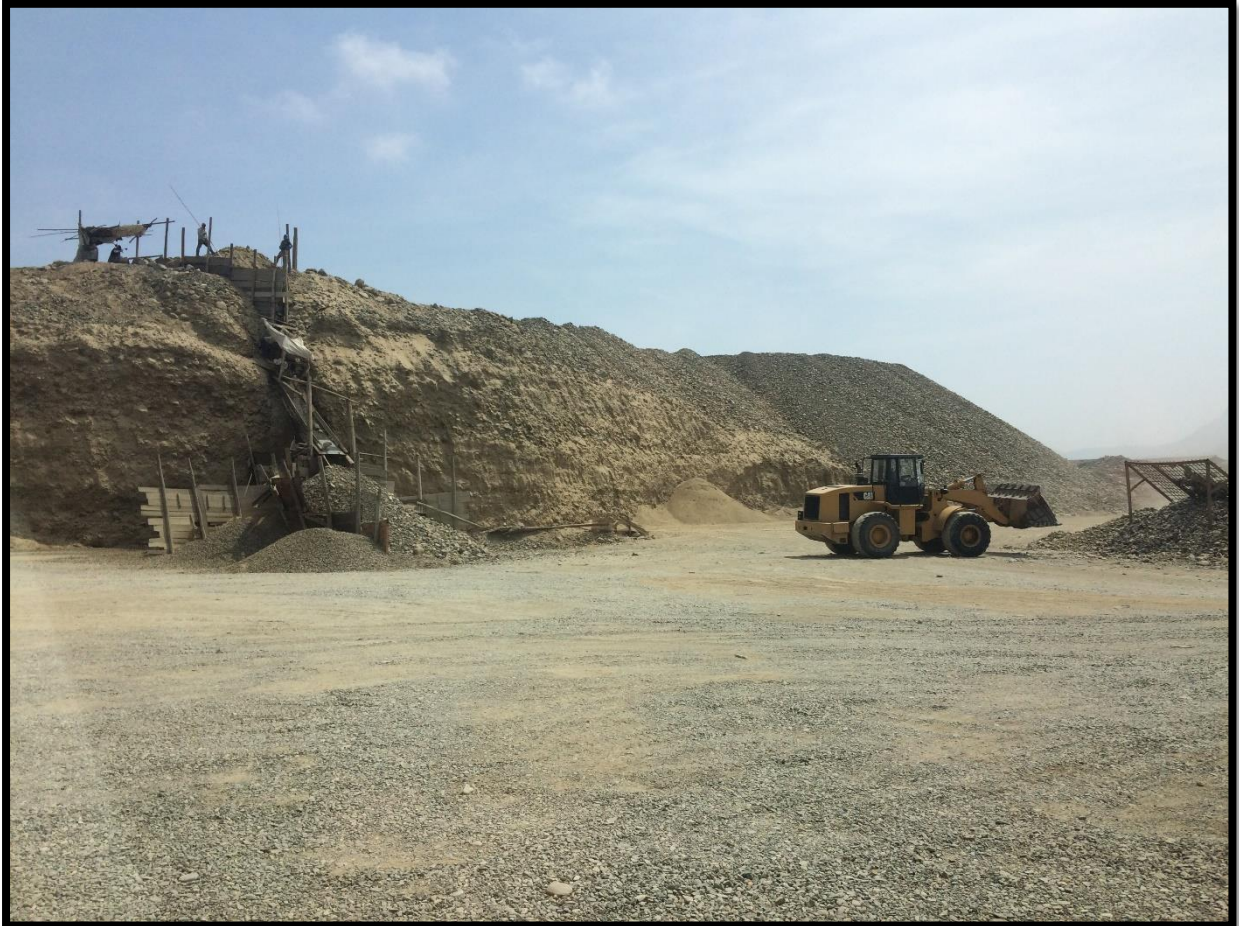
Imagen N°05: Visita a la cantera de Huanchaco para poder extraer el agregado.
