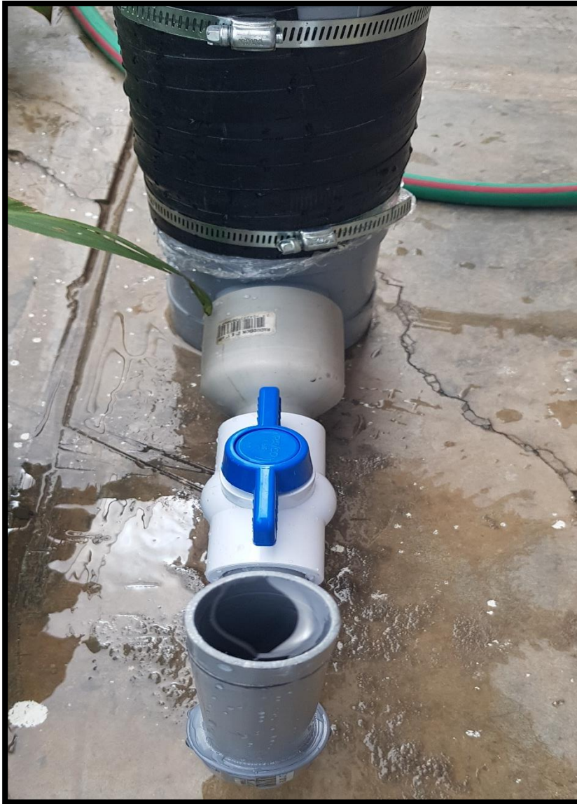
Imagen N°41: Punto de salida de agua del permeámetro.
