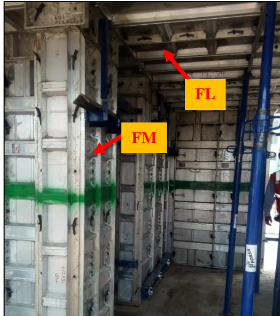
Figura 21: Formaletas Verticales y horizontales. Fuente: Edificación Proyecto 02
