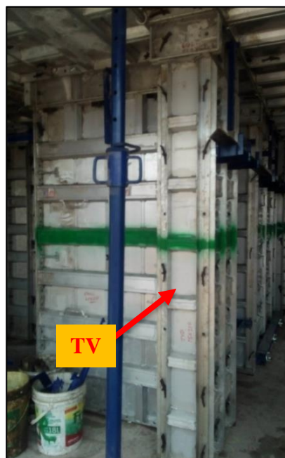
Figura 22: Tapamuro Vertical (TV). Fuente: Edificación Proyecto 02
