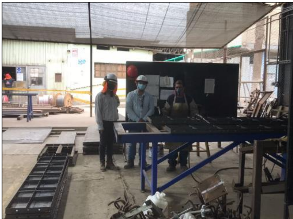
Figura 114: Soldadura de Formaleta. Fuente: proyecto 01
