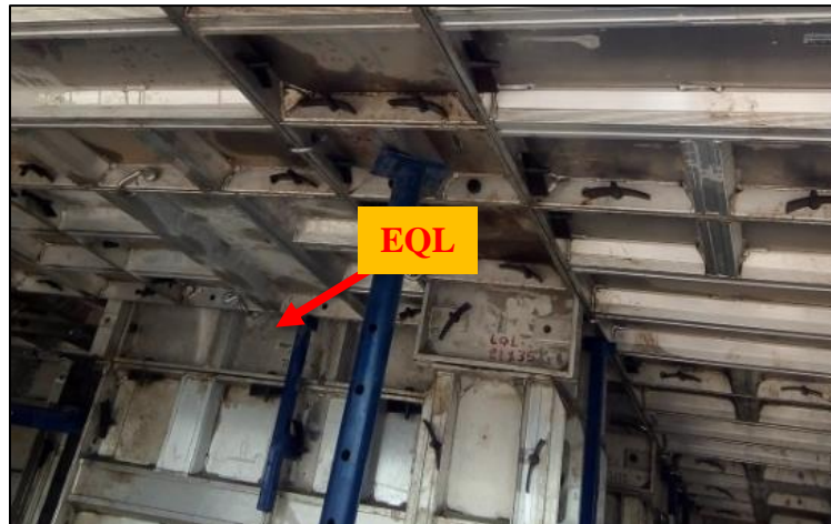
Figura 23: Esquinero Losa. (EQL). Fuente: Edificación Proyecto 02
