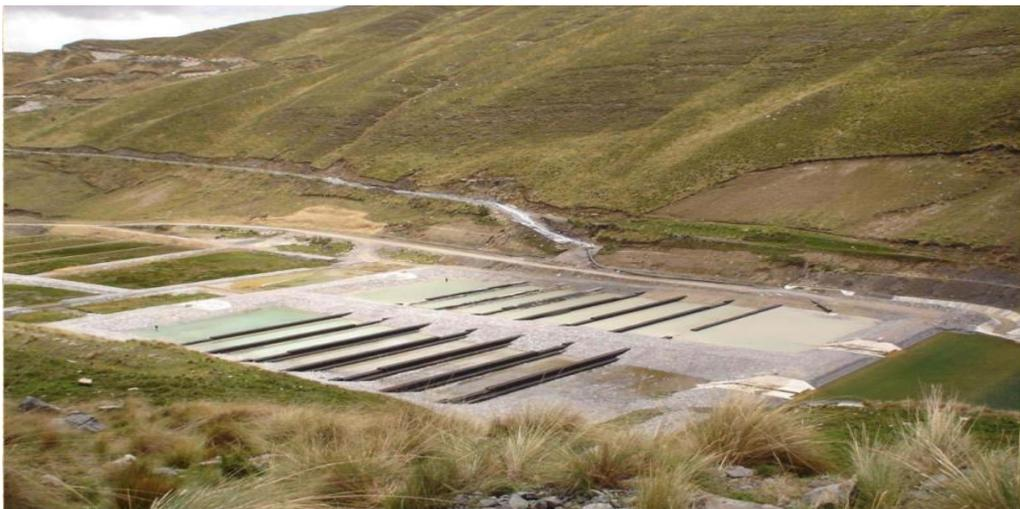
*Figura 1* Estructura del sistema en forma de serpentín. Tomada del Tratamiento de agua por medio de humedales artificiales (wetland) – Antamina (2007, p. 10)
