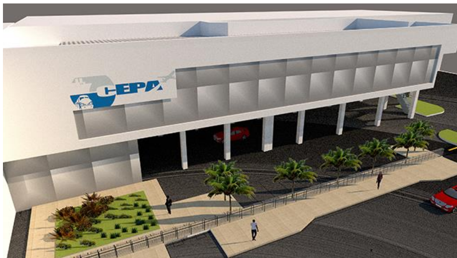
Figura 13. Modelado final aeropuerto internacional de El Salvador Monseñor Óscar Arnulfo Romero y Galdámez Fuente: (COSAPI, 2021)
