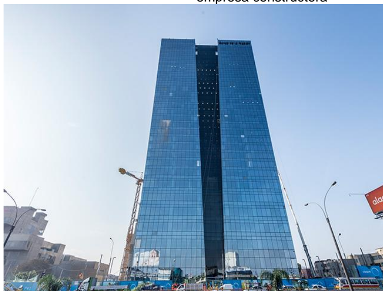
Figura 15. Nueva sede del Banco de la Nación Fuente: (COSAPI, 2021)
