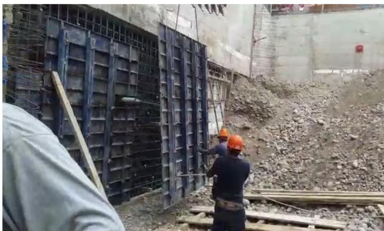
*Figura 104.* Izaje y colocación de encofrado prearmado en muro anclado
