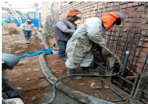
*Figura 73.* Vaciado de concreto en muro con bomba telescópica
