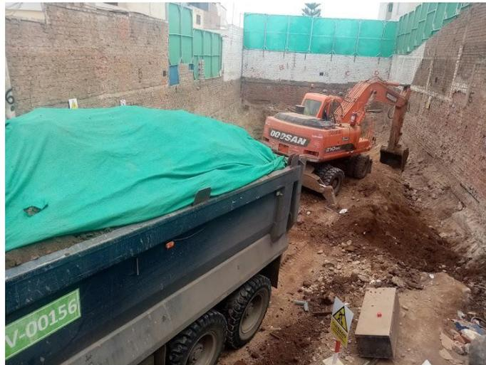
*Figura 63.* Excavaciones del primer anillo y eliminación
