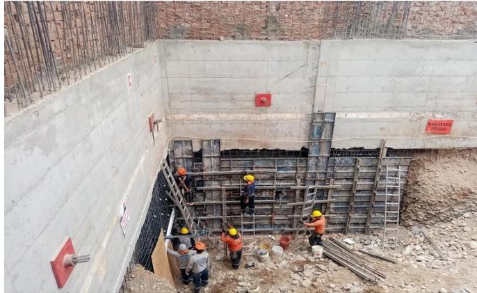
*Figura 43.* Encofrado de muro anclado - RMS (2019)
