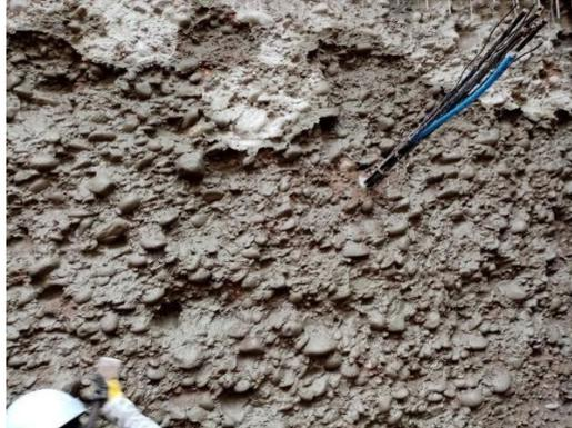
Figura 67. Pañeteo de muro con pasta de cemento más yeso
