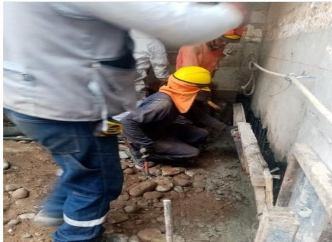
Figura 83. Encofrado de cachimba a  $45^\circ$
