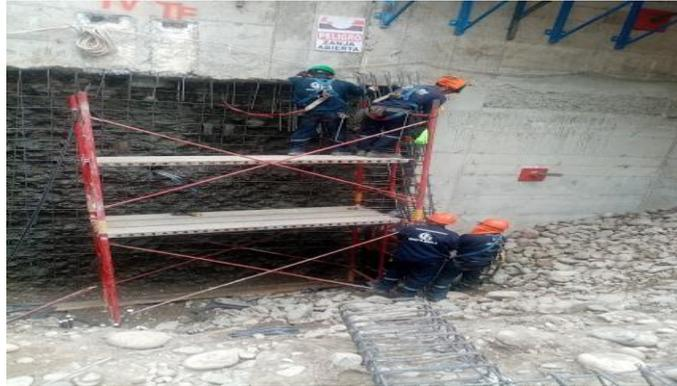
*Figura 42.* Colocación de acero en muro anclado
