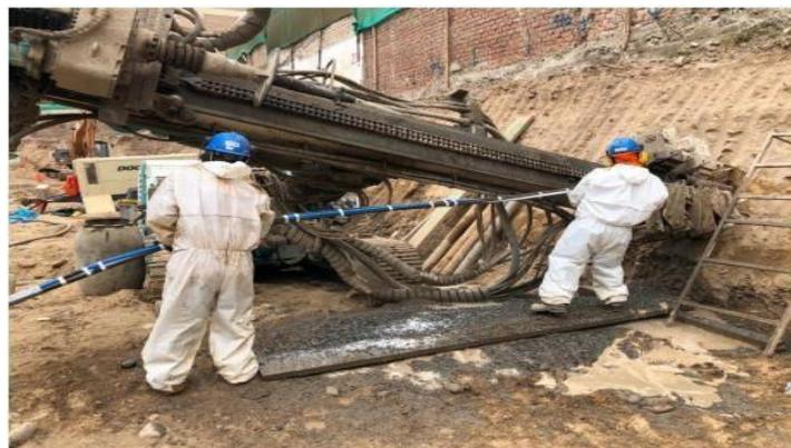
*Figura 38.* Colocación de anclajes
