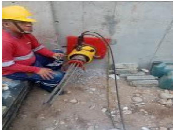
*Figura 74.* Tensado de muro 1.12
