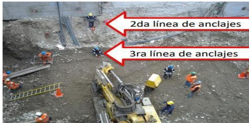
Figura 47. Proyección de puntos para anclajes proyectados.
