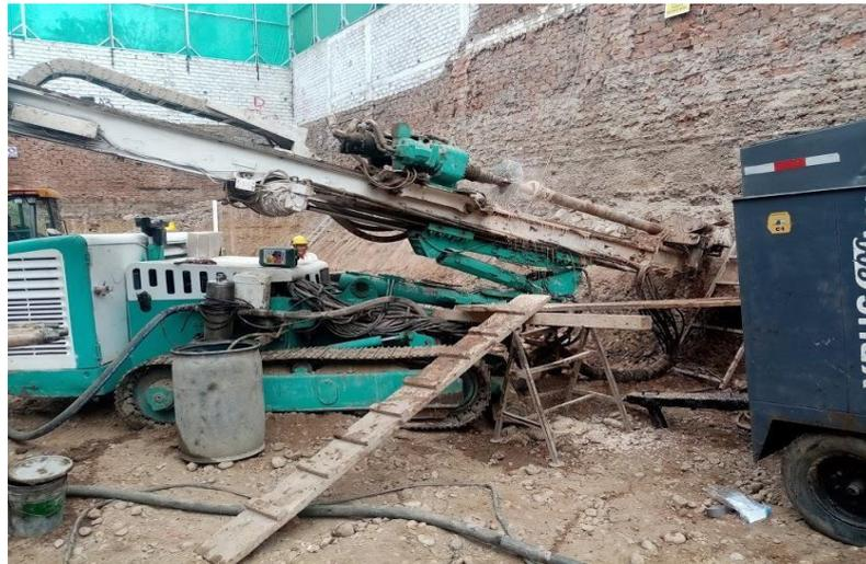
*Figura 37.* Perforación de anclajes Madre Selva (2019)
