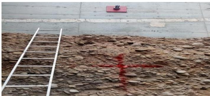
Figura 36. Trazo de puntos de anclaje
