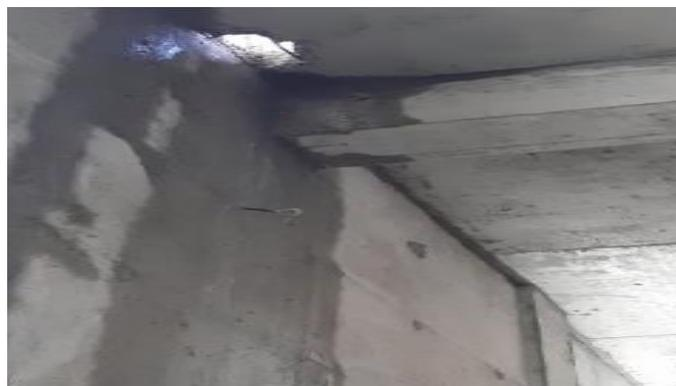
*Figura 81.* Filtración de agua en muro anclado
