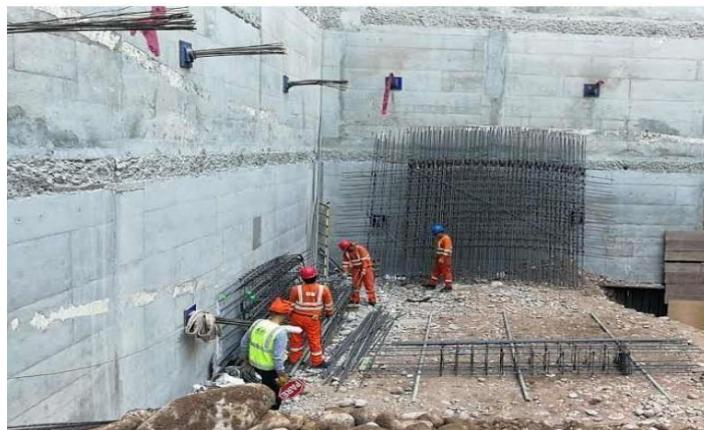
Figura 93. Prearmado de núcleos de placas perimetrales
