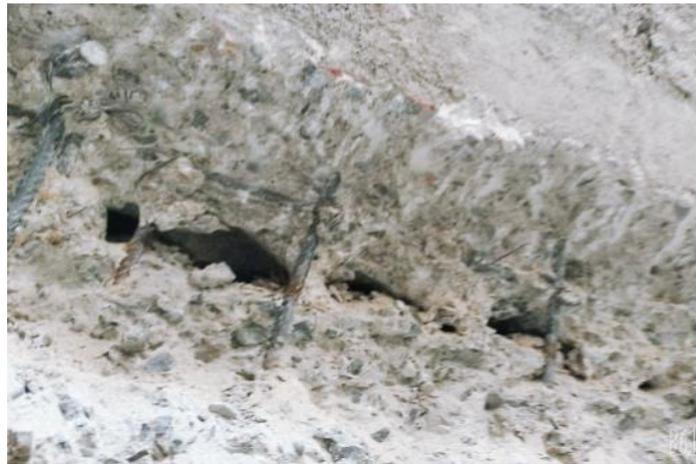
*Figura 80.* Cangrejas internas de muro vaciado
