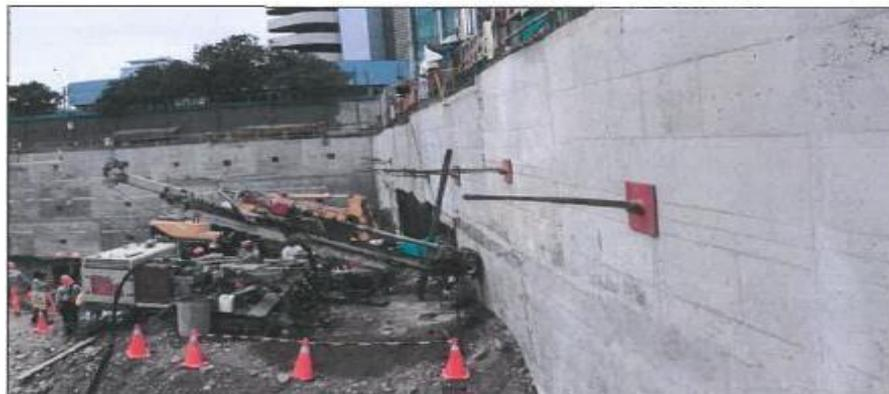
*Figura 46.* Perforación de anclajes sobre muro vaciado.
