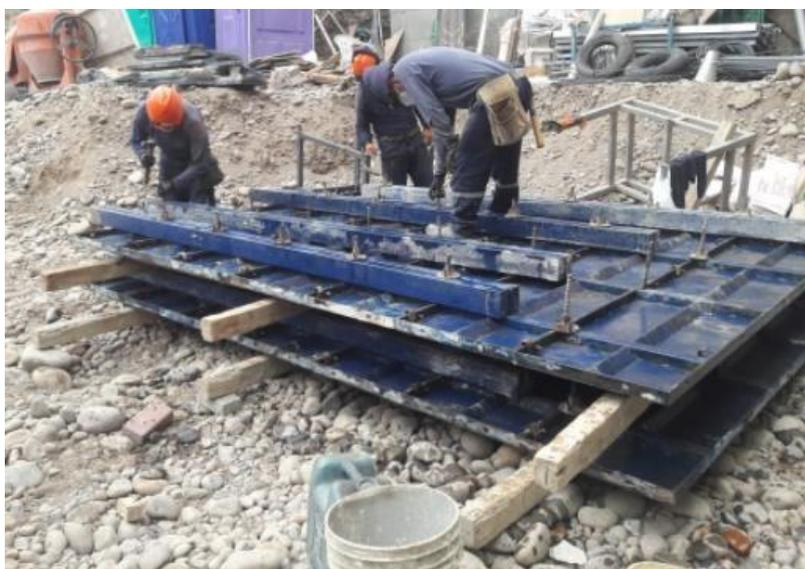
*Figura 103.* Armado de paneles para encofrado prearmado
