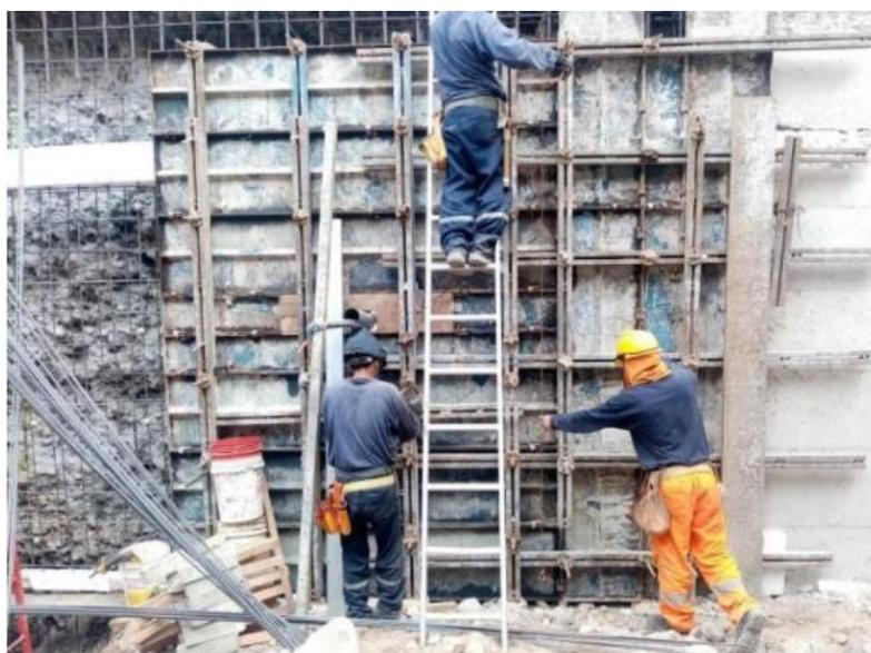
*Figura 105.* Colocación de encofrado en trazo
