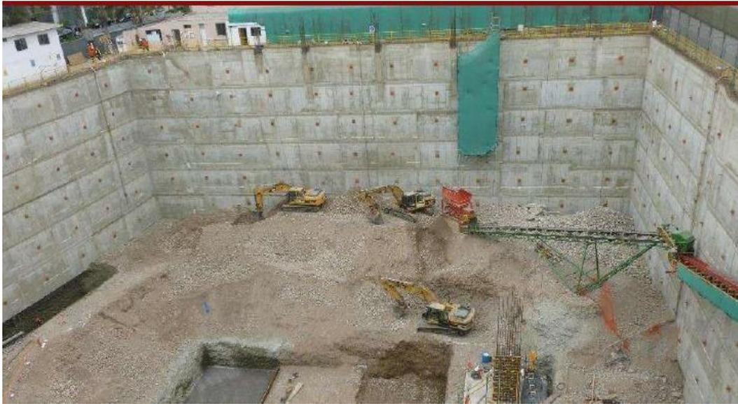
*Figura 23.* Estabilización de taludes con el método de muros anclados
