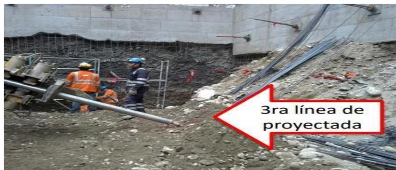
Figura 88. Proyección de anclaje para perforación
