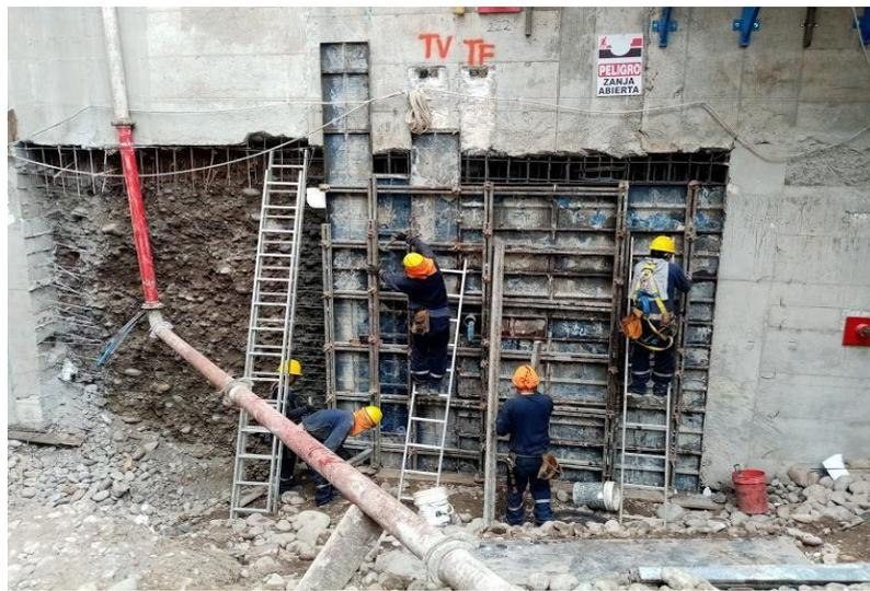
*Figura 99.* Encofrado insitu sobre trazo en tablón
