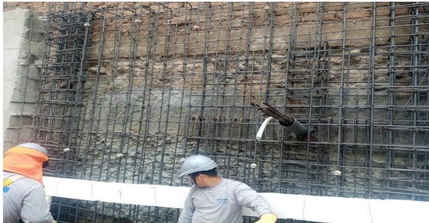
*Figura 70.* Colocación de cajuelas de tecnopor para empotramiento de losas
