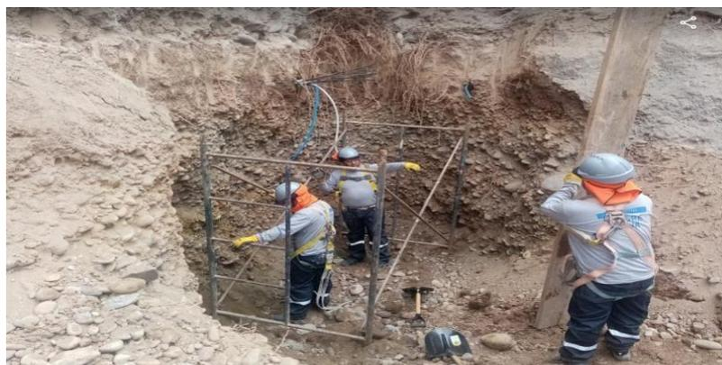
*Figura 66.* Perfilado y picado de rebabas de muros colindantes
