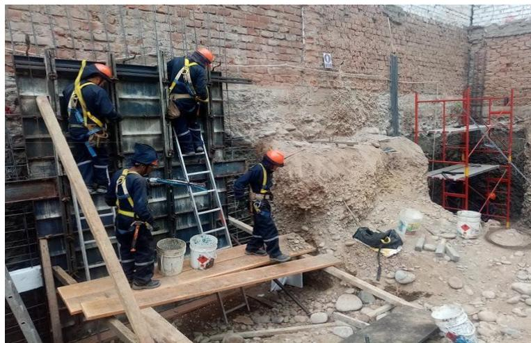
*Figura 71.* Encofrado de muro anclado en el primer anillo
