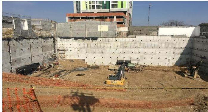
*Figura 30.* Estabilización de taludes en sótanos
