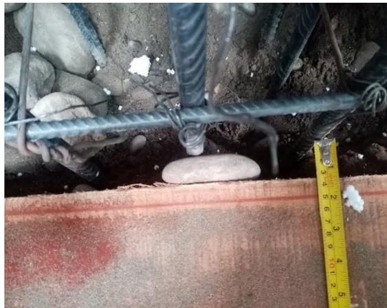
*Figura 69.* Relleno de mechas con material de suelo excavado
