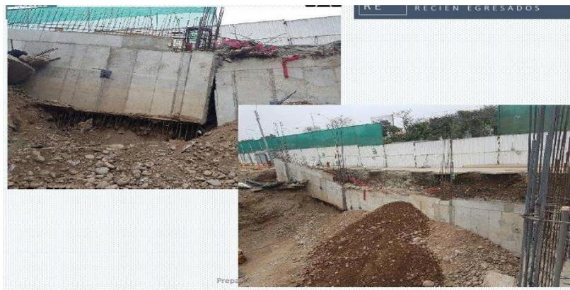
*Figura 28. Colapso de muros anclados por errores constructivos*
