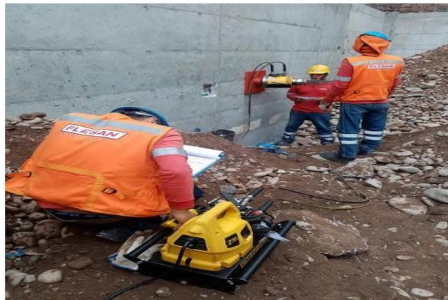
*Figura 45.* Tensado de anclajes
