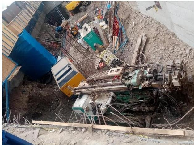
Figura 89. Ingreso de perforadora con grúa móvil
