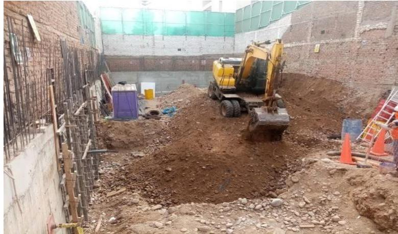
*Figura 72.* Apuntalamiento de encofrado con material de excavación
