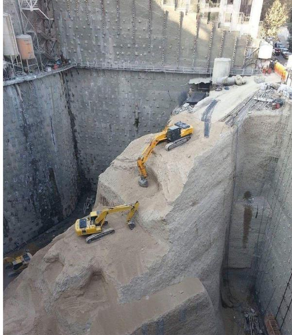
*Figura 24.* Estabilización de taludes de sótanos con el método Soil Nailing
