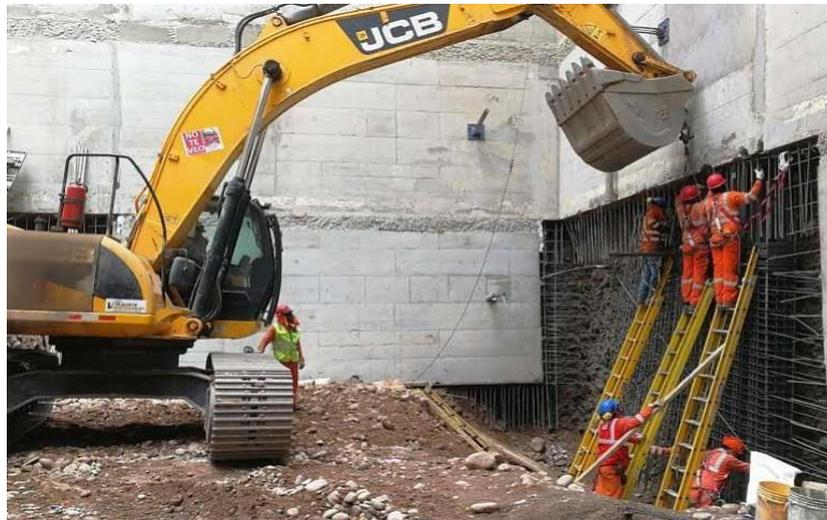
*Figura 94.* Colocación de núcleos prearmados en muro de tercer anillo
