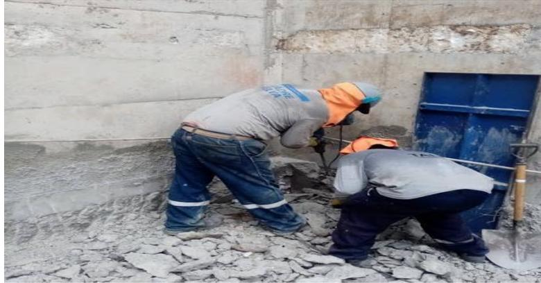
*Figura 85.* Picado de cachimbas de concreto
