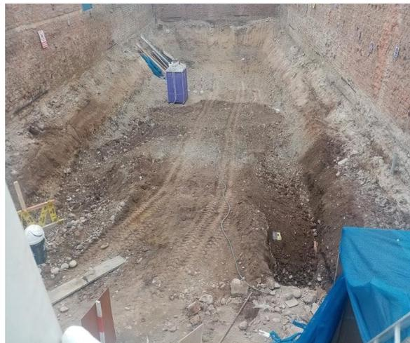
*Figura 64.* Rampa de tierra para ingresos de equipos de perforación
