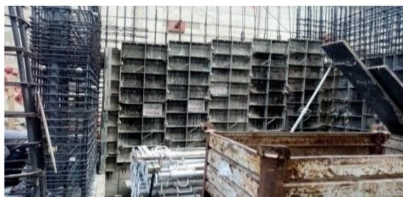
*Figura 8.* Encofrado de placas de cisterna Madre Selva (2020)
