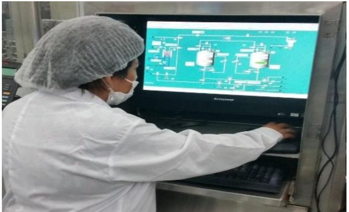
Figura 8. Desarrollo SCADA. Cliente Alicorp planta de margarina distrito de Carmen de la legua. Fuente: JYS Control Automation (2018)
