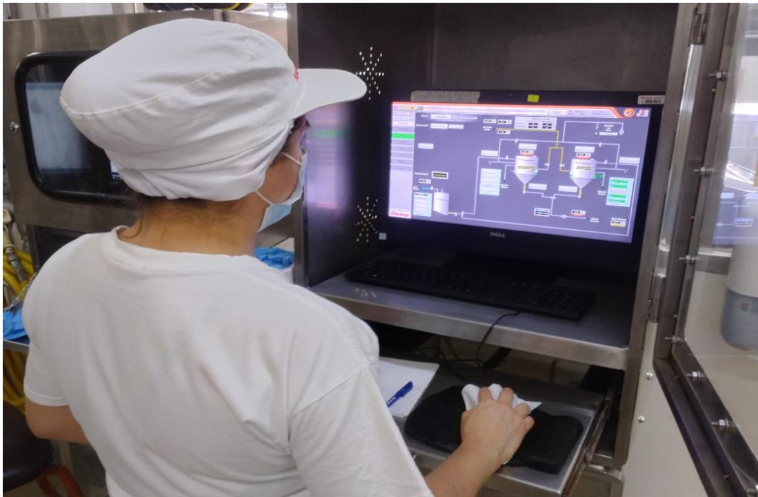
Figura 28. Manipulación de SCADA por operadores. Cliente Alicorp S.A. distrito Carmen de la Legua. Fuente: JYS Control Automation (2020)
