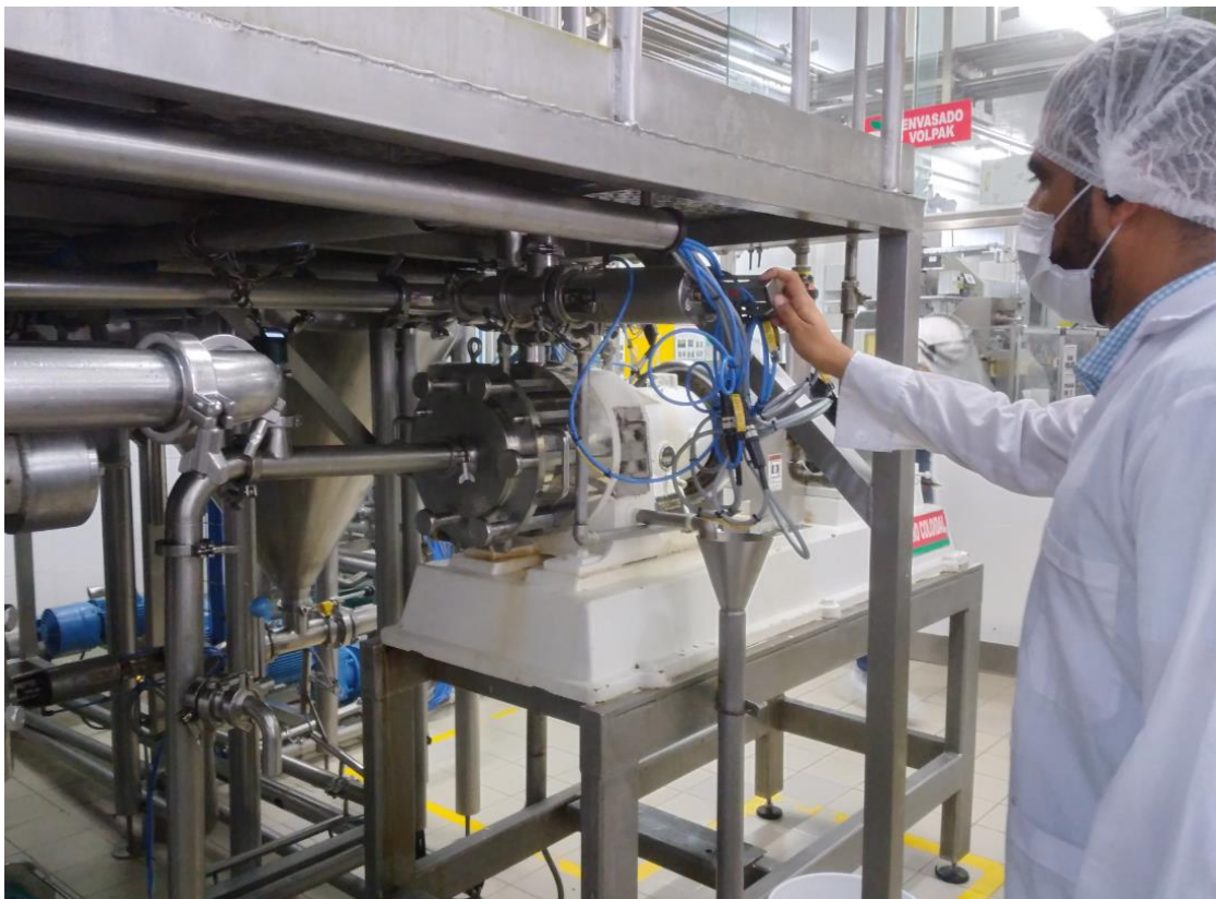
Figura 27. Prueba de equipos. Cliente Alicorp S.A. distrito Carmen de la Legua.
