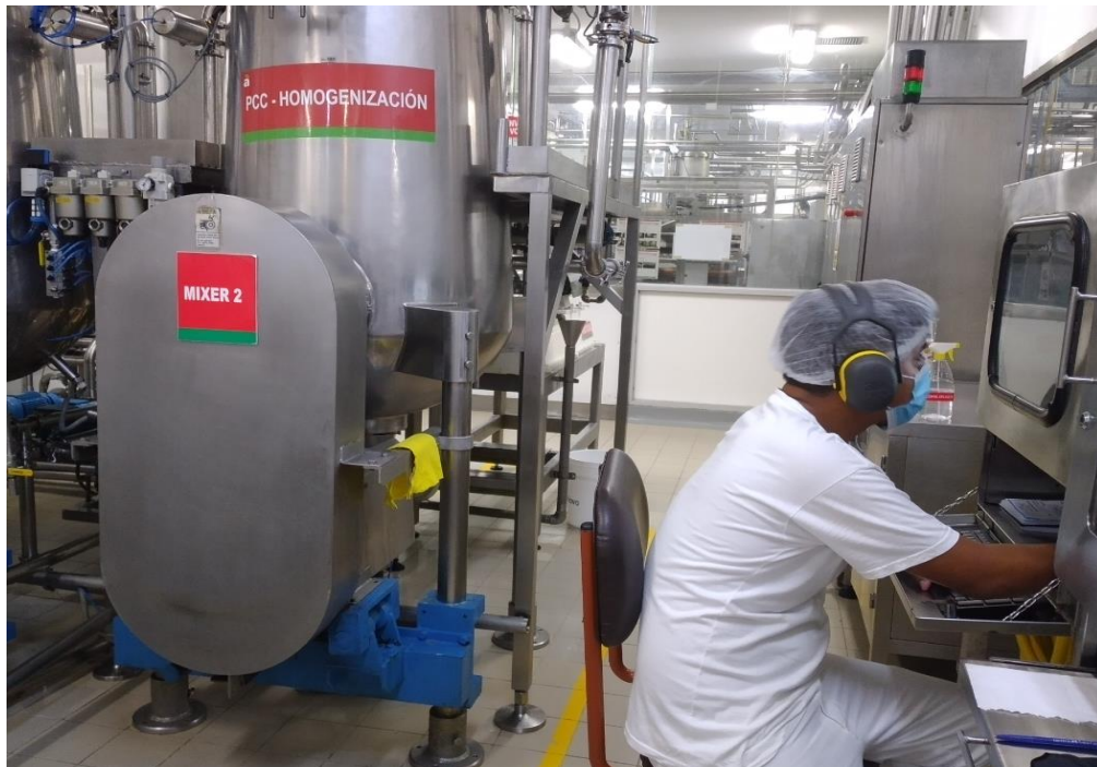
Figura 21. Planta de Salsas Automatizada. Cliente Alicorp S.A. Fuente: JYS Control Automation (2020)
