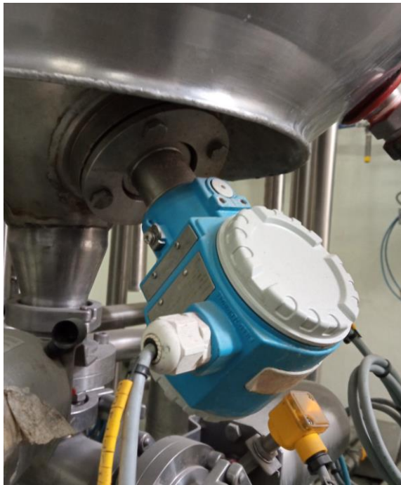
Figura 51. Transmisor de presión ubicado en tanque Premixer. Fuente: JYS Control Automation (2020)
