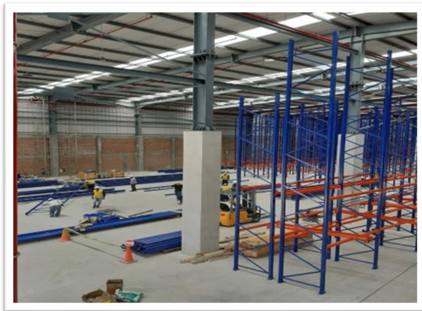
Figura 3. Armado de racks industriales en la planta de una empresa. Fuente: archivo personal del investigador.
