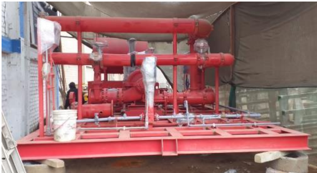
Figura 10. Estación de bombeo flotante rechazada por el cliente. Fuente: IFLUTECH S.A.C. (2018).
