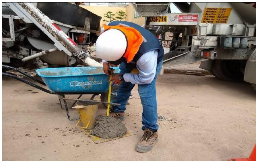
Figura 15: Verificación del slump del concreto utilizado en la obra
