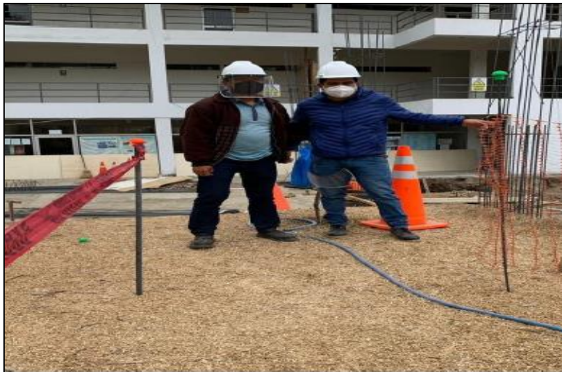
Figura 9: Excavación de Zanja para Zapatas
