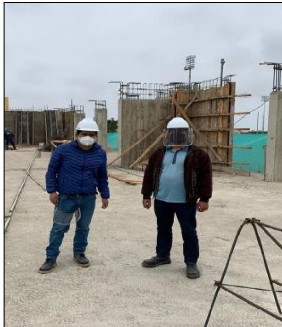
Figura 13: Encofrado del cuarto piso columnas y placas
