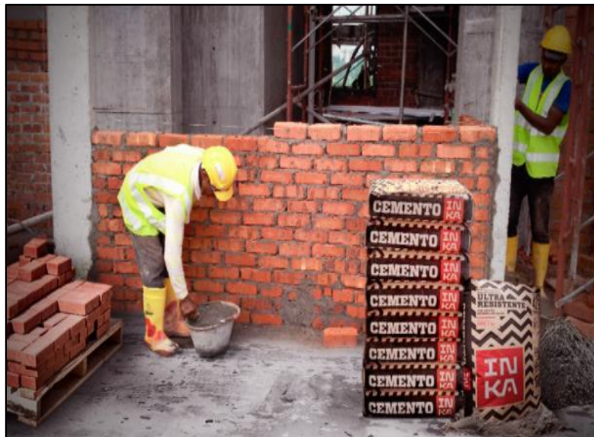
Figura 31: Muro no Portante.
