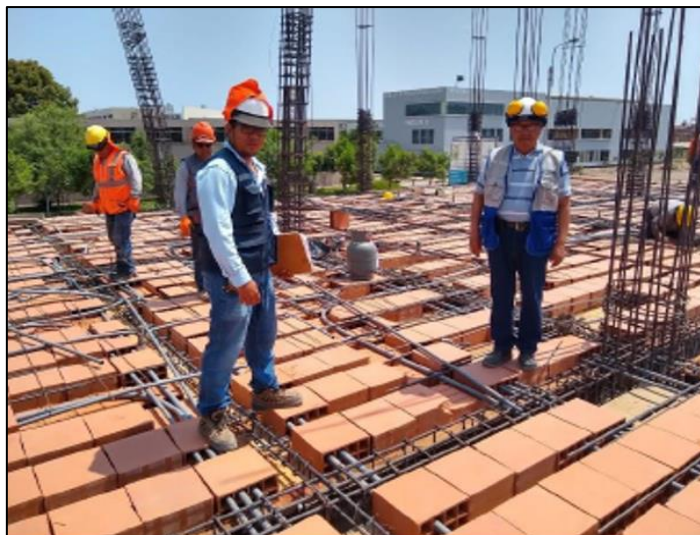
Figura 3. Armado e instalación de techo aligerado
