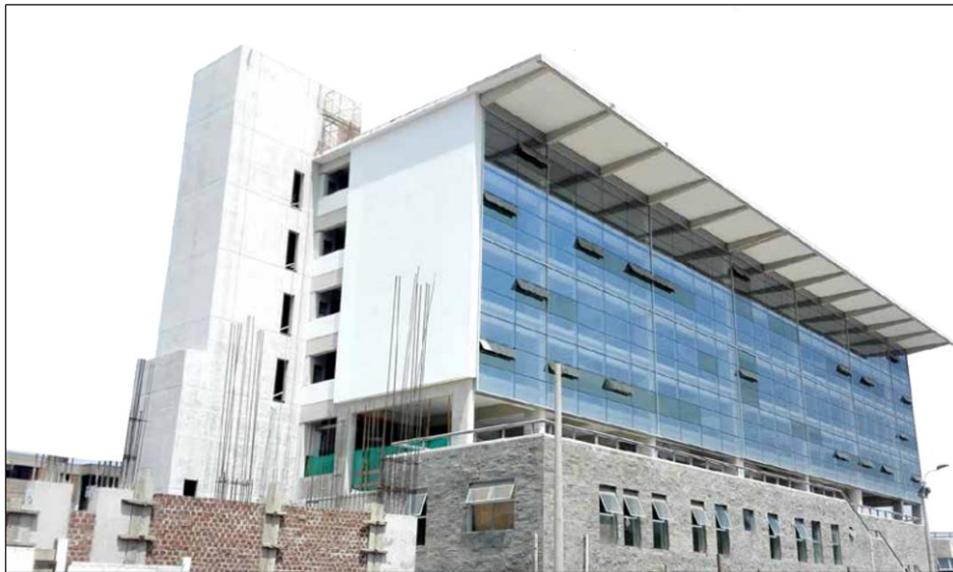
Figura 26: Mejoramiento y/o reconstrucción de la Facultad de Ingeniería de Petróleo
