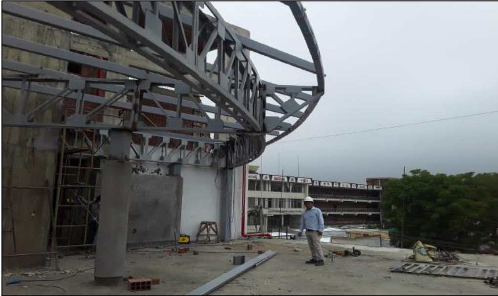
Figura 20: Colocación de estructura metálica
