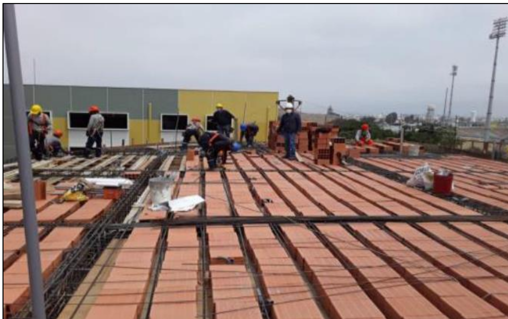
Figura 14: Techo del cuarto piso presencia del Asistente del Inspector
