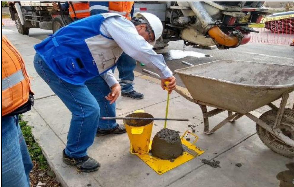
Figura 16: Verificación del slump del concreto utilizado en la obra
