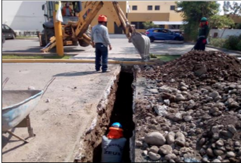
Figura 8. Excavación para tuberías
