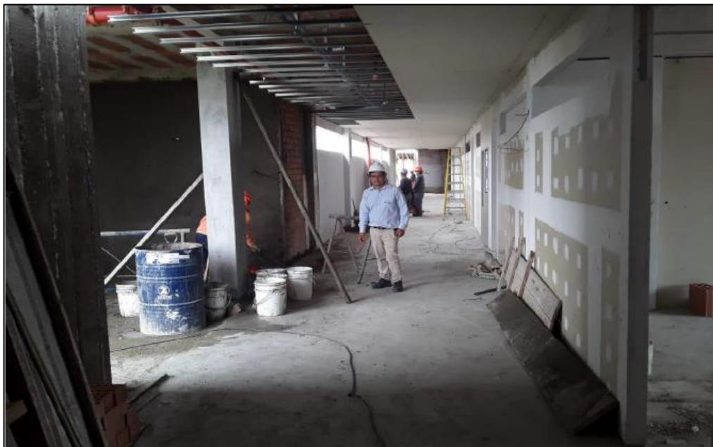
Figura 19: Tarrajeo y colocación de cielo raso drywall
