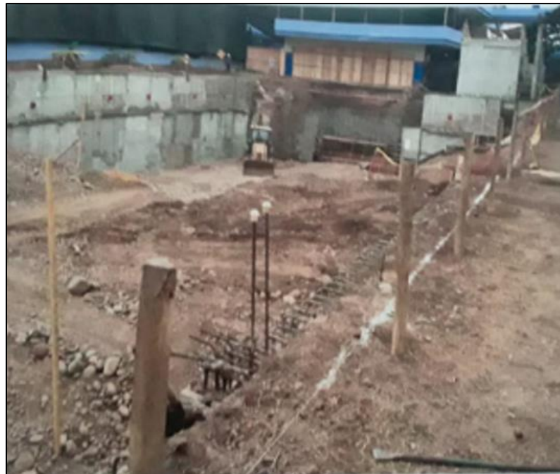
Figura 7. Control de trazo y replanteo para excavación manual de viga de coronación
