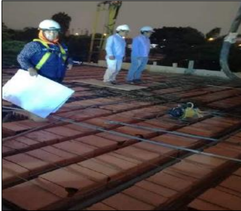
Figura 6. Vaciado de concreto en techo aligerado
