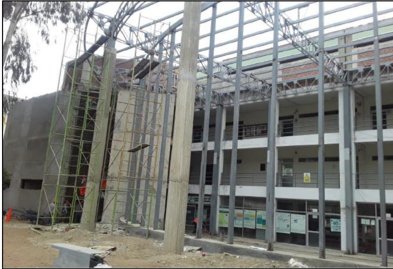
Figura 22: Colocación de estructura metálica
