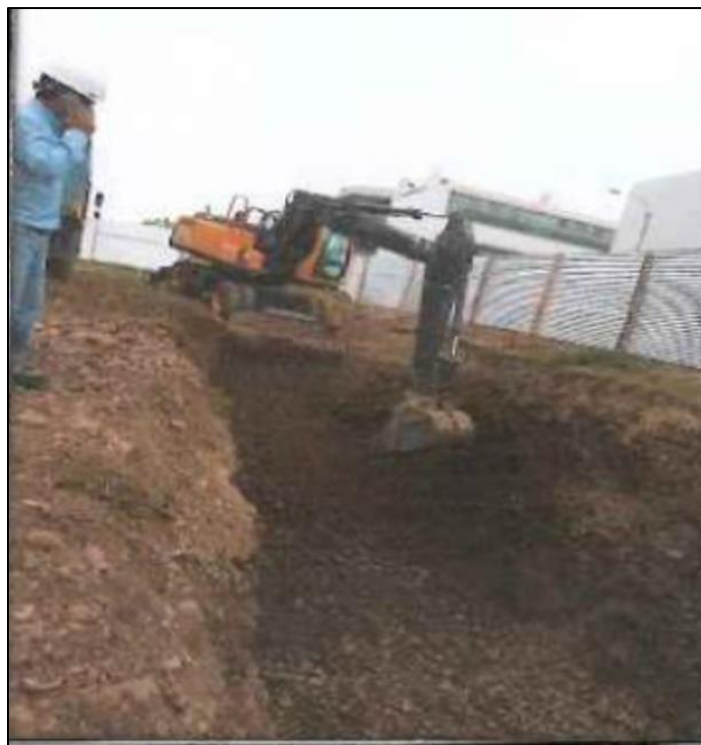
Figura 1. Excavación de estacionamientos y cimentación en obra
