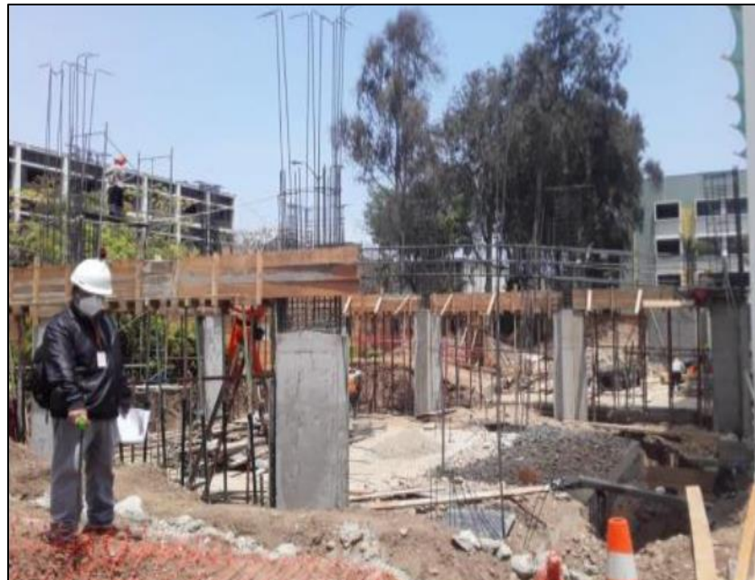
Figura 11: Encofrado de vigas
