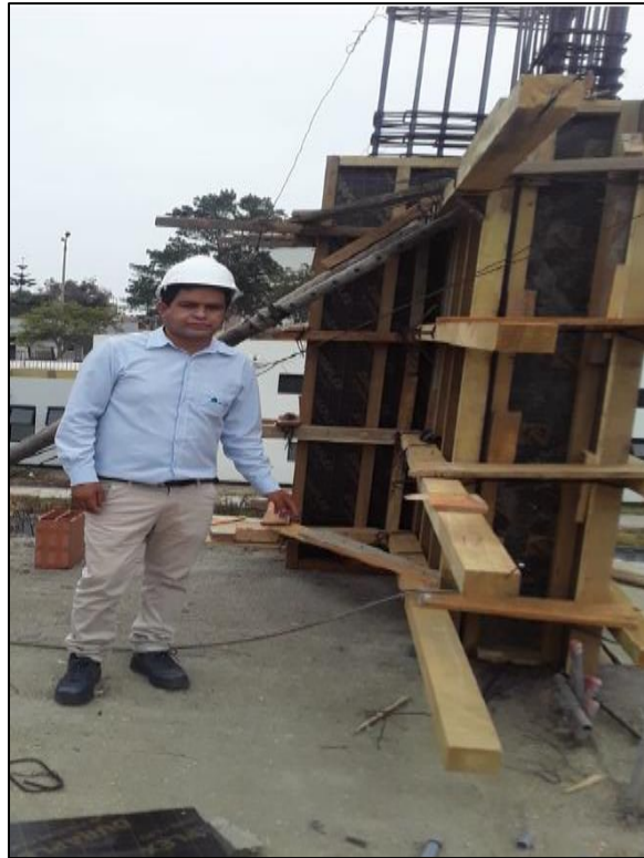
Figura 12: Encofrado de vigas
