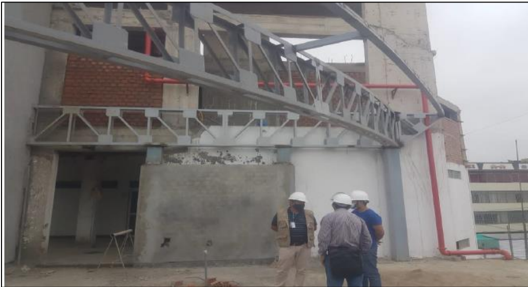
Figura 21: Colocación de estructura metálica
