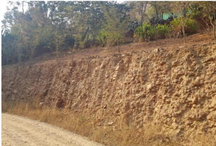
*Figura 21.* Zona de arranque de derrumbe en el área de estudio
