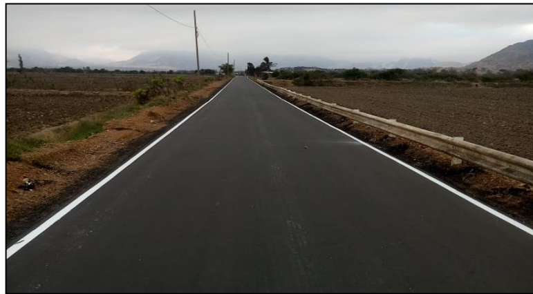
Figura 9. Construcción de la carretera vecinal Campanita – San José
