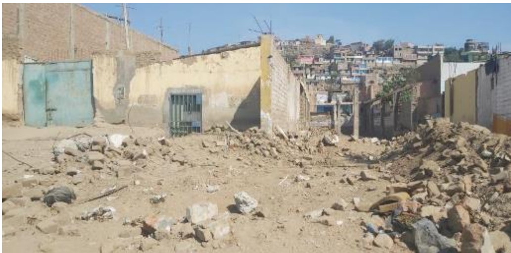
Figura 11 Daño de las viviendas, vías inservibles.
