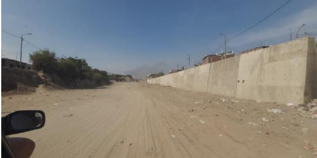
Figura 10 Protección construida de la época.
