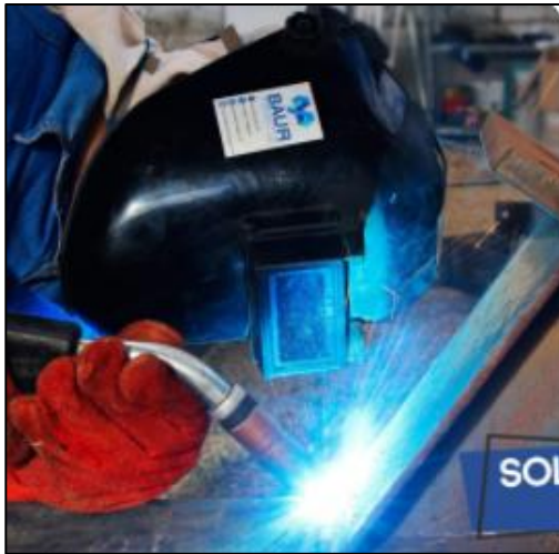
Figura 2. Trabajos de soldadura MIG.
