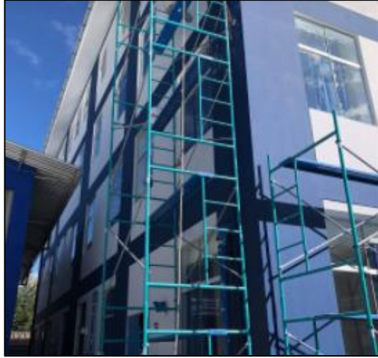
Figura 4. Trabajos de alquiler de andamios metálicos.
