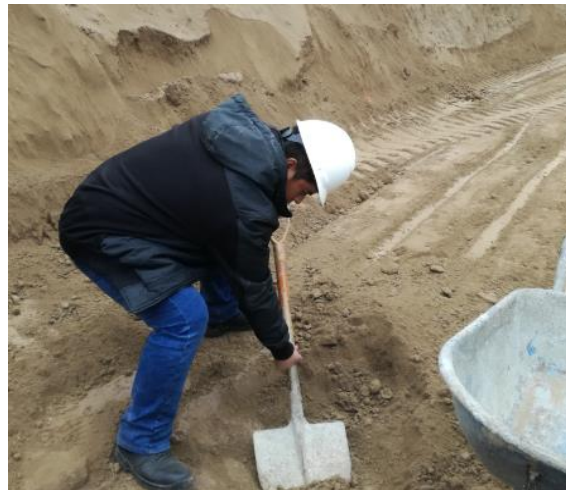
Figura 15. Excavación de Calicatas.
