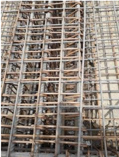
Figura 4. Presencia de expansión del suelo arcillas, en la base inferior del enmallado de acero. Fuente: Propia.
