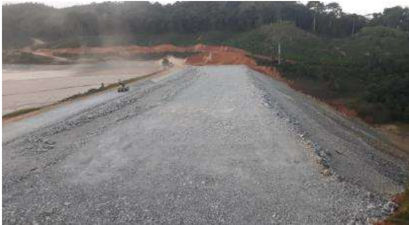
Figura 19. Conformación de transición en dique principal Fuente: BISA (2018)
