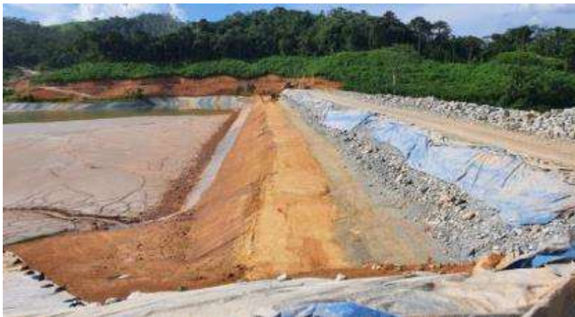
Figura 18. Conformación de capa de arcilla en dique principal Fuente: BISA (2018)
