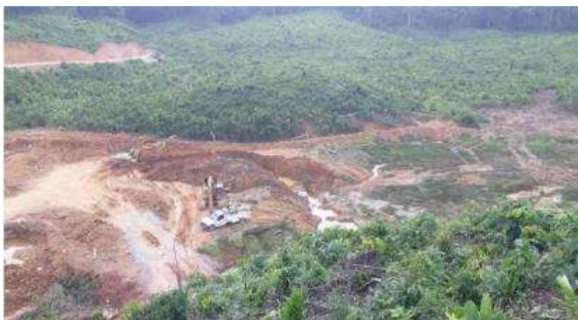
Figura 17. Trabajos de desbroce y eliminación de capa orgánica Fuente: BISA (2018)
