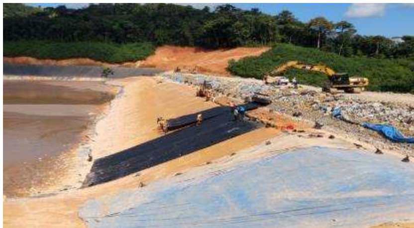
Figura 20. Conformación del dique principal para instalar geomembrana Fuente: BISA (2018)
