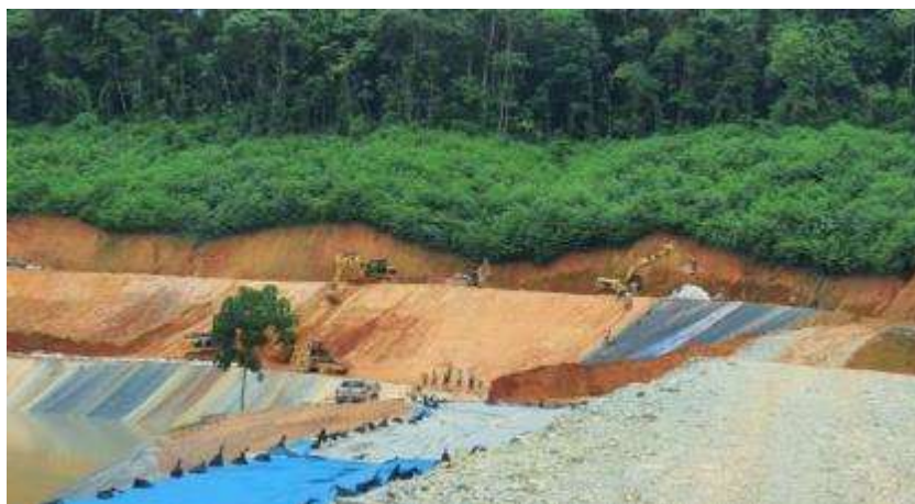
Figura 21. Conformación de área para instalar geomembrana Fuente: BISA (2018)
